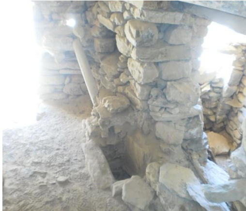
Εικ. 36. :Μπατικός τρόπος δόμηση σε άνοιγμα. Πηγή : Προσωπικό αρχείο.
