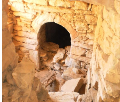
Εικ. 37. : Τοξωτό άνοιγμα που το ανώφλι διαμορφώνεται από δύο λίθους. Πηγή : Προσωπικό αρχείο.
