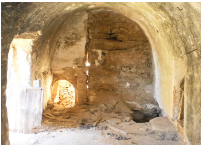
Εικ. 103. : Βόρεια τοιχοποιία ανωγιού, κατοικίας 2. Πηγή : Προσωπικό αρχείο.
