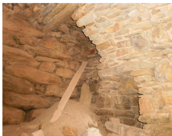
Εικ. 101. : Μέρος Ανατολικής τοιχοποιίας κατωγιού, κατοικίας 2. Πηγή : Προσωπικό αρχείο.
