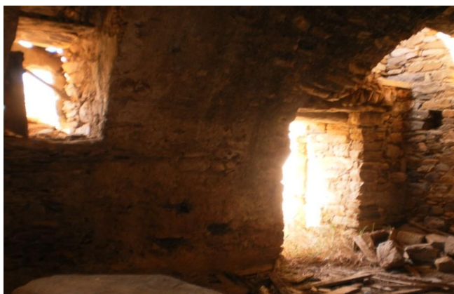
Εικ. 97. : Νότια τοιχοποιία ανωγιού, πύργου κατοικίας. Πηγή : Προσωπικό αρχείο.
