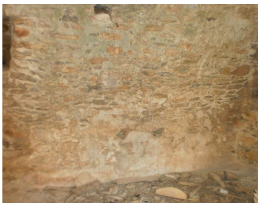
Εικ. 96. :Βόρεια τοιχοποιία ανωγιού, πύργου κατοικίας. Πηγή : Προσωπικό αρχείο.
