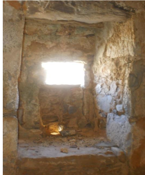
Εικ. 144. : Εσωτερικό πετρομάχου. Πηγή : Προσωπικό αρχείο.
