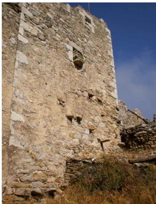
Εικ. 122. : Ανατολική όψη πύργου. Πηγή : Προσωπικό αρχείο.
