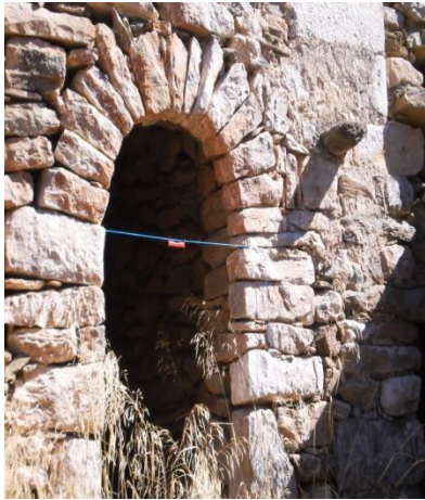
Εικ. 72. : Τρόπος αποτύπωσης θολωτού ανοίγματος. Πηγή : Προσωπικό αρχείο.
