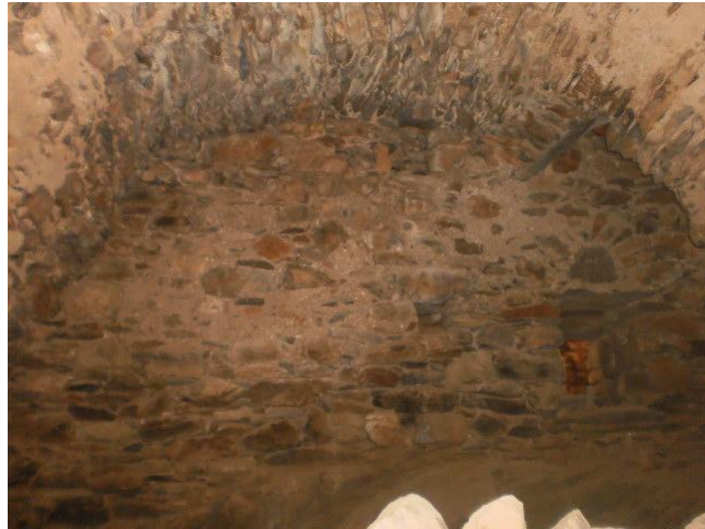
Εικ. 91. : Δυτική τοιχοποιία κατωγιού, πυργοκατοικίας. Πηγή : Προσωπικό αρχείο.
