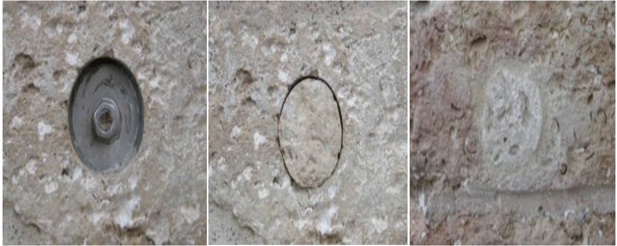
Εικ. 160. : Τρόπος μη εμφανής χρήση μεταλλικών ελκυστήρων. Πηγή : Πέτρος Μ. Κουφόπουλος : "Διαχείριση Μνημείων: Αρχαιολογία, Πόλη και Αρχιτεκτονική".
