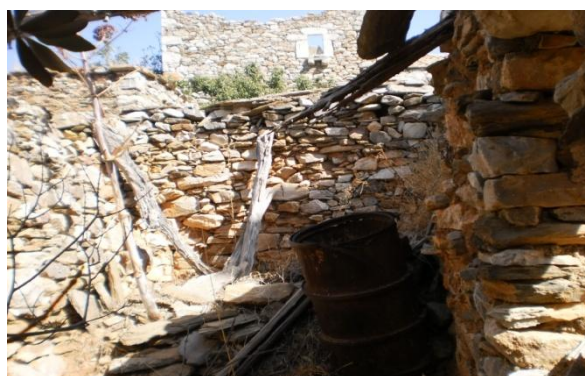
Εικ. 117. : Βόρεια τοιχοποιία κατοικίας 3. Πηγή : Προσωπικό αρχείο.
