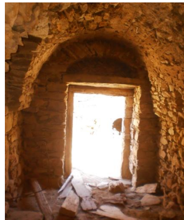
Εικ. 34. : Καμάρα που εδράζεται σε παλαιότερη τοιχοποιία. Πηγή : Προσωπικό αρχείο.
