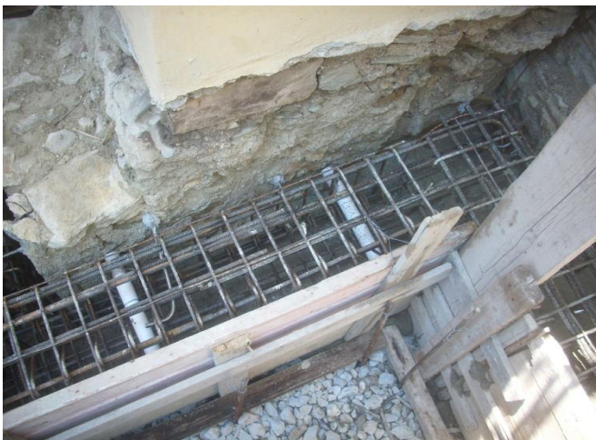
Εικ. 155. : Τρόπος ενίσχυσης θεμελίων. Πηγή : http://www.alfakat.gr/gr/projects/39_Kimi.htm .
