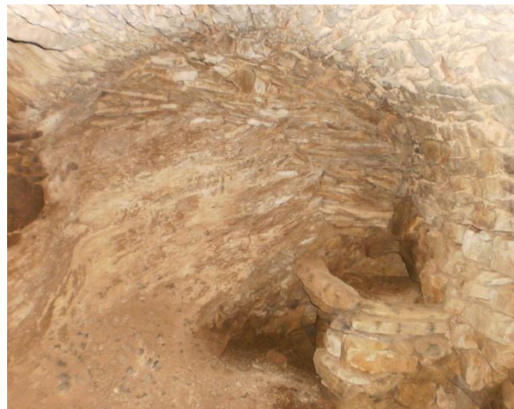
Εικ. 112. : Βόρεια τοιχοποιία ανεξάρτητου κατωγιού του λιακού 2. Πηγή : Προσωπικό
