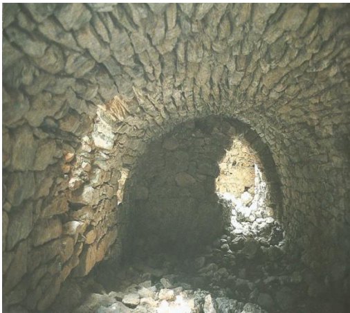
Εικ. 33. : Καμάρα με σφηνοειδής λίθους. Πηγή : Ν. Βασιλάτος, "Οι πύργοι της Μάνης φρουροί από πέτρα", σελίδα 188.
