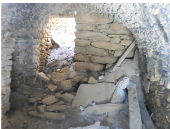
Εικ. 100. :Βόρεια τοιχοποιία κατωγιού, κατοικίας 2. Πηγή : Προσωπικό αρχείο.
