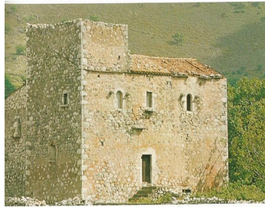
Εικ. 30. : Κατοικία με Δίρριχτη στέγη και υπερυψωμένο δώμα. Πηγή : Γ. Σαϊτάς, "Ελληνική παραδοσιακή αρχιτεκτονική Μάνη", σελίδα 128.
