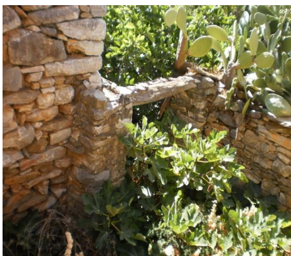
Εικ. 136. : Είσοδος στον υπαίθριο χώρο 2. Πηγή : Προσωπικό αρχείο.
