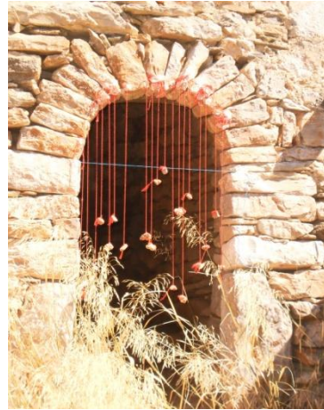
Εικ. 73. : Τρόπος αποτύπωσης θολωτού ανοίγματος. Πηγή : Προσωπικό αρχείο.
