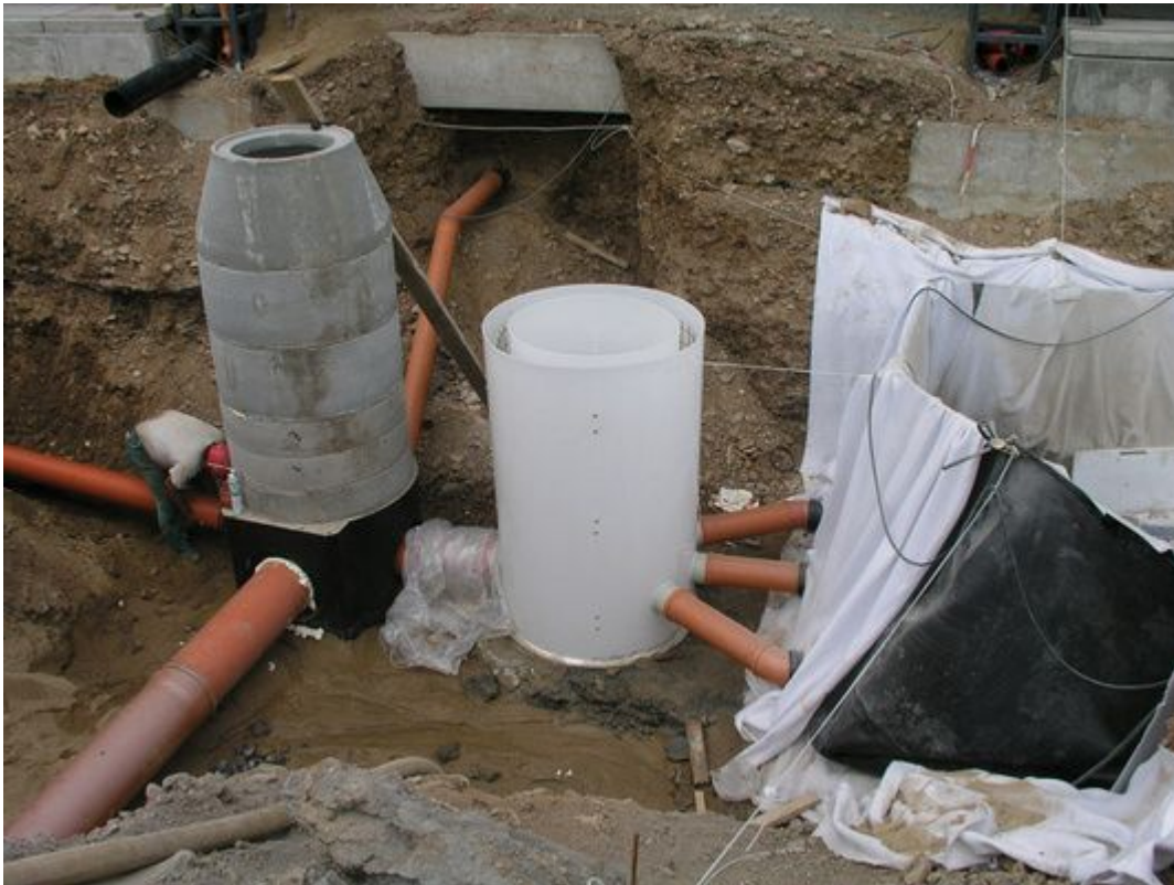
Εικόνα 7: Αποψη φρεατίου συμβολής [Διαδίκτυο 5]
