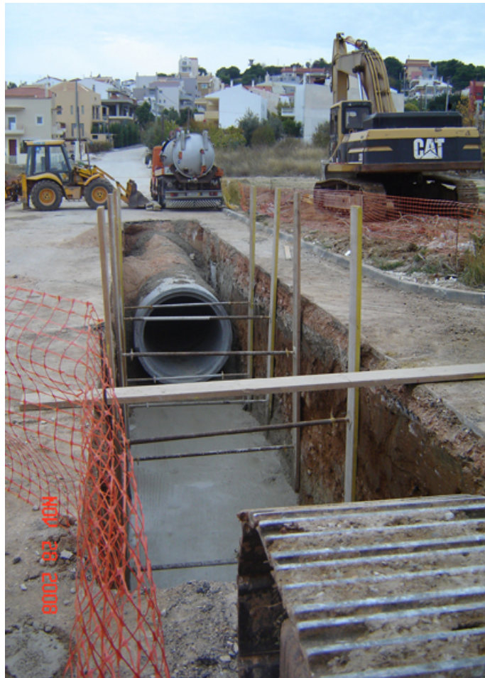
Εικόνα 1: Άποψη τμήματος δικτύου αποχέτευσης ομβρίων στη φάση της κατασκευής [Διαδίκτυο 1]
