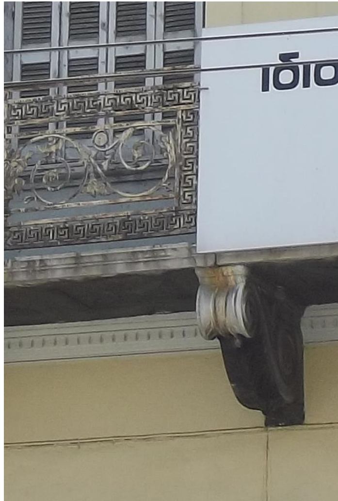
Εικόνα 44. Αιθάλη φουρουσιού και οξειδωμένο κιγκλίδωμα
