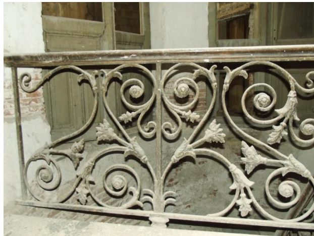
Εικόνα 22. Λεπτομέρεια κιγκλιδώματος στον όροφο
