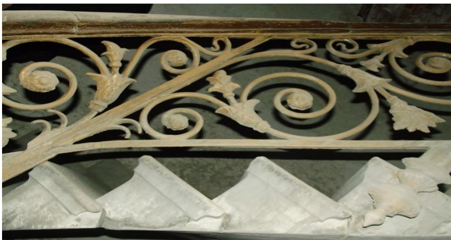
Εικόνα 120. Λεπτομέρεια κιγκλιδώματος κύριας κλιμακας
