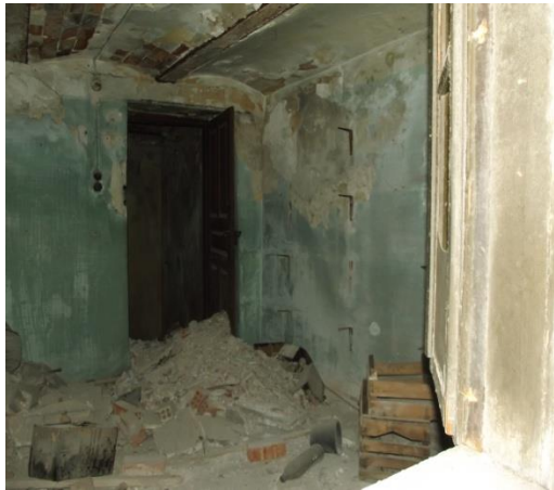
Εικόνα 69. Άποψη χώρου [Χ.Ν]
