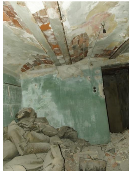
Εικόνα 70. Άποψη χώρου [Χ.Ν]
