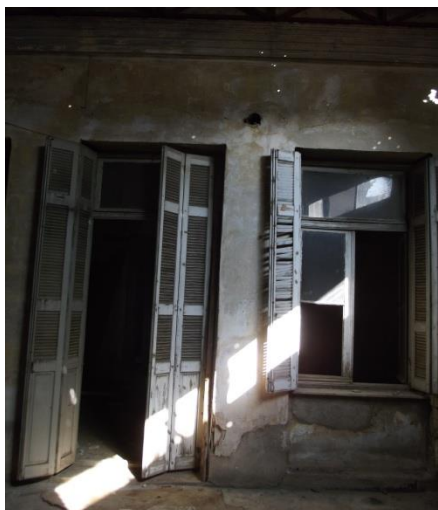
Εικόνα 76. Άποψη χώρου [Δ.Θ]
