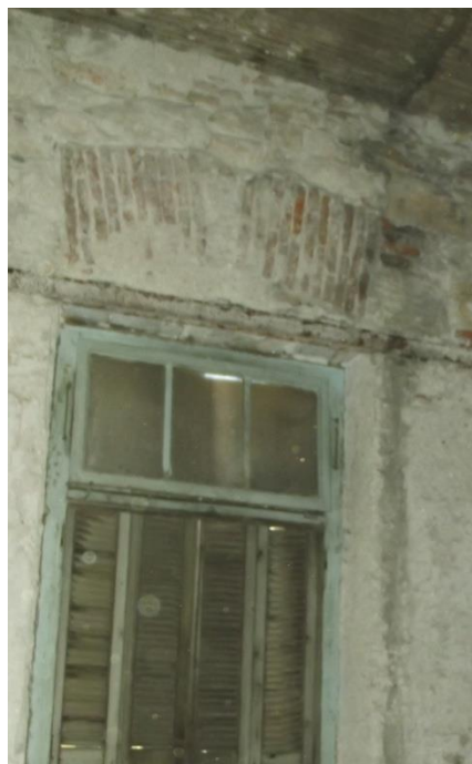
Εικόνα 119. Ανακουφιστικό τόξο τοιχοποιίας
