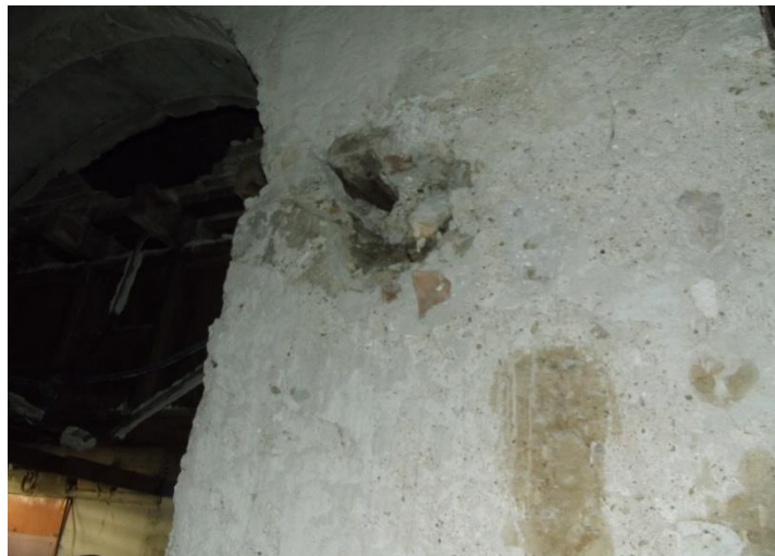
Εικόνα 38. Δοκοθήκη στον χώρο Ψ
