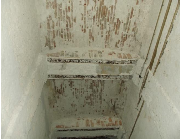
Εικόνα 27. Δοκάρια κεντρικού κλιμακοστασίου
