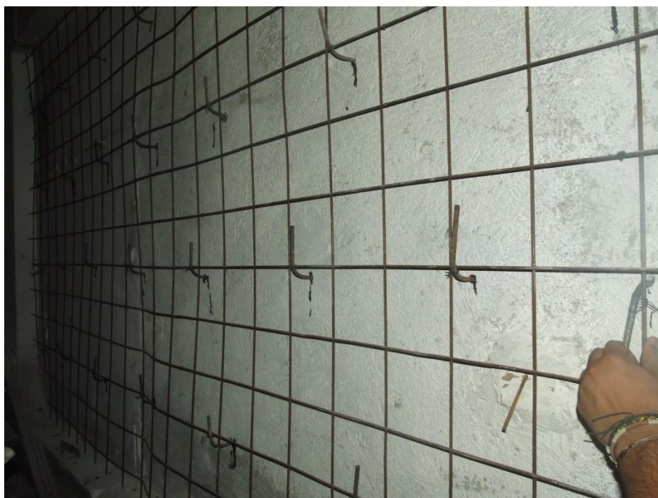
Εικόνα 39. Μεταλλικό πλέγμα ενίσχυσης
