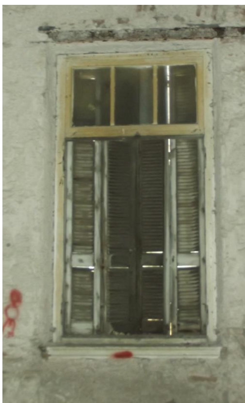
Εικόνα 43. Καταστροφή κουφώματος
