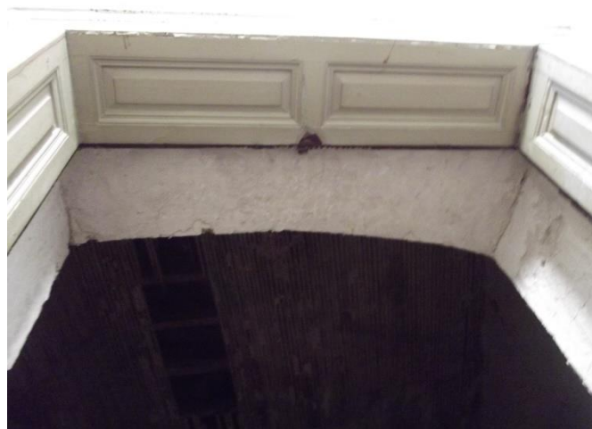
Εικόνα 35. Ταμπλαδωτό κούφωμα
