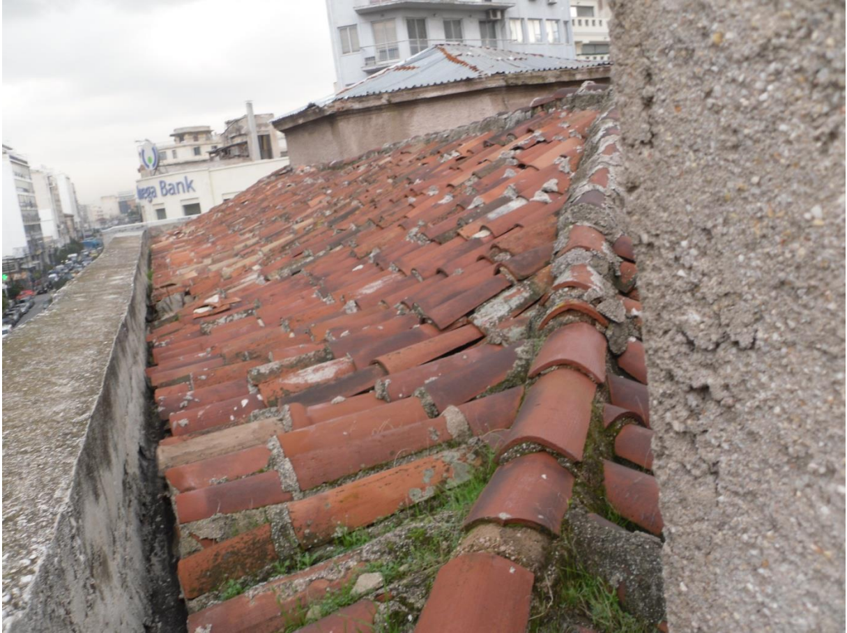
Εικόνα 41. Ανάπτυξη μικροχλωρίδας λόγω κακής απομάκρυνσης ομβρικών υδάτων
