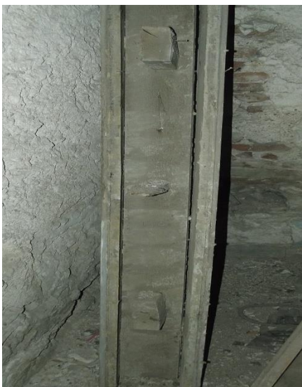
Εικόνα 34. Σύνδεση κουφώματος-τοιχοποιίας
