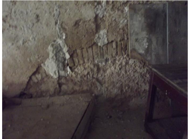
Εικόνα 10. Τοξωτό κτισμένο άνοιγμα
