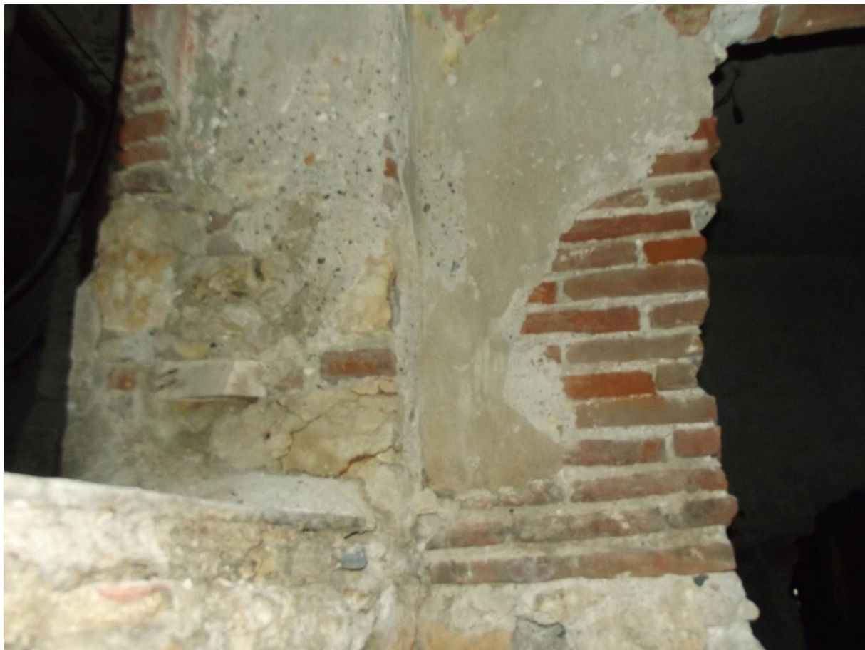
Εικόνα 25. Διαφοροποίηση υλικών στην τοιχοποιία
