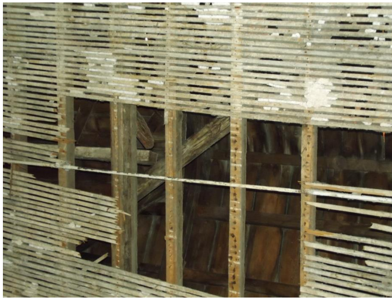
Εικόνα 33. Διάταξη ζευκτών αίθουσα Z
