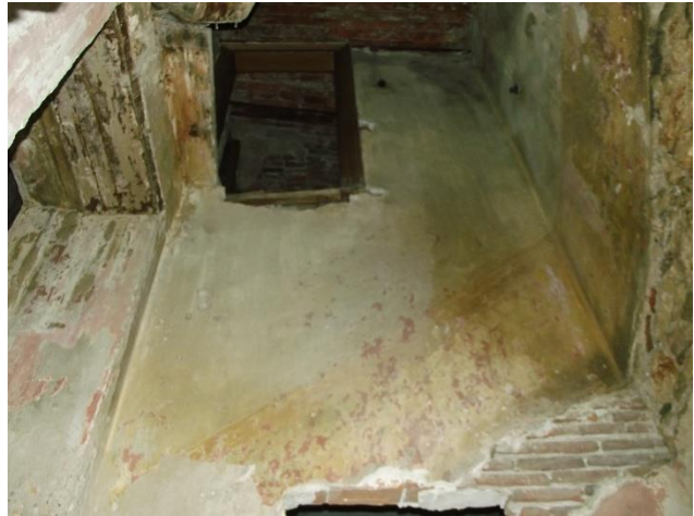
Εικόνα 13. Ένδειξη ύπαρξης βοηθητικής κλίμακας
