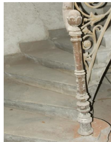
Εικόνα 23. Απόληξη κουπαστής
