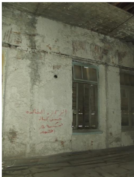
Εικόνα 80. Άποψη πτέρυγας Α
