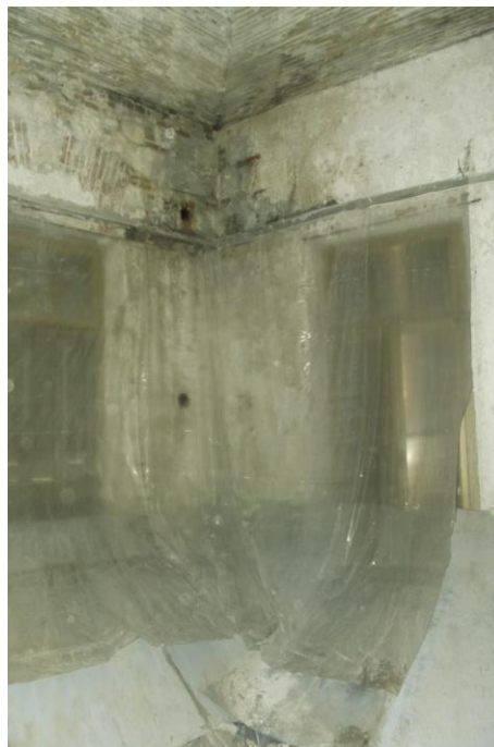
Εικόνα 91. Άποψη πτέρυγας Α
