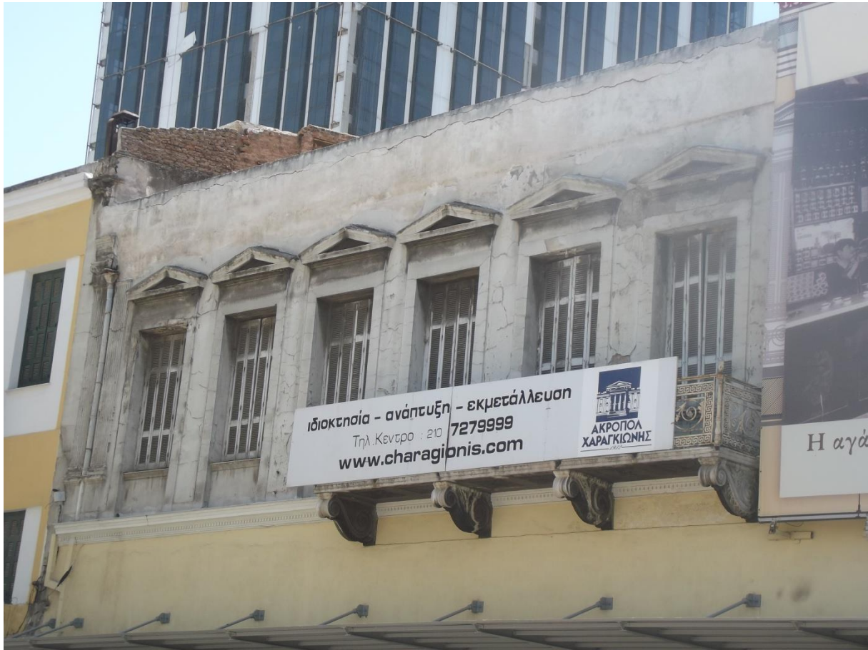
Εικόνα 116. Τμήμα όψης επί της οδού Τσαμαδού
