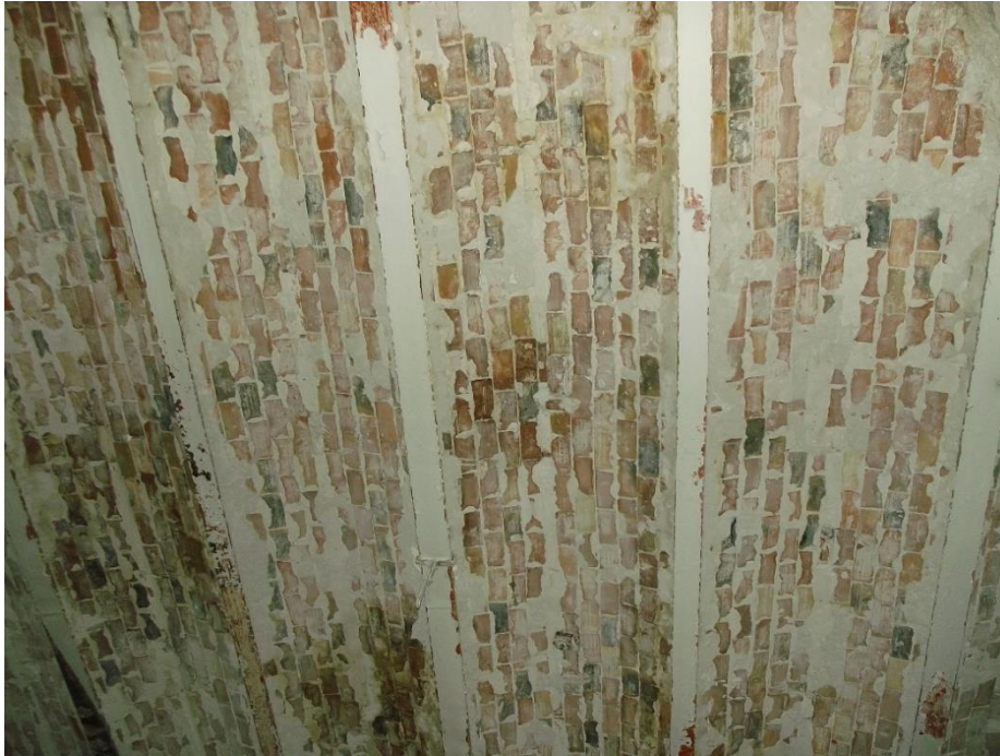
Εικόνα 26. Πολυθολωτό σύστημα Καππέν
