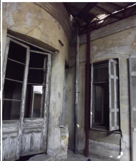
Εικόνα 75. Άποψη χώρου [Δ.Θ]
