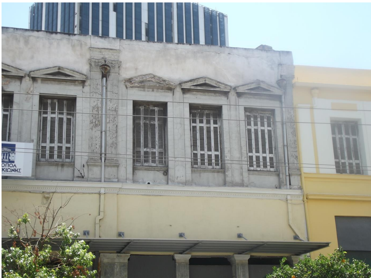
Εικόνα115. Τμήμα κύριας όψης επί της οδού Γούναρη
