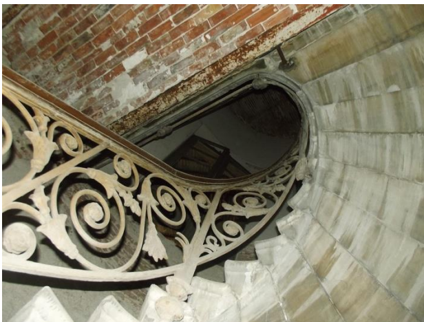
Εικόνα 21. Άποψη μαρμάρινης αρθρωτής κλίμακας
