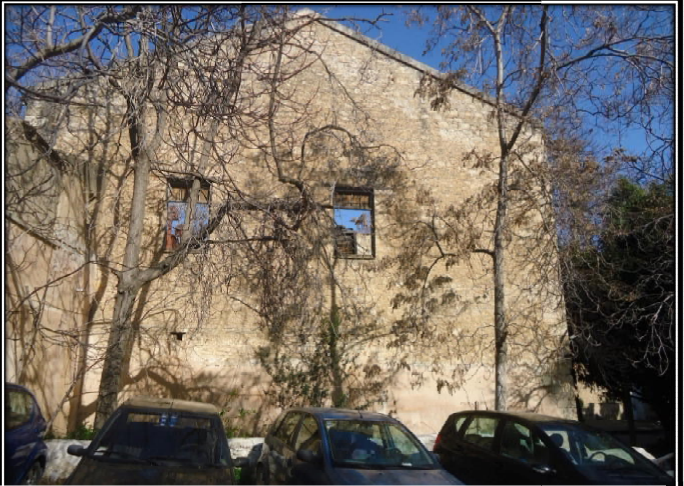
ΦΩΤΟΓΡΑΦΙΑ 2-15 ΒΟΡΕΙΑ ΟΨΗ ΚΤΙΡΙΟΥ Α
