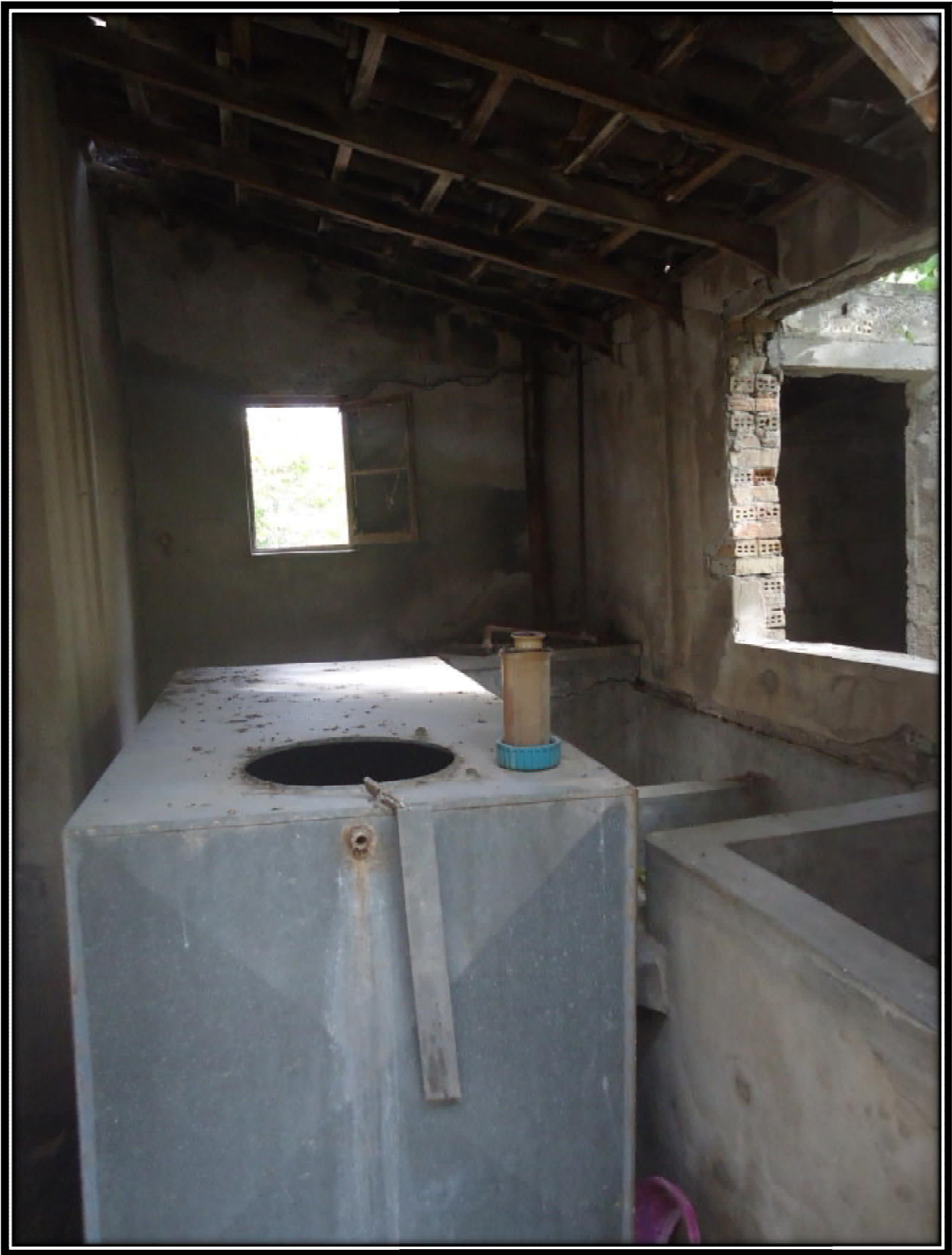
5.11.1. Χώρος Β9 Ανάπτυγμα Β9.1 Δάπεδο
