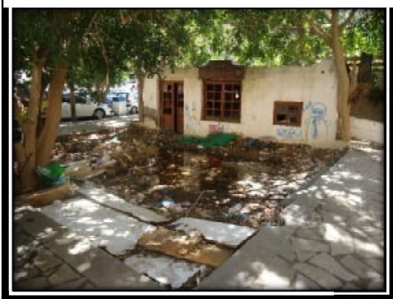
ΦΩΤΟΓΡΑΦΙΑ 2-14 ΥΠΑΡΧΟΥΣΑ ΚΑΤΑΣΤΑΣΗ ΑΝΑΨΥΚΤΗΡΙΟΥ
