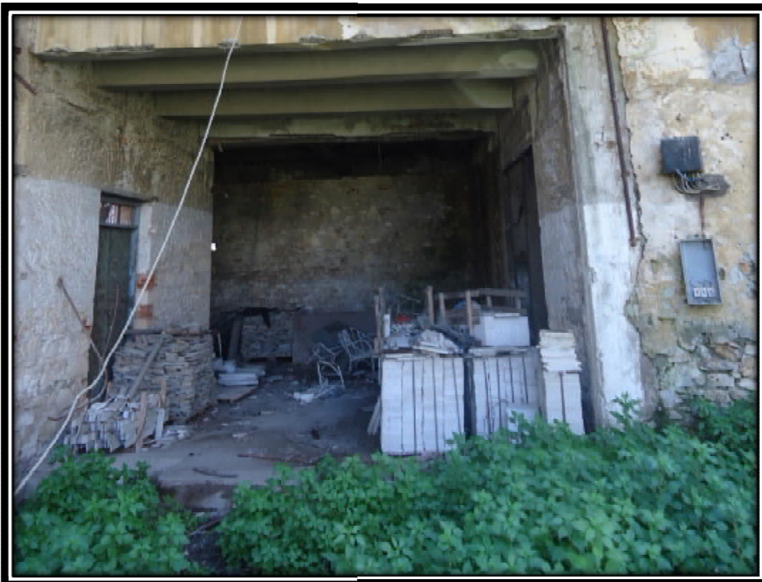
ΦΩΤΟΓΡΑΦΙΑ 4-2 ΦΘΟΡΕΣ ΣΤΗΝ ΛΙΘΟΠΟΙΑ ΛΟΓΩ ΥΠΑΡΕΞΗΣ ΤΗΣ ΥΓΡΑΣΙΑΣ
