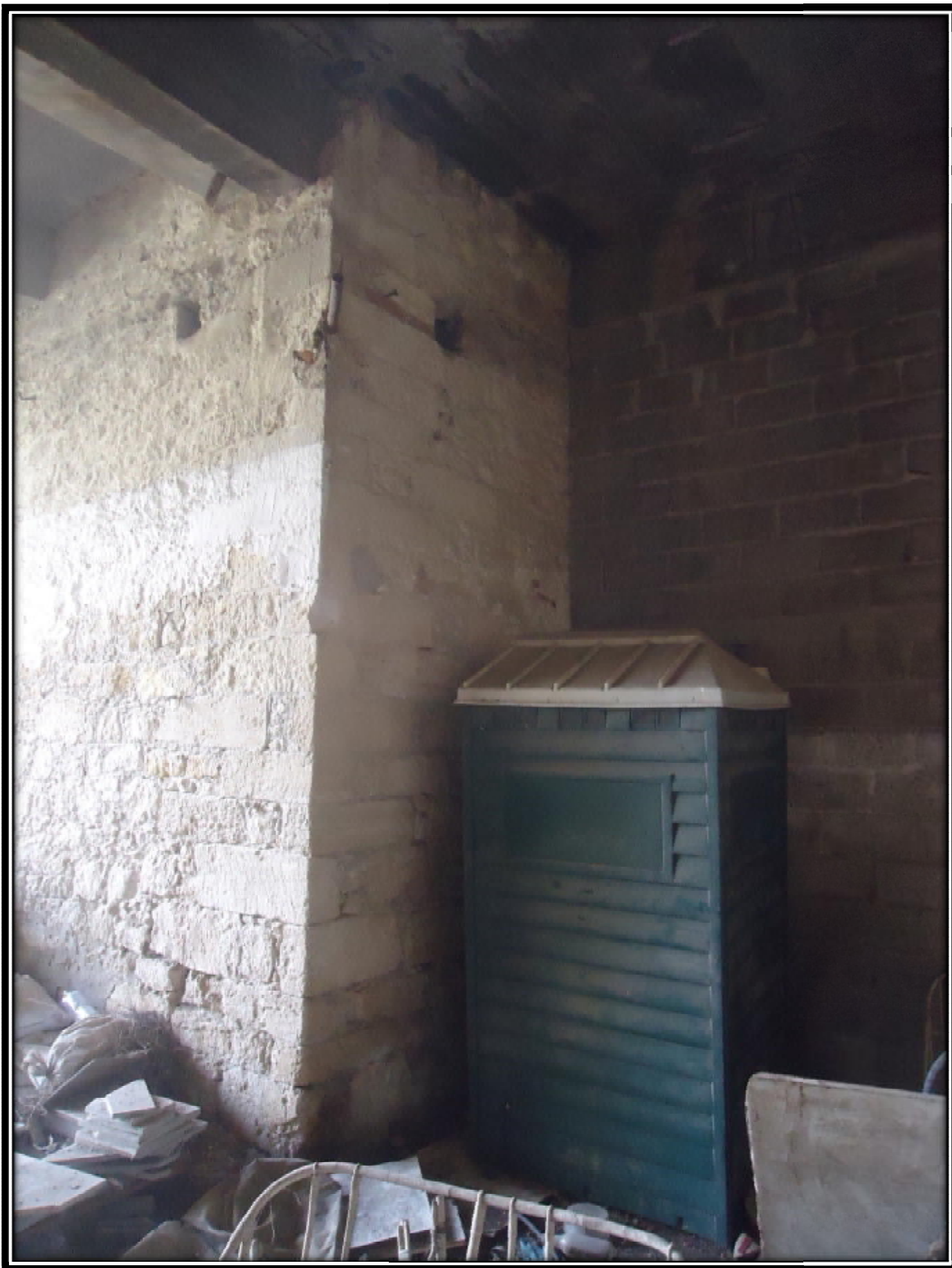
4.1.3.1. Χώρος ΒΙ 1 ανάπτυγμα ΒΙ 1.1 Δάπεδο
