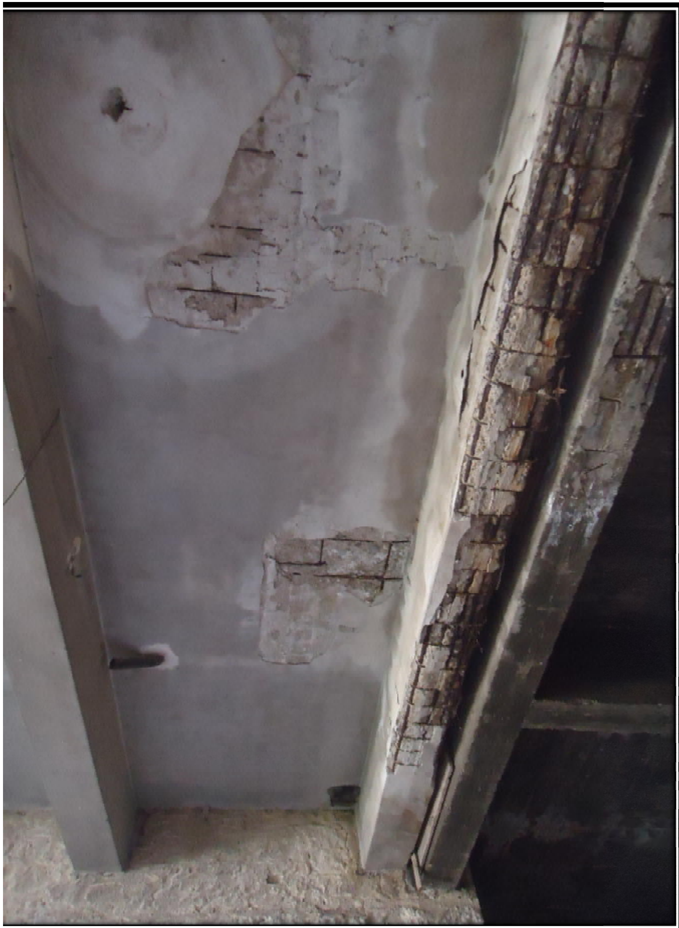
4.1.5.1. Χώρος ΒΙ2 ισόγειο ανάπτυγμα ΒΙ 2.1 Δάπεδο
