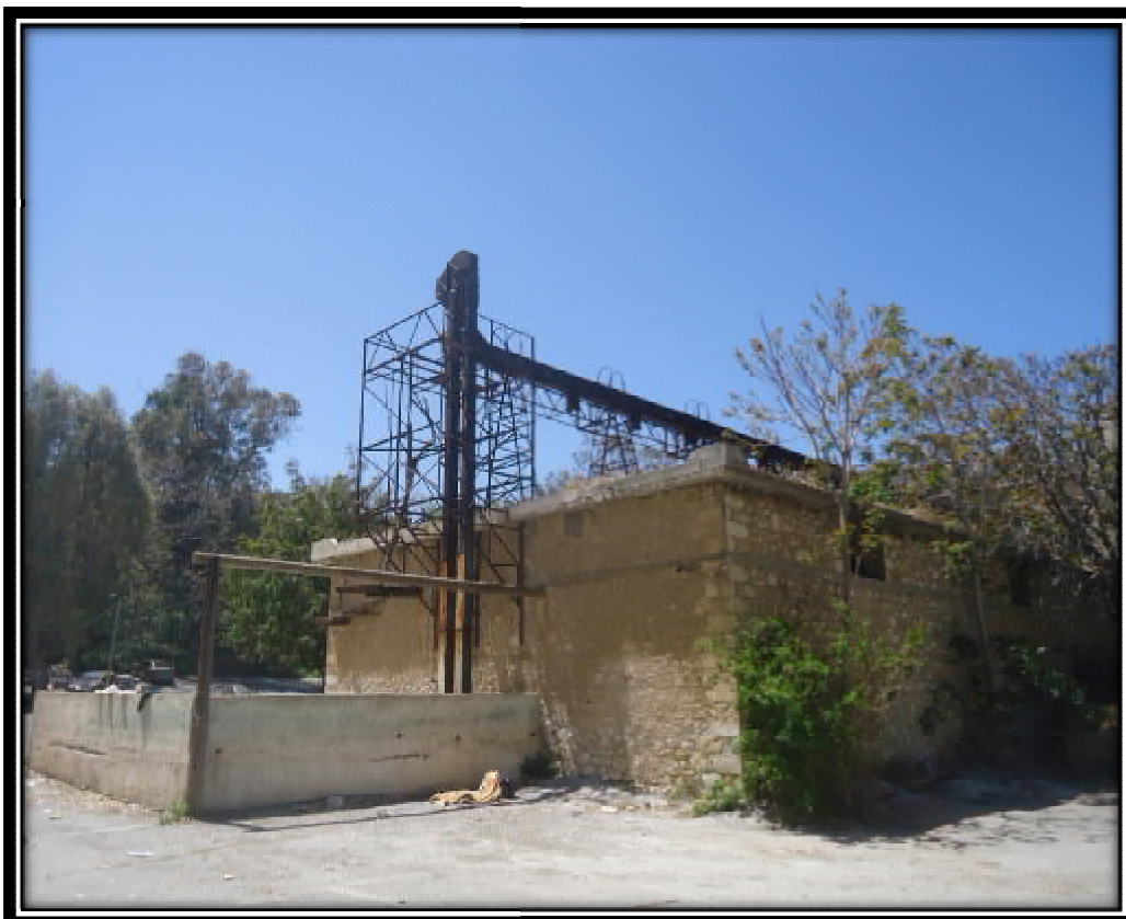
ΦΩΤΟΓΡΑΦΙΑ 6-1 ΔΥΤΙΚΗ ΟΨΗ ΚΤΙΡΙΟΥ Γ
