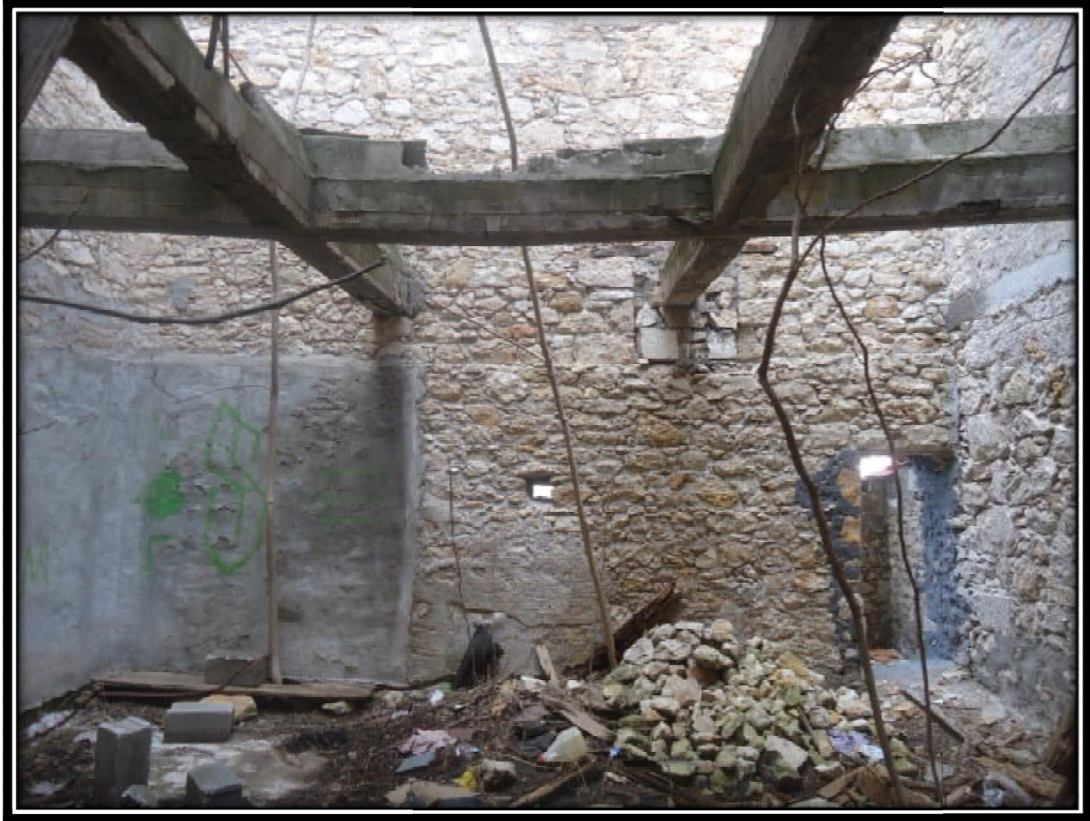
ΦΩΤΟΓΡΑΦΙΑ 3-4 ΠΡΟΣΘΗΚΕΣ ΑΠΟ ΕΥΤΕΛΗ ΥΛΙΚΑ ΚΑΙ ΑΠΟΚΟΛΛΗΣΗ ΟΠΛΙΣΜΕΝΟΥ ΣΚΥΡΟΔΕΜΑΤΟΣ ΤΗΣ ΔΟΚΟΥ
