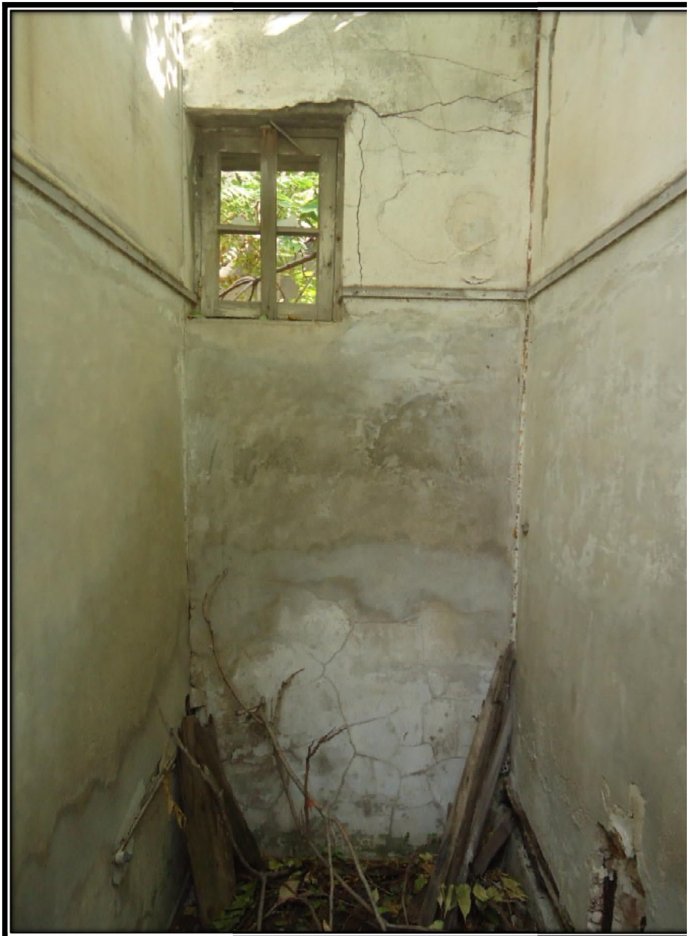
5.7.1. Χώρος Β5 Ανάπτυγμα Β 5.1 Δάπεδο
