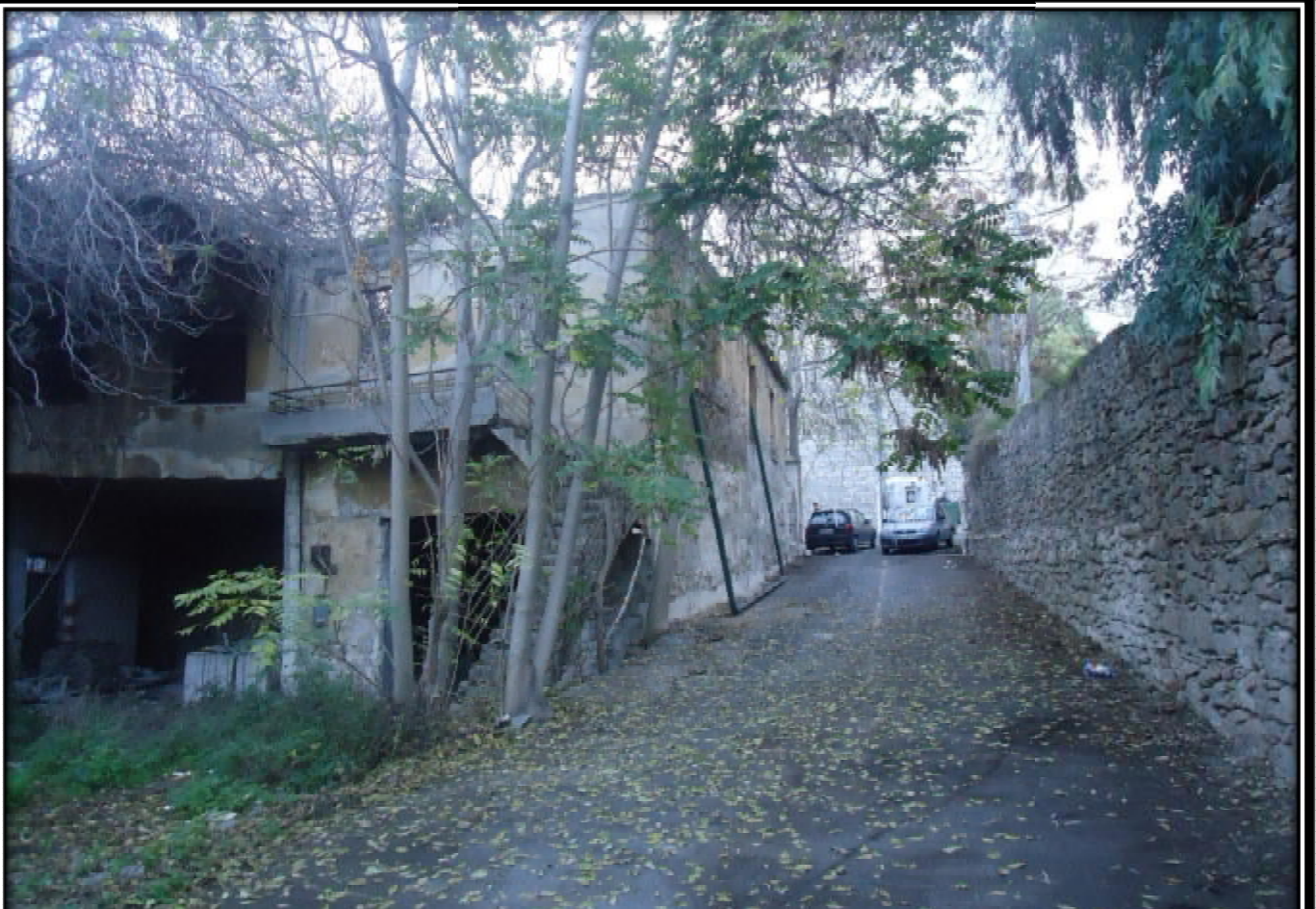
ΦΩΤΟΓΡΑΦΙΑ 2-16 ΕΙΣΟΔΟΣ ΠΡΟΣ ΤΗΝ ΒΟΡΕΙΑ ΟΨΗ ΚΤΙΡΙΟΥ Β
