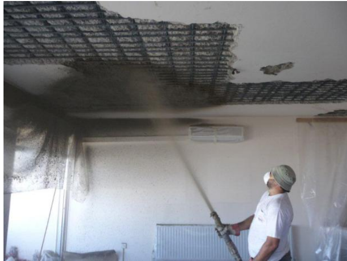
Εικόνα 5.2 Τοποθέτηση προστατευτικού επιστρώματος. [12]
