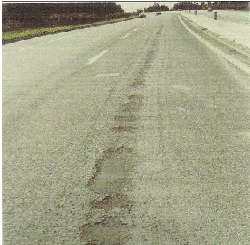
Εικόνα 1.13 Απογύμνωση αδρανών στην επιφάνεια ασφαλτοτάπητα [4,5].
