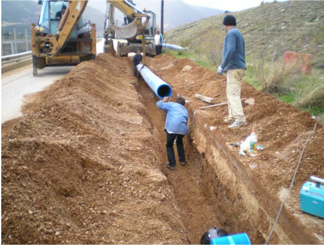
Εικόνα 1.4 Τοποθέτηση αγωγού κατά μήκος δρόμου εντός διανοιγμένης τάφρου [19].
