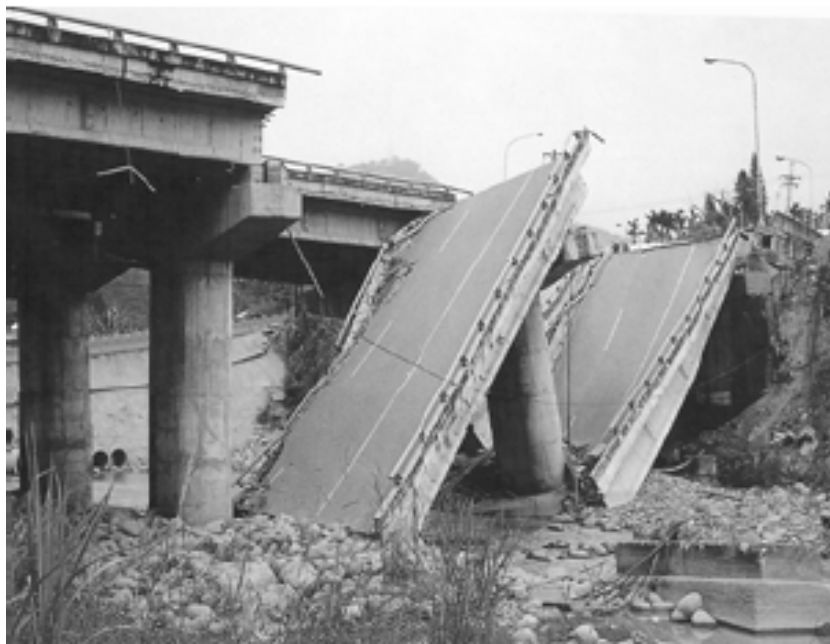
Εικόνα 1.5 Αστοχία λόγω απώλειας στήριξης [3].
