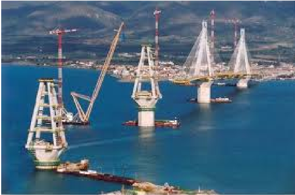
Εικόνα 1.2 Κατασκευή βάθρων και καταστρώματος γέφυρας Ρίου – Αντιρρίου [17].
