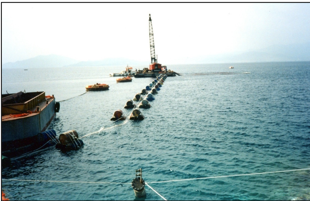
Εικόνα 1.3 Τοποθέτηση στοιχείων από σκυρόδεμα εντός της οριοθετημένης θαλάσσιας περιοχής για την κατασκευή κυματοθραύστη [18].
