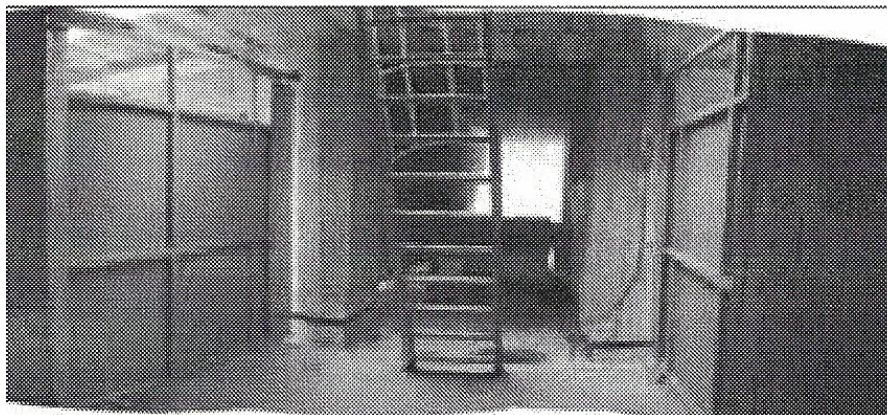
Εικόνα 3.9 Πλατφόρμα πρόσβασης στην κορυφή του πυλώνα της 2ης Χαραδρογέφυρας παράκαμψης Καβάλας [9].
