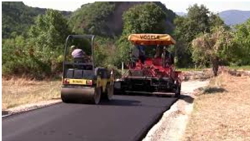
Εικόνα 1.1 Τυπικό έργο οδοποιίας - διάστρωση ασφαλτικής στρώσης (finisher) και συμπύκνωση αυτής (οδοστρωτήρας) [16].
