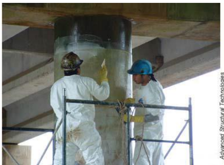
Εικόνα α: Εργάτες τοποθετούν δύο τμήματα περικαλύμματος ινοπλισμένου πολυμερούς από υαλονήματα σε ένα υποστύλωμα
