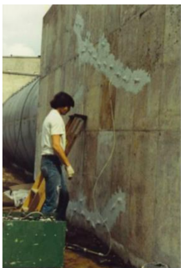
Εικόνα: Εφαρμογή ρητινένεσης για την ενίσχυση και αποκατάσταση των ρωγμών.
