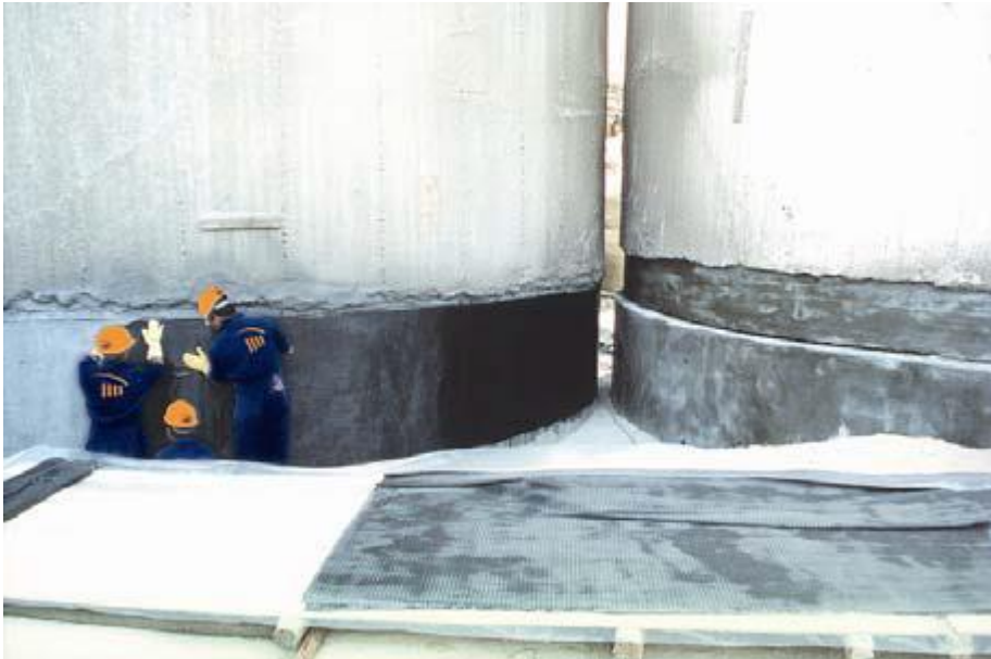
Εικόνα: Ενίσχυση δομικού μέλους με ελάσματα από σύνθετα υλικά από ινοπλισμένα πολυμερή.
