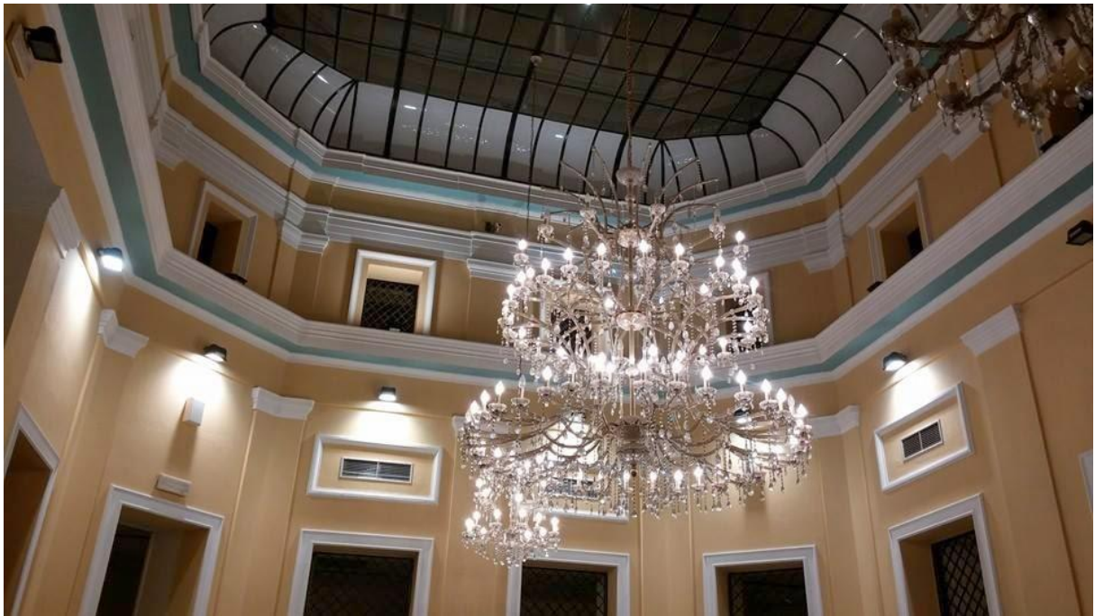
Εσωτερική άποψη της οροφής του κτιρίου.
