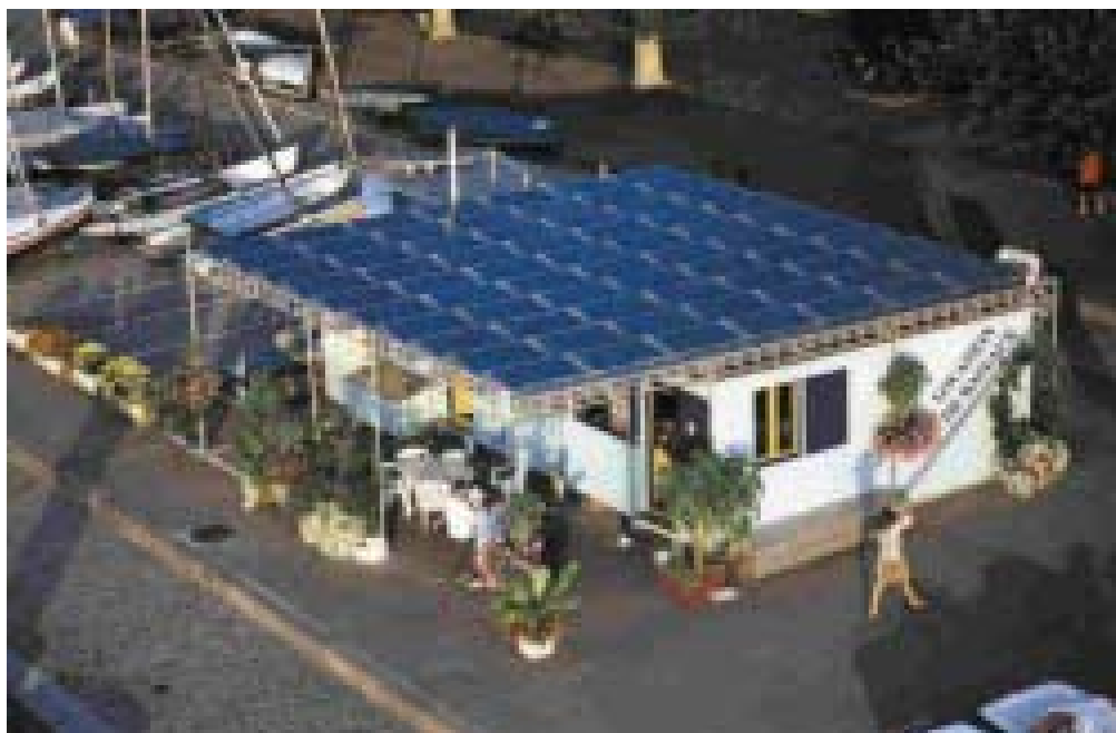
Σχήμα 6.3 Φωτοβολταϊκά πλαίσια σε επίπεδη οροφή οικίας [23].
