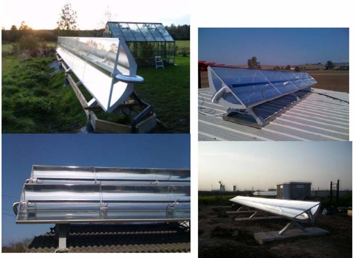
Σχήμα 4.12 Εγκατεστημένες μονάδες του συγκεντρωτικού συστήματος Absolicon X10 [20].
