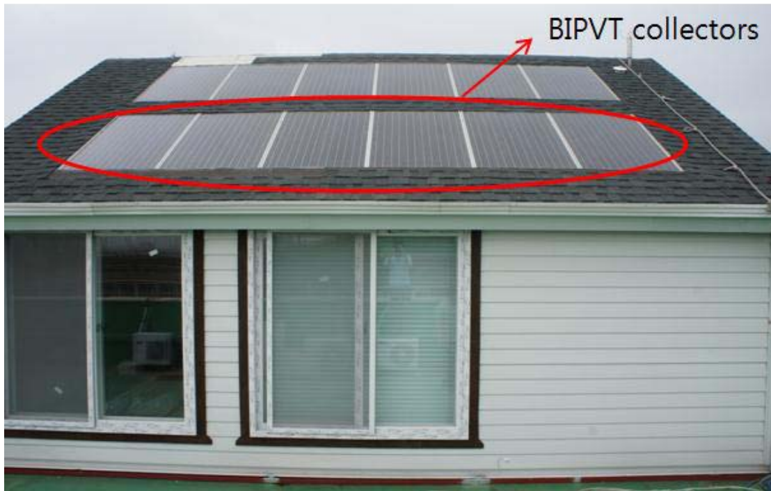
Σχήμα 6.8 Η πειραματική μονάδα BIPVT/w συλλεκτών στην οροφή κτιρίου [21].
