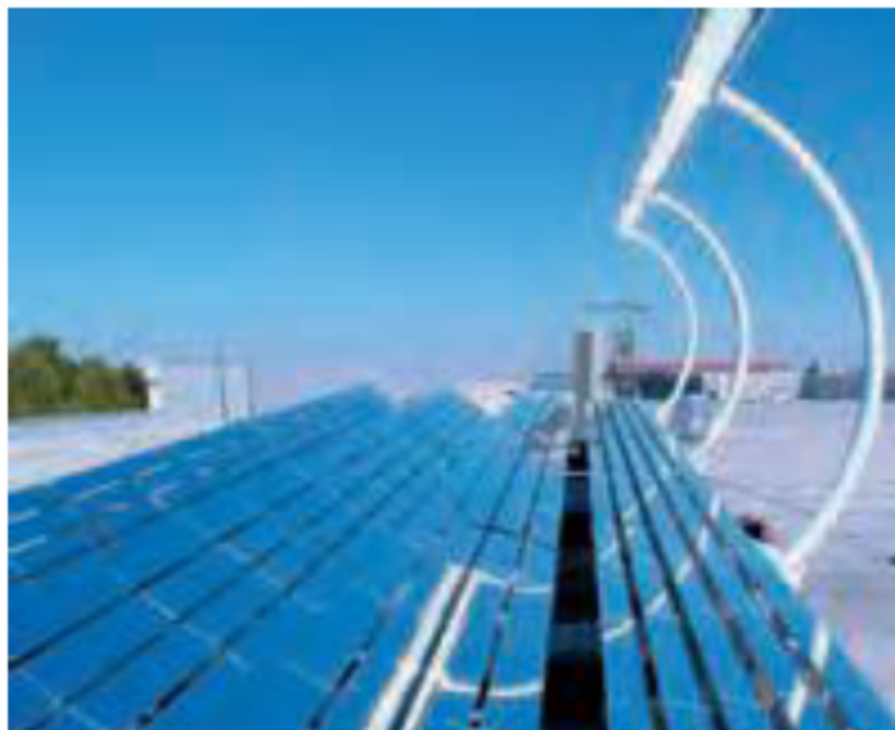
Σχήμα 4. 9 Το συγκεντρωτικό ΦΒ/Θ σύστημα της εταιρείας Heliodynamics [9].
