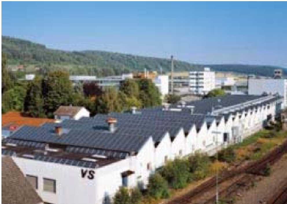
Σχήμα 6.4 Φωτοβολταϊκά πλαίσια σε κεκλιμένη οροφή [23].
