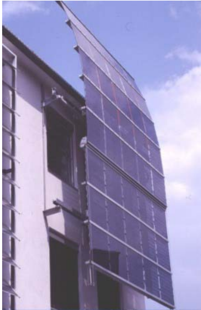
Σχήμα 6.6 Κινούμενο σύστημα σκίασης με τη χρήση φωτοβολταϊκών πλαισίων [23].
