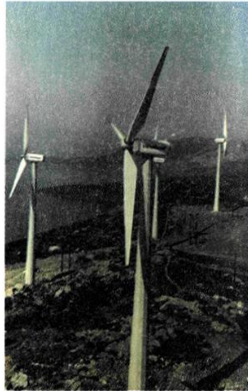
[Εικ. 23] Ανεμογεννήτριες με οριζόντιο άξονα, των οποίων ο δρομέας είναι τύπου έλικα και στις οποίες ο άξονας μπορεί να περιστρέφεται ώστε να βρίσκεται συνεχώς παράλληλα στον άνεμο. Ο άνεμος περνάει μέσα από τα πτερύγια και τα αναγκάζει να κινούνται.
