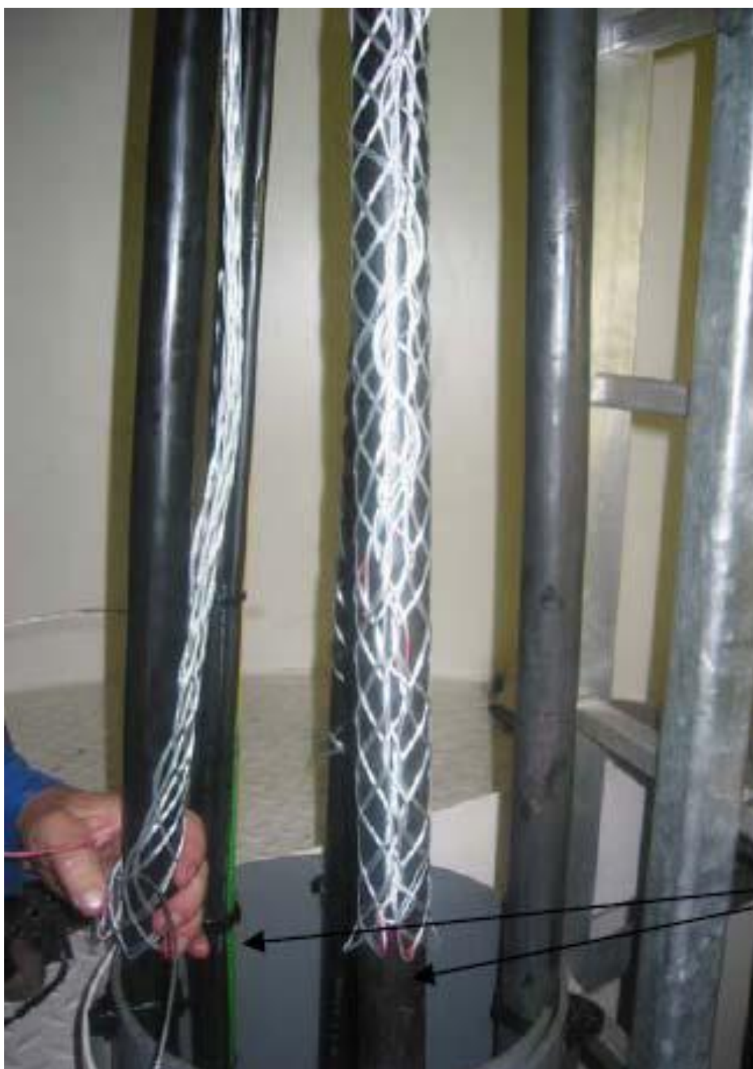
[Εικ. 41] Στήριξη των κεντρικών καλωδίων
