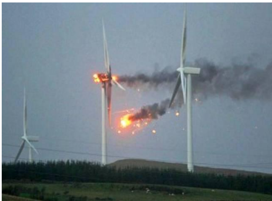
[Εικ. 10] Αιολική τουρμπίνα ισχύος 30 Μεγαβάτ που δεν άντεξε σε ισχυρό άνεμο στο αιολικό πάρκο Ardrossan στη Σκωτία
