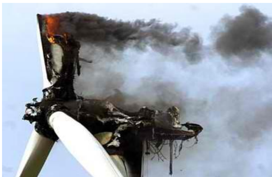
[Εικ. 24] Καμένη ανεμογεννήτρια από κεραυνό
