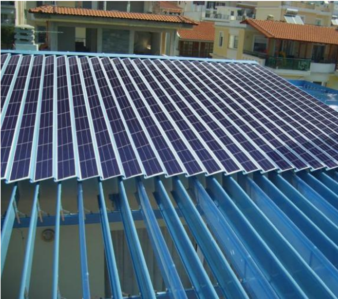
ΕΙΚΟΝΑ 2.8 Ενσωμάτωση φ/β πάνω σε πέργκολες σταθερές ή ανοιγοκλειόμενες
