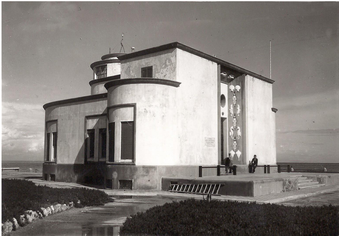
Εικόνα: 4.5 Πλάγια Όψη Υδροβιολογικού Σταθμού Ρόδου (Αρχείο Υ.Σ.Ρ.)
