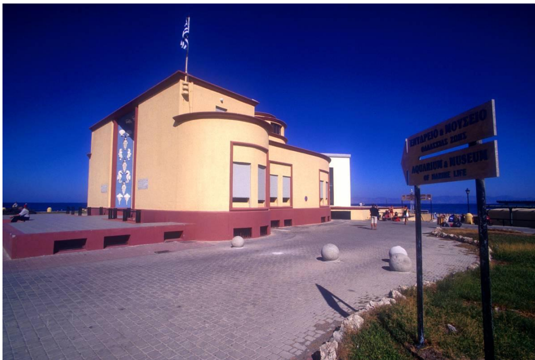
Εικόνα: 4.9 Πλάγια όψη - Είσοδος στον Σταθμό (Αρχείο Υ.Σ.Ρ.)
