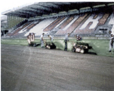
Τοποθέτηση μεγάλων ρολών σε γήπεδο
