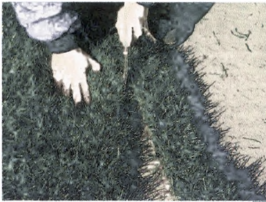
Κοπή ρολού έτοιμου χλοοτάπητα
