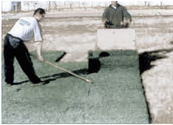
Τοποθέτηση μεγάλων ρολών από εργάτες
