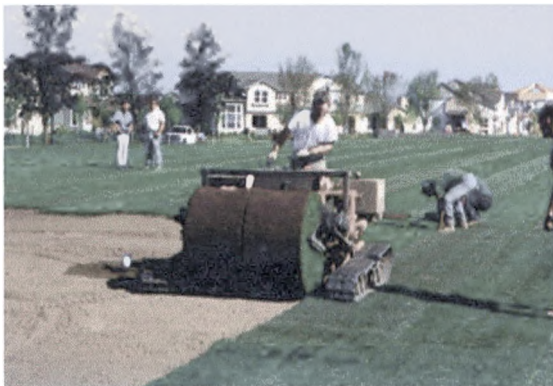
Τοποθέτηση λωρίδων μεγάλου μεγέθους
