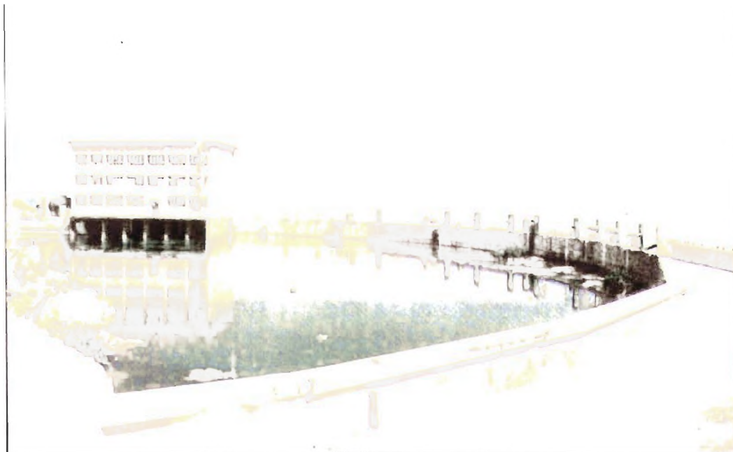
Φράγμα και αντλιοστάσιο πηγών Αναβάλου. (Η ολοκλήρωση του έργου αυτού πιστεύεται ότι θα λύσει το αρδευτικό πρόβλημα της Αργολίδας).
