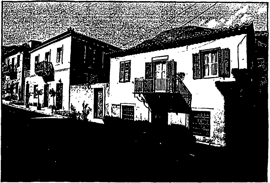
Σπίτια στον Αστακό Traditional houses at Astakos
