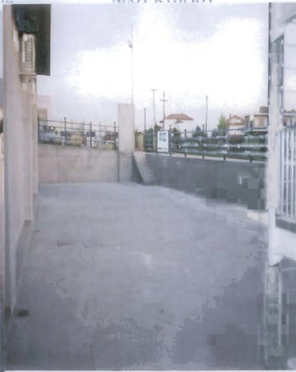
Ο ΧΩΡΟΣ ΣΤΑΘΜΕΥΣΗΣ ΤΟΥ ΣΥΝΕΤΑΙΡΙΣΜΟΥ ΣΤΟ ΝΕΟ ΚΑΤΑΣΤΗΜΑ
