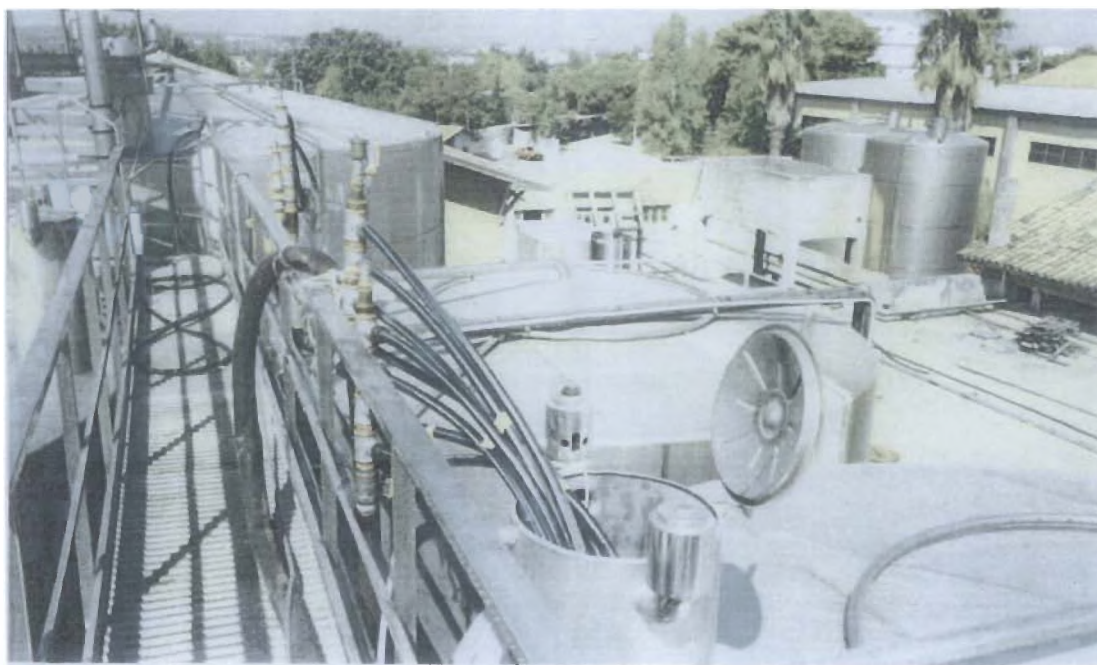
Ανοξειδωτες δεξαμενές γλευκοποίησης
