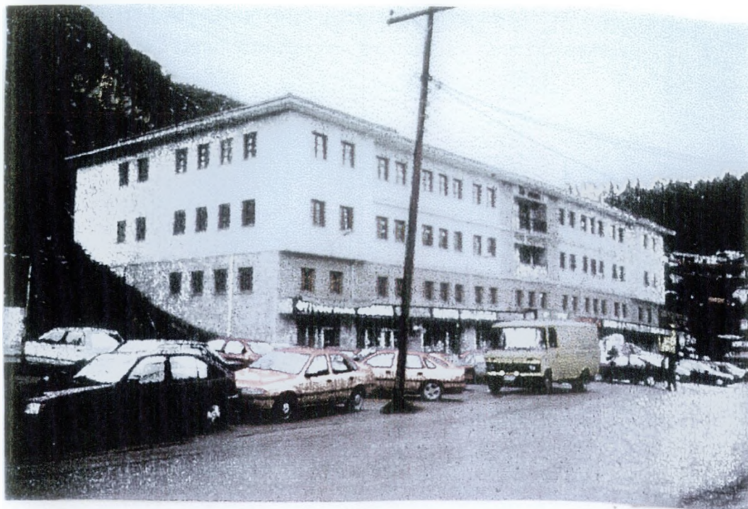
Εξωτερική άποψη των κεντρικών γραφείων, του πρατηρίου τροφίμων S/M και του πρατηρίου φυτοφαρμάκων της ΕΑΣ Καστοριά
