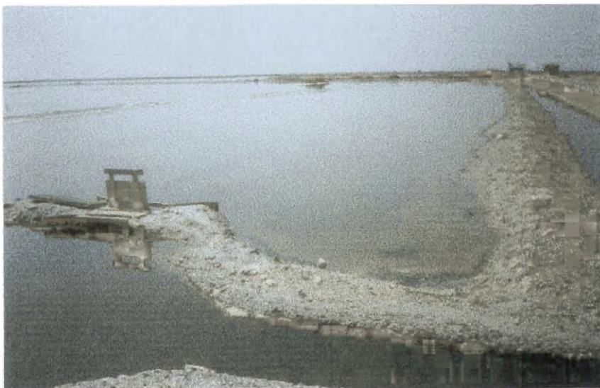
Εικ.7. Φαίνεται η λεκάνη Τηγάνια, καθώς και οι πόρτες, που ανάλογα με τη θέση που έχουν καθορίζουν την στάθμη και τη ροή του νερού από τη μια λεκάνη στην άλλη.
