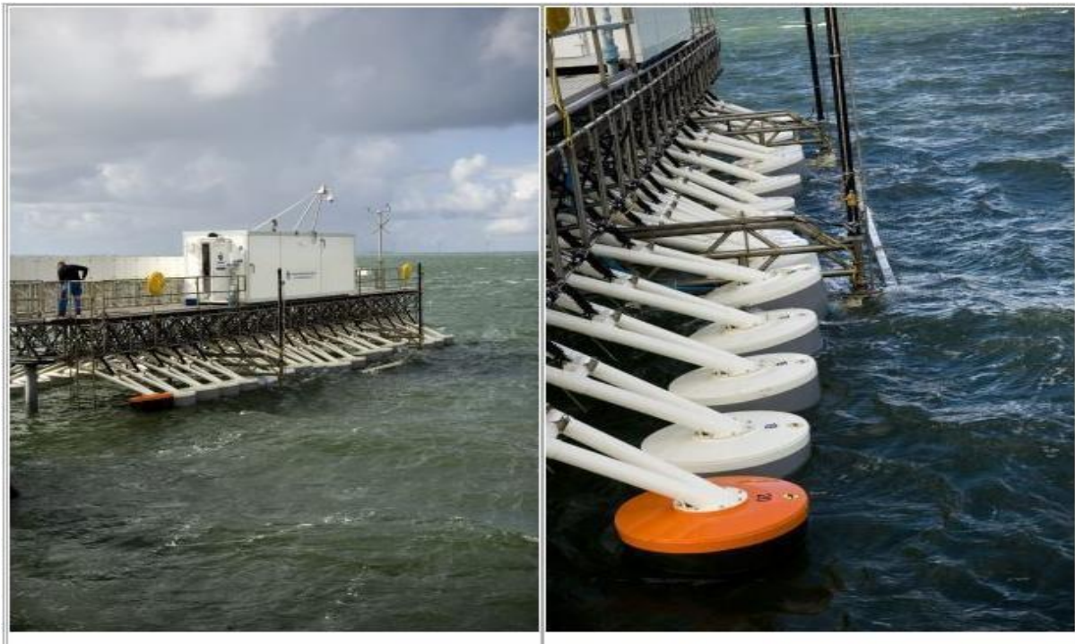
Εικόνα 4.18: Πλάγια όψη και μία από τις δύο σειρές σημαδούρων του μοντέλου Wave Star στο Nissum Bredning.
