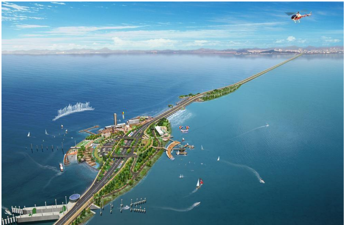
Εικόνα 2.4: Ο παλιρροιακός σταθμός παράγωγης ηλεκτρικής ενέργειας Sihwa.
