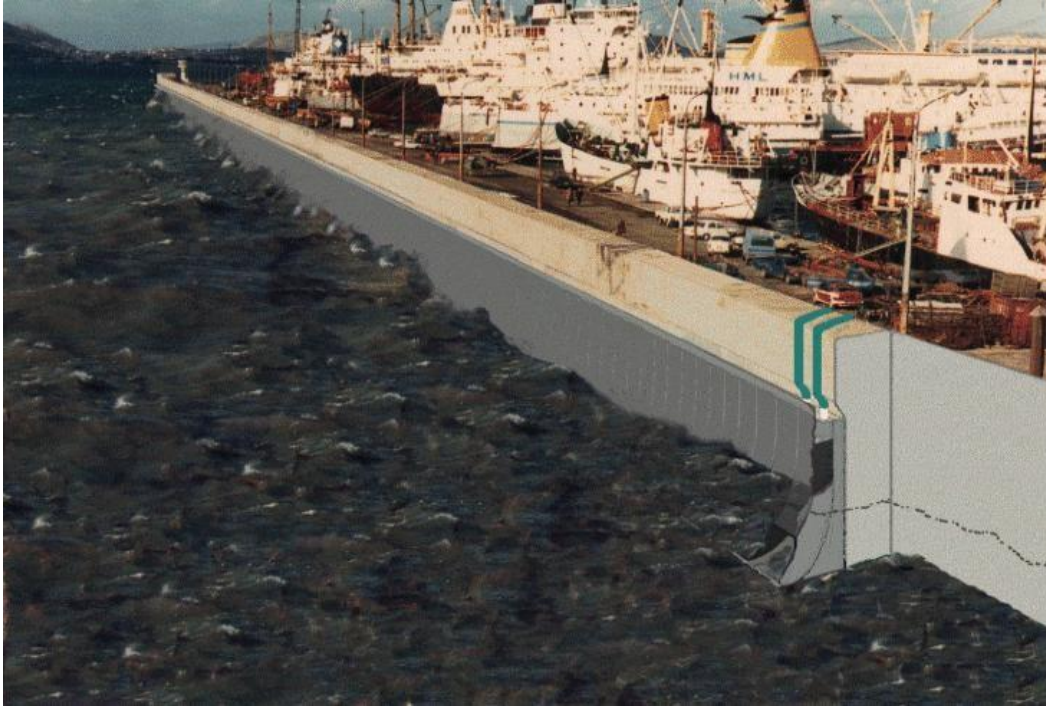
Εικόνα 4.5: Προτεινόμενη εφαρμογή κυματοθραύστη του μετατροπέα κυματικής ενέργειας WECA.
