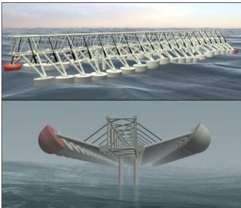
Εικόνα 4.19: Η κεντρική γέφυρα του Wave Star με τις δύο σειρές από πλωτά σε θέση λειτουργίας και ασφαλείας.
