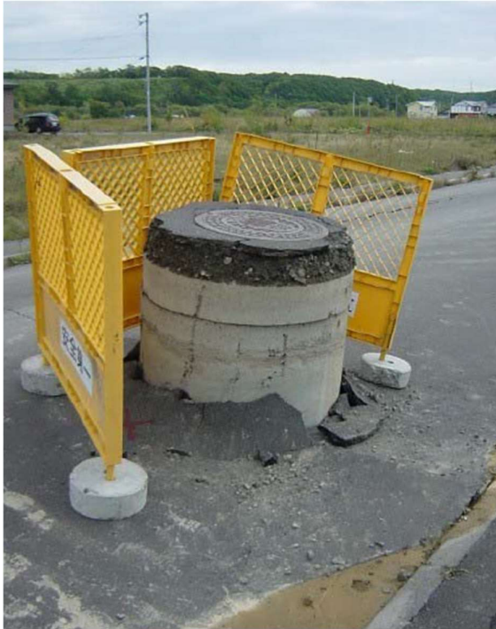
Εικόνα 1.14 Ανάδυση υπόγειων κατασκευών (Μπουκουβάλας,2019)
