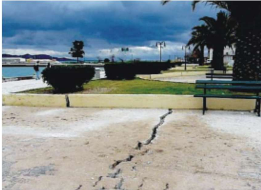
Εικόνα 1.18 Οριζόντιες μετατοπίσεις (Παπαδόπουλος, 2014)
