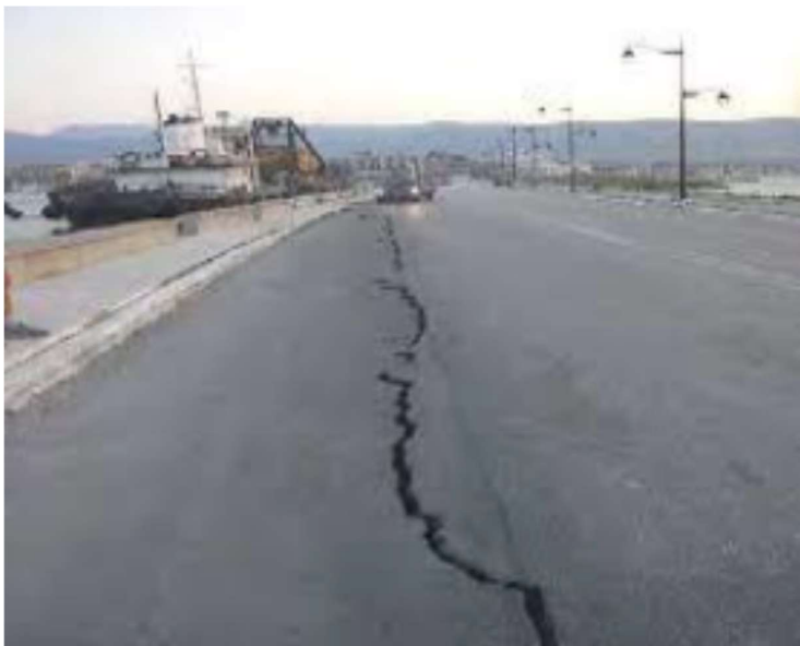
Εικόνα 1.13 Καθιζήσεις επιχώματος κρηπιδότοιχου (Δημητρίου, 2008)
