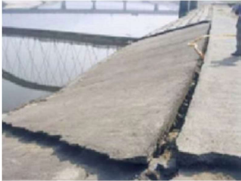
Εικόνα 1.11 Πλευρική εξάπλωση (Xiao-wei Tang et al, 2018)
