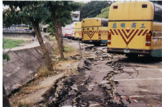
Εικόνα 1.12 Πλευρική εξάπλωση (Μπουκουβάλας, 2019)
