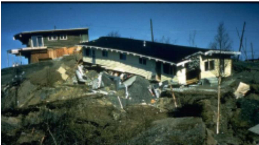
Εικόνα 1.6 Εδαφική ροή στα στρώματα αργίλου στο Anchorage (Παπαθανασίου Γ., 2006)
