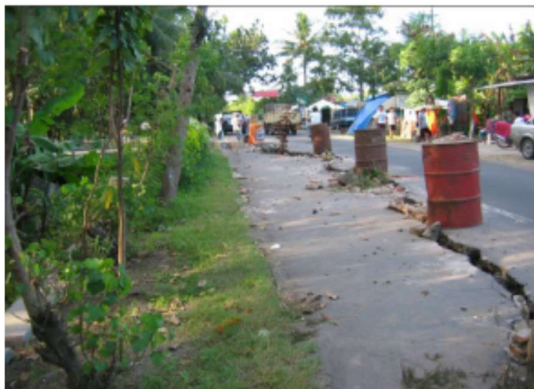
Εικόνα 1.15 Πλευρική εξάπλωση και καθίζηση (Xiao-Wei Tang et al, 2018)
