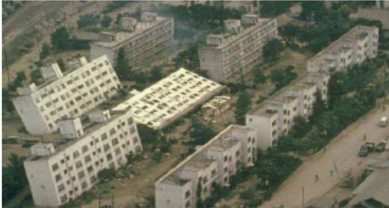
Εικόνα 1.5 Υποχώρηση κτηρίων λόγω ρευστοποίησης (Μπουκουβάλας 2019)
