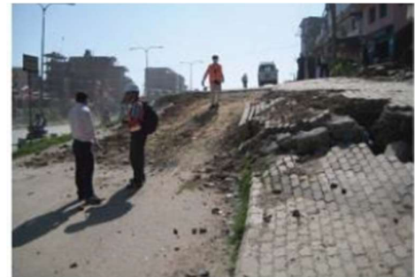
Εικόνα 1.21 Ανύψωση εδάφους (Goda, 2015)
