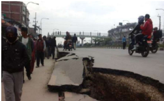
Εικόνα 1.20 Ανύψωση εδάφους (Goda, 2015)
