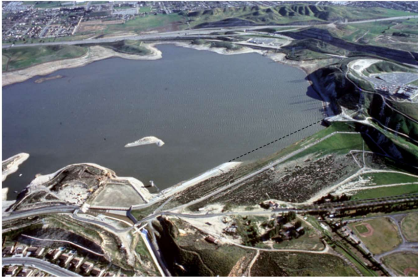
Εικόνα 1.7 Αεροφωτογραφία του φράγματος (R.Seed, 2021)
