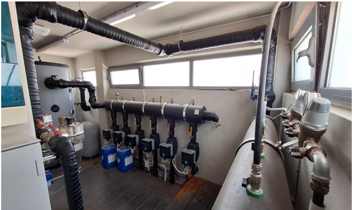
Εικόνα 2.29: Δοχεία αδρανείας ZNX (μηχανοστάσιο)
