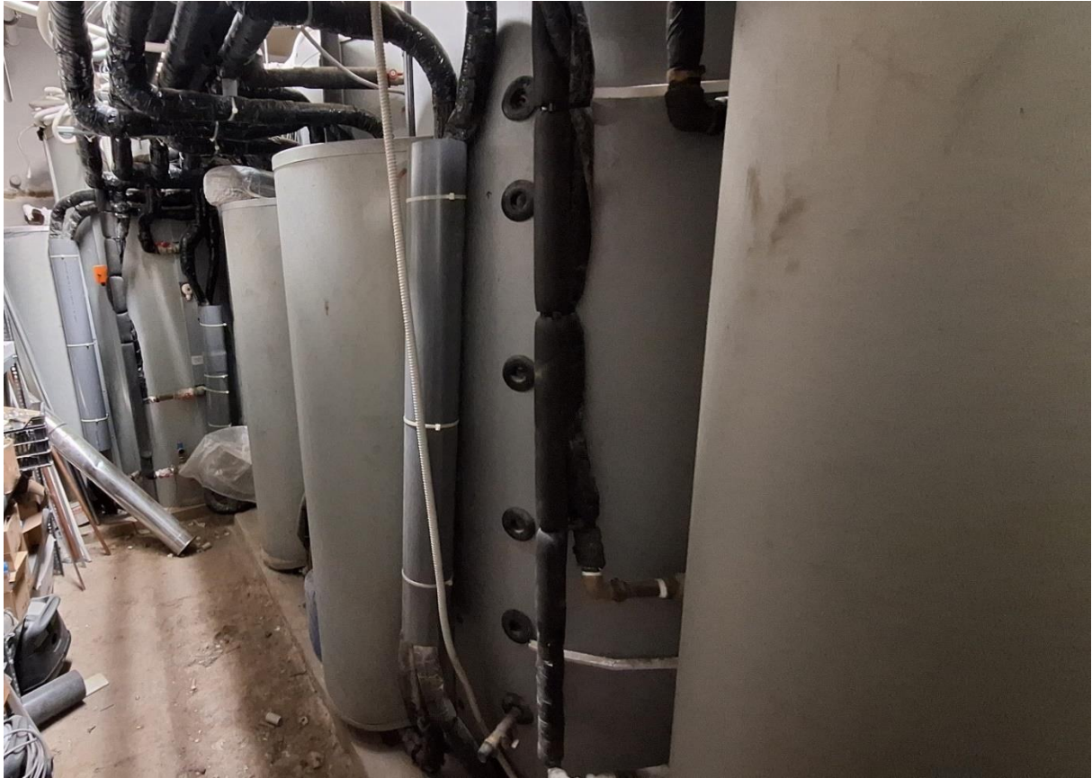
Εικόνα 2.29: Δοχεία αδρανείας ZNX (μηχανοστάσιο)
