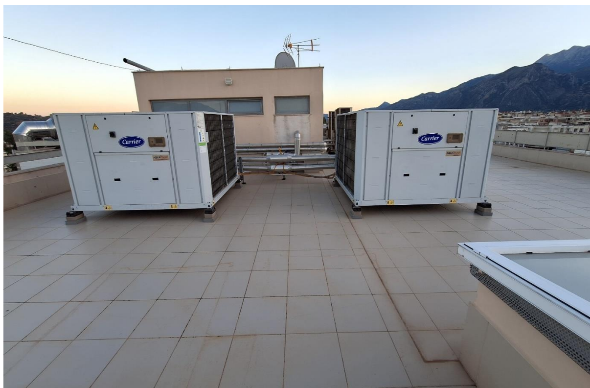
Εικόνα 2.23: Αντλίες θερμότητας κλιματισμού εστιατορίου – αίθουσας πρωινού
