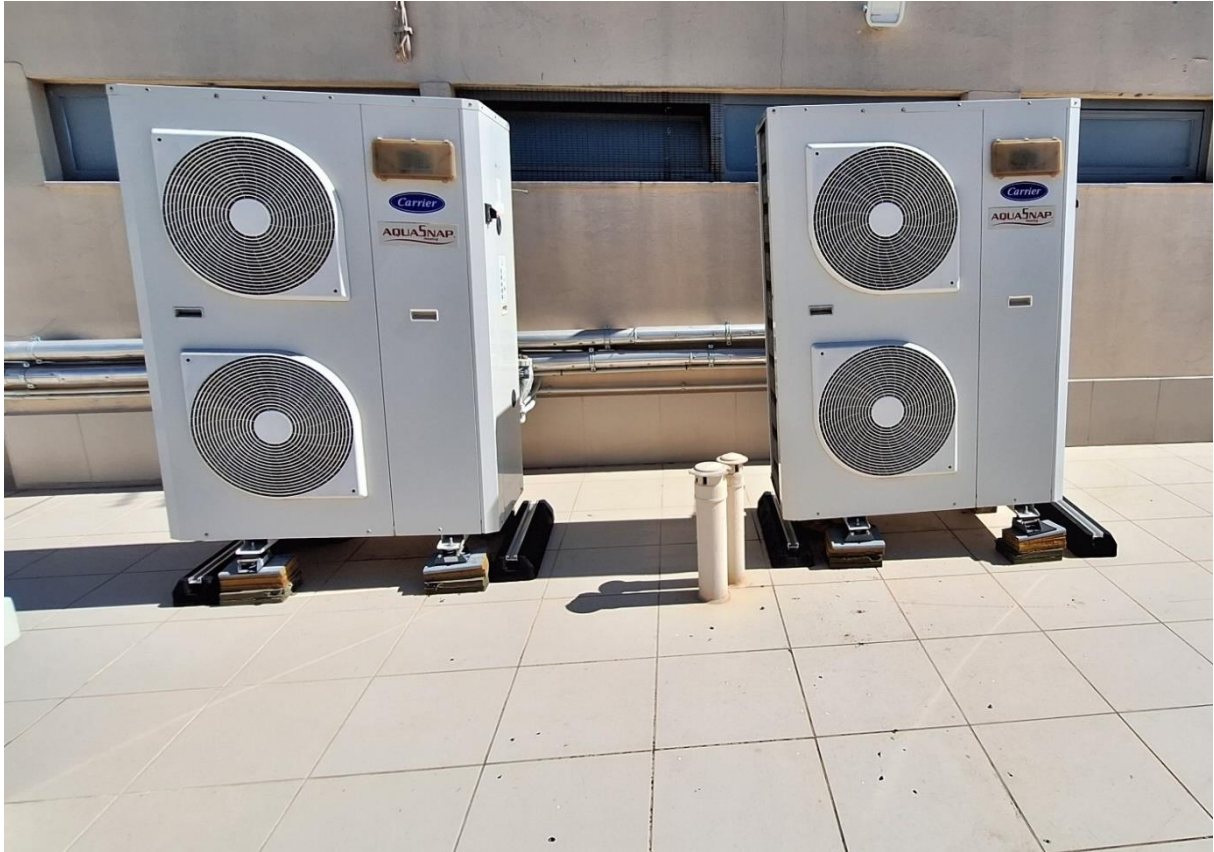
Εικόνα 2.25: Αντλίες θερμότητας παραγωγής ΖΝΧ
