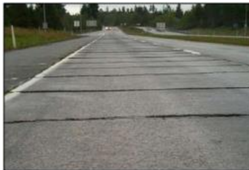
Εικόνα 6.3 Παράδειγμα ανισοσταθμίας πλακών σε δύο σκαμπτο οδόστρωμα
