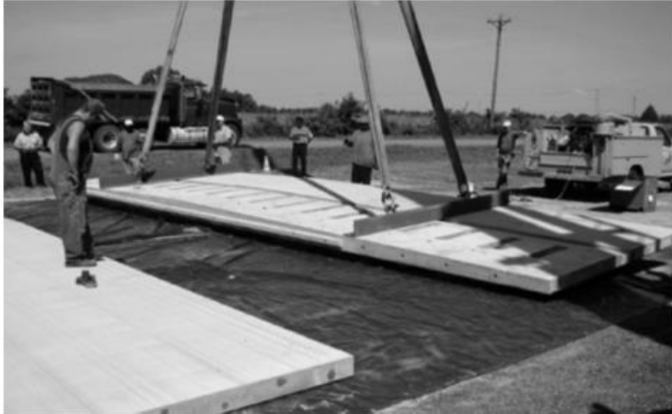
Εικόνα 5 Πάνελ προεντεταμένου σκυροδέματος που τοποθετείται πάνω από βάση.
