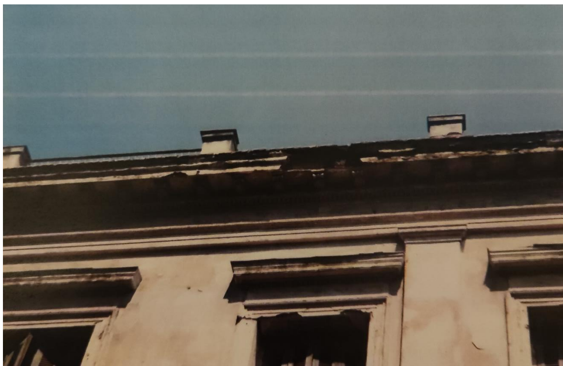
Εικόνα 27: Υφιστάμενη κατάσταση καλουπιών και γείσων. (Πηγή: Αρχείο νεοτέρων μνημείων)
