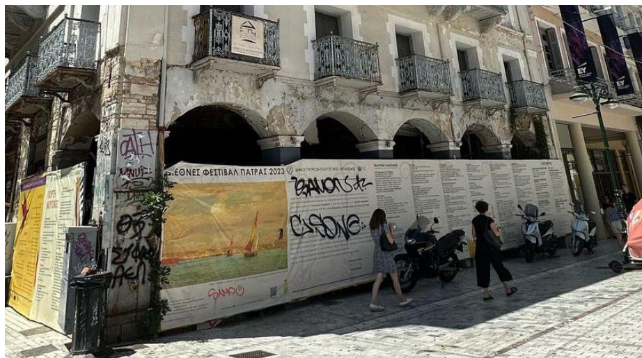
Εικόνα 25: Υφιστάμενη κατάσταση πρόσοψης επί της οδού Αγ.Νικολάου.
