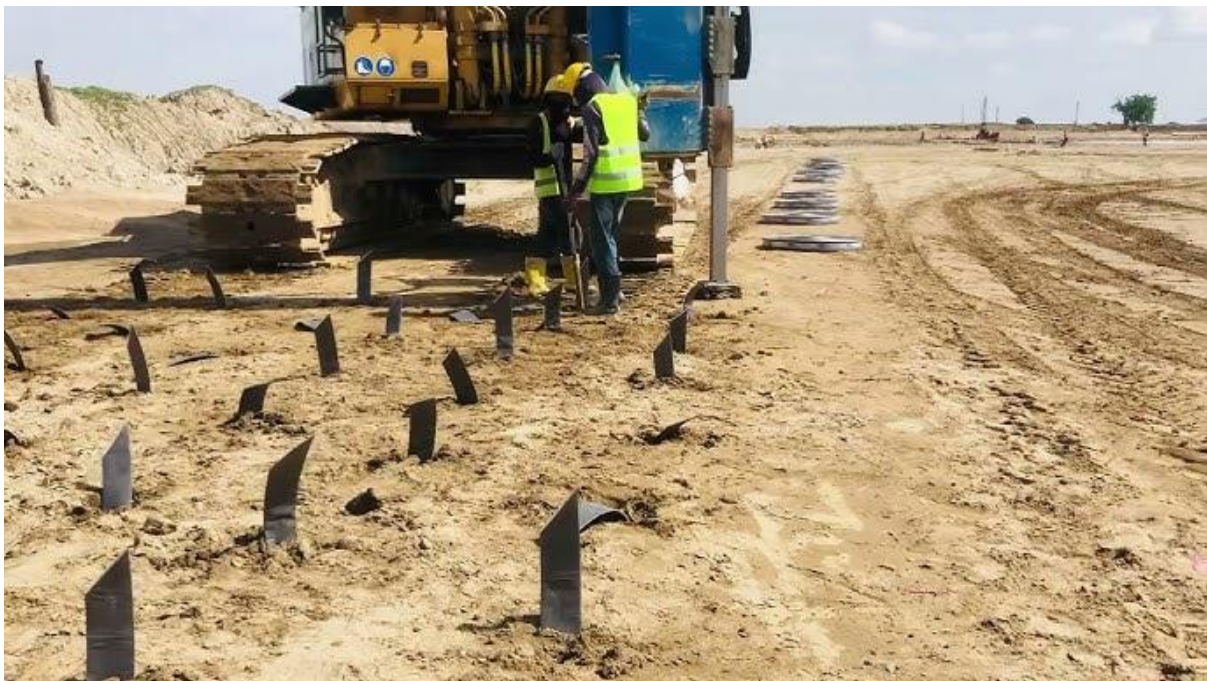
Εικόνα 17. Εφαρμογή κατακόρυφων γεωσύνθετων στραγγιστηρίων στο πεδίο
