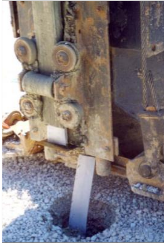
Εικόνα 10. Διαδικασία έμψηξης της φιλτροταινίας στο έδαφος
