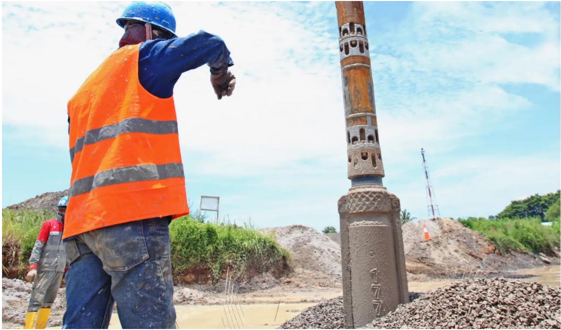
Εικόνα 22. Εφαρμογή στο πεδίο / Δονητική στήλη
