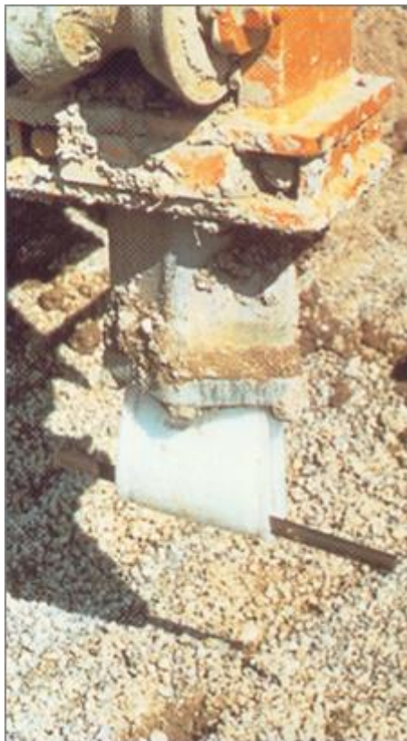
Εικόνα 9. Τοποθέτηση φιλτροταινίας στον ειδικό οδηγό
