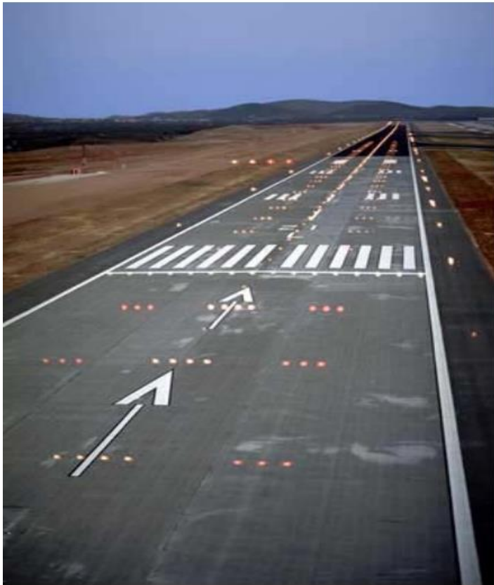
Εικόνα 2.9: Δυτικός διάδρομος αεροδρομίου «Ελευθέριος Βενιζέλος». Πηγή https://www.hcaa-eleng.gr/
