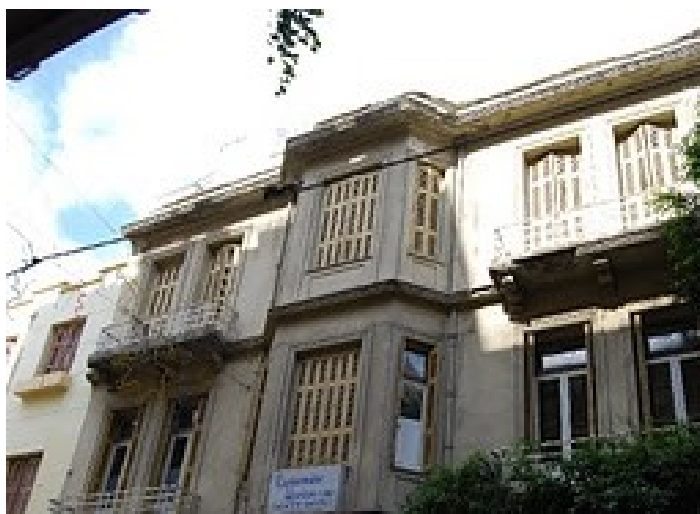
Εικόνα 17. Οικία Δημ. Ραμπαβίλα (1935-36) στην οδό Κανακάρη 146
