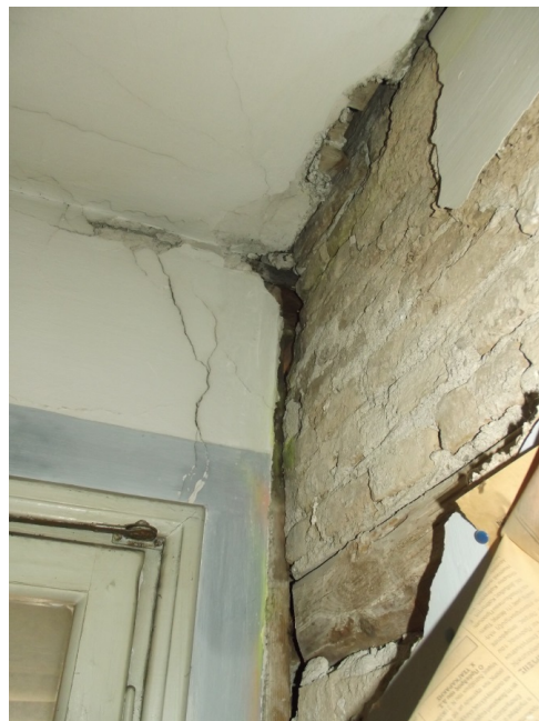
Εικόνα 38. Φθορές επιχρισμάτων
