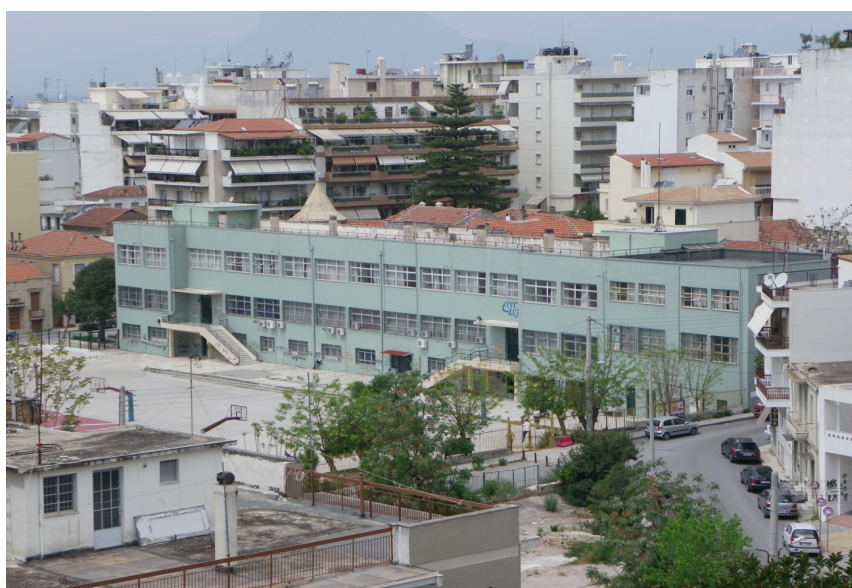
Εικόνα 6. Σχολ. Συγκρότημα Βουδ, Ασημ. Φωτήλα και Ν. Τεμπονέρα, (αρχιτέκτων Κ. Παναγιωτάκος) 1932-1933
