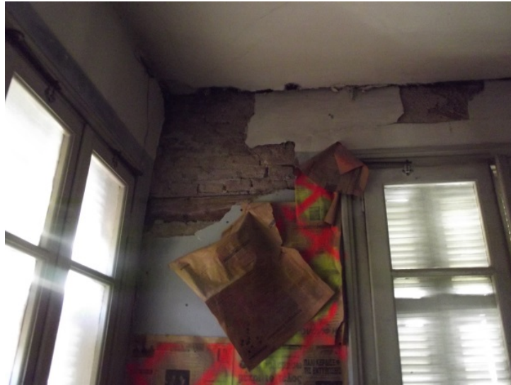
Εικόνα 37. Φθορές επιχρισμάτων
