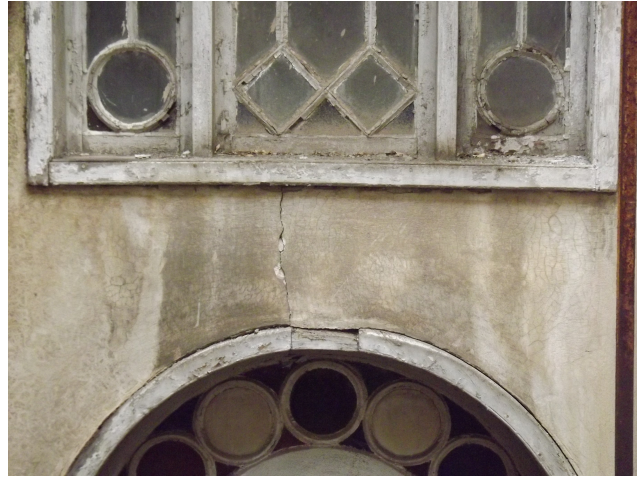
Εικόνα 43. Εξωτερικό κούφωμα (πρός τον ακάλυπτο)
