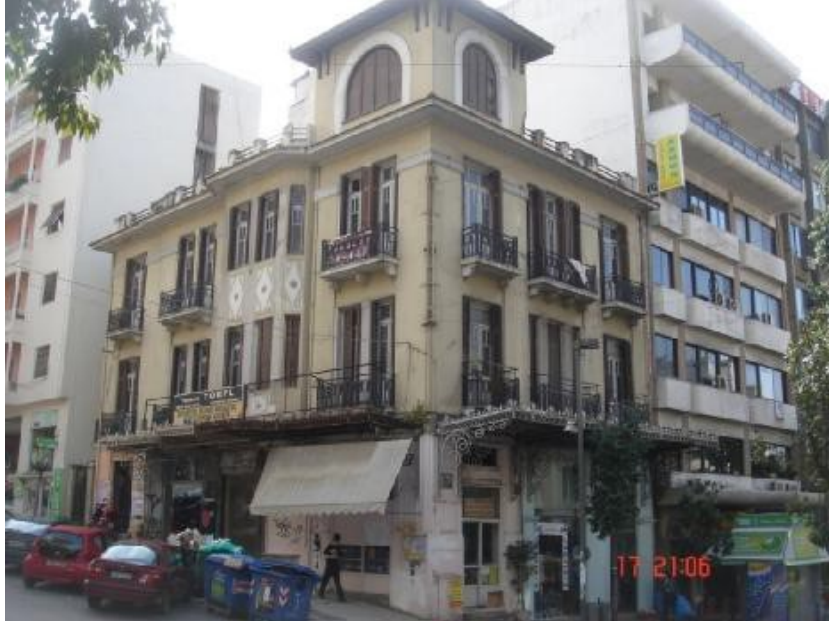
Εικόνα 8. Κτίριο Διον. Τσαμαδού
