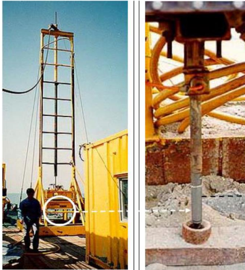
Εικόνα 21. Η δοκιμή Διείσδυσης Κώνου (CPT) ( https://docplayer.gr/4864811-Tehniki-ereyna-toy-ypedafoys.html )
