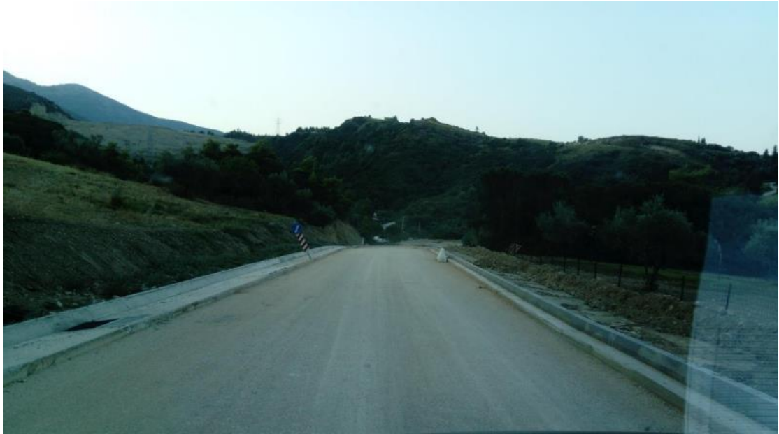
Εικόνα 6.40: Διάστρωση βάσης
