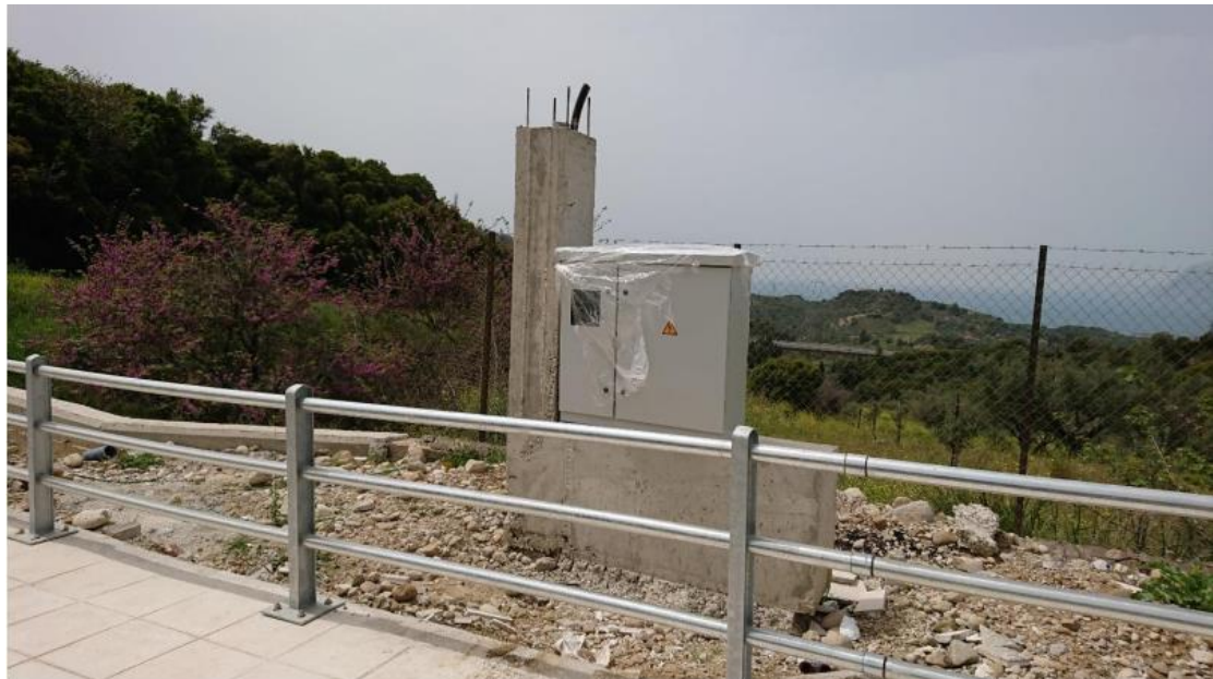
Εικόνα 6.46: Τοποθέτηση Pillar και σύνδεση εκκινητών
