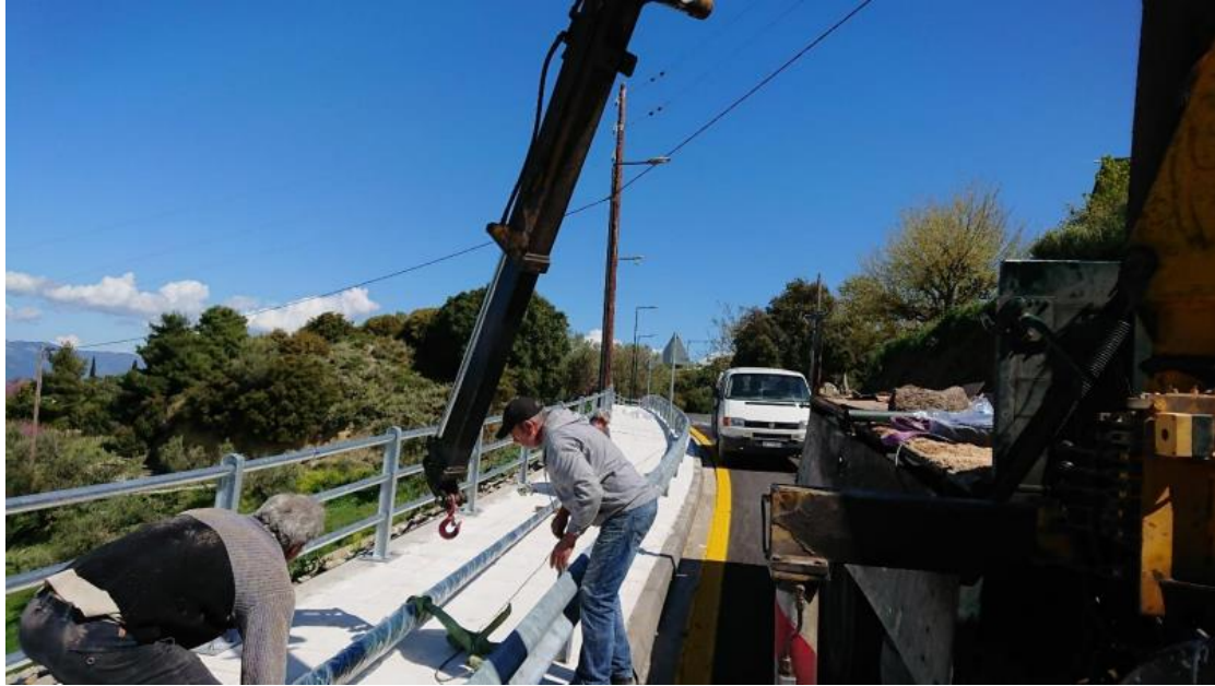
Εικόνα 6.45: Προετοιμασία για τοποθέτηση στύλου φωτισμού
