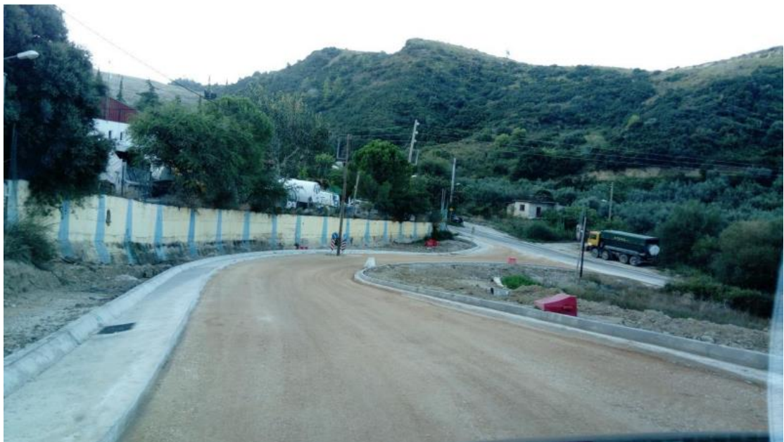
Εικόνα 6.41: Διάστρωση βάσης
