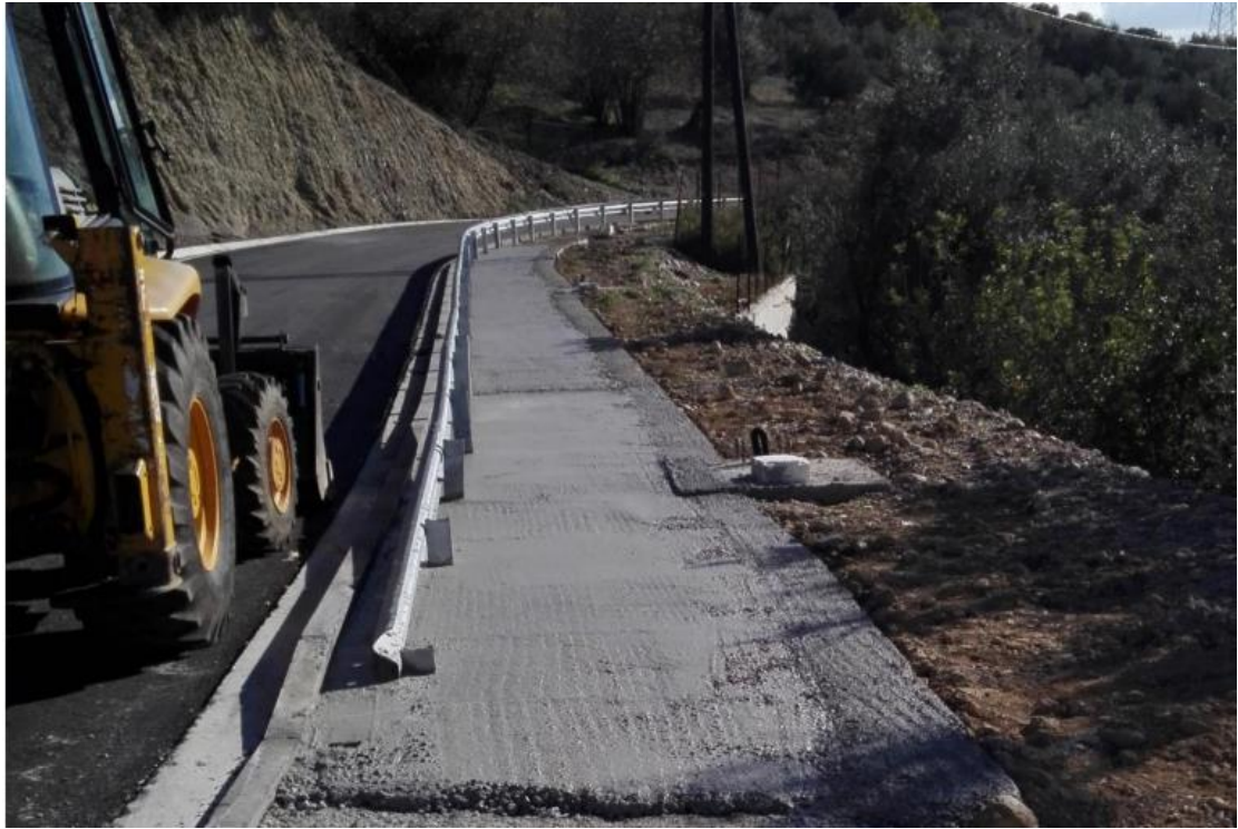
Εικόνα 6.34: Σκυροδέτηση πεζοδρομίων
