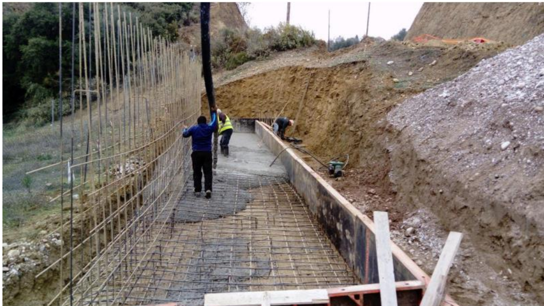
Εικόνα 6.25: Σκυροδέτηση με μπετό καθαριότητας για την κατασκευή τοιχείου
