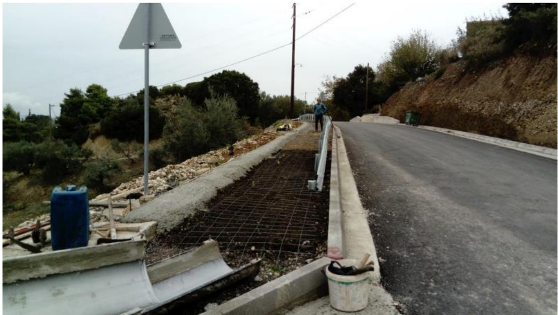
Εικόνα 6.33: Τοποθέτηση οπλισμού για την κατασκευή πεζοδρομίων
