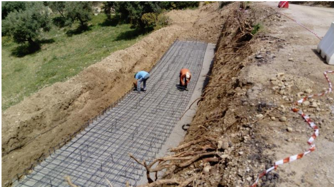
Εικόνα 6.31: Σκυροδέτηση και οπλισμός βάσης για την κατασκευή τοιχείου
