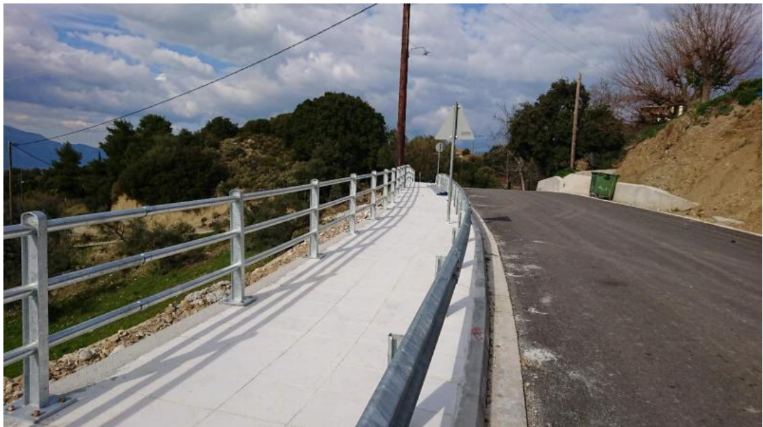
Εικόνα 6.37: Πλακοστρώσεις πεζοδρομίων
