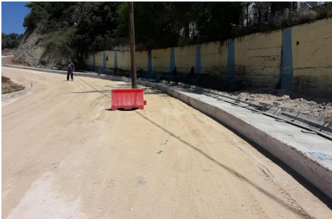
Εικόνα 6.39: Διάστρωση υπόβασης
