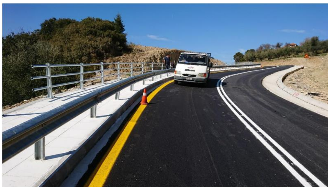
Εικόνα 6.50: Εργασίες διαγράμμισης – Τοποθέτηση στηθαίων ασφαλείας και κιγκλιδωμάτων
