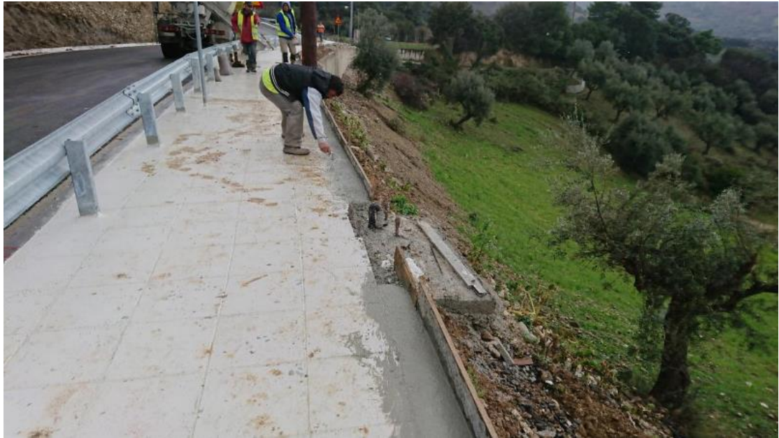
Εικόνα 6.36: Πλακοστρώσεις πεζοδρομίων
