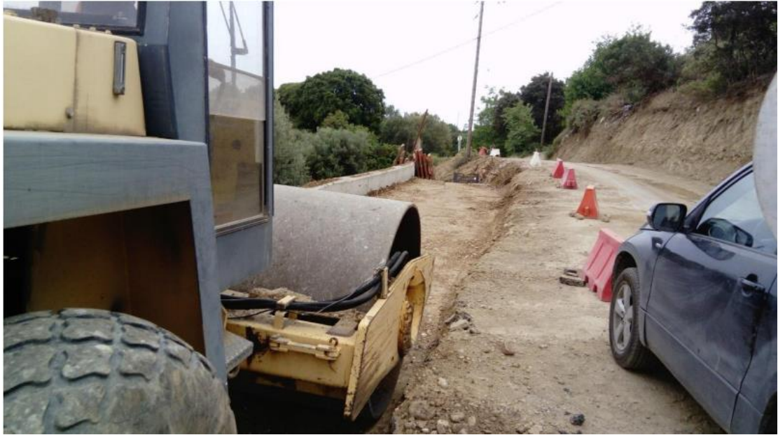
Εικόνα 6.32: Επίχωση και συμπίκνωση έτοιμου τοιχείου
