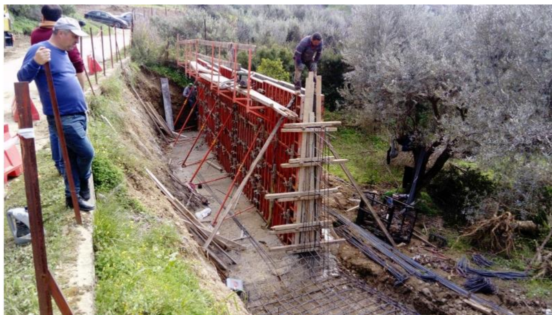
Εικόνα 6.29: Καλούπωμα και τοποθέτηση οπλισμού για την κατασκευή τοιχείου
