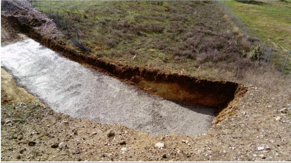
Εικόνα 6.24: Σκυροδέτηση με μπετό καθαριότητας για την κατασκευή τοιχείου
