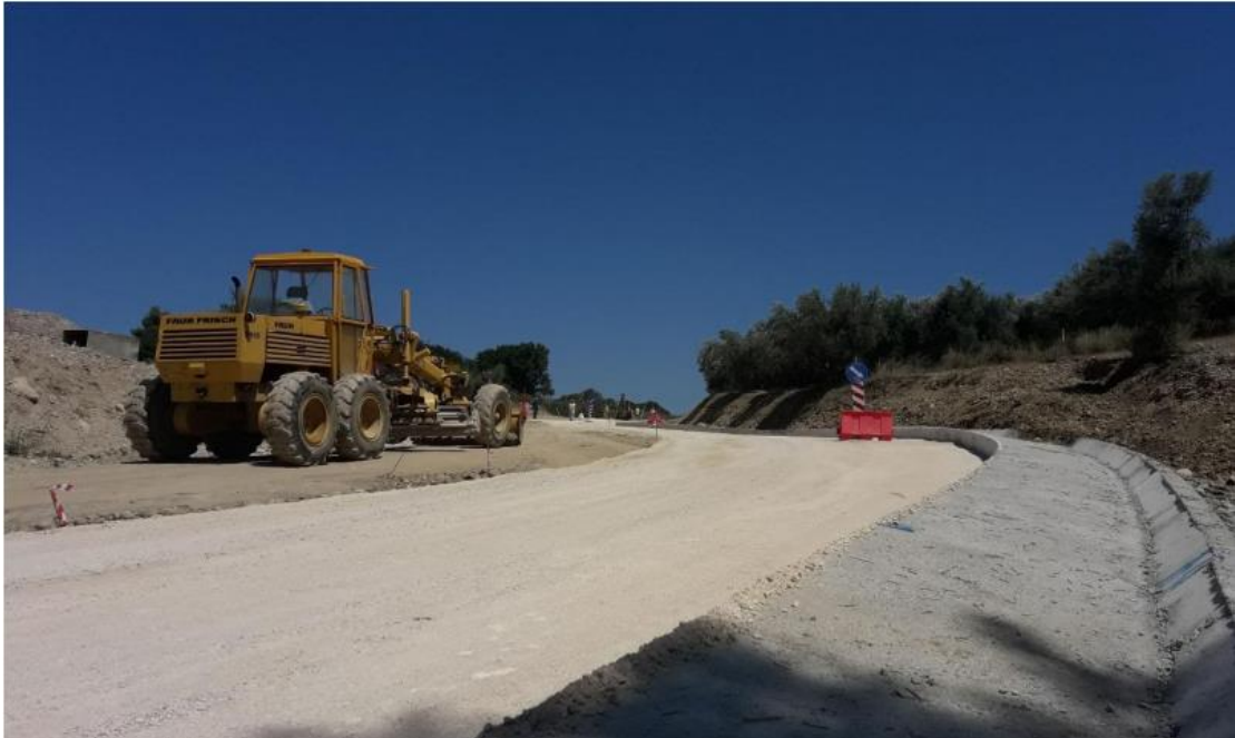
Εικόνα 6.38: Διάστρωση υπόβασης
