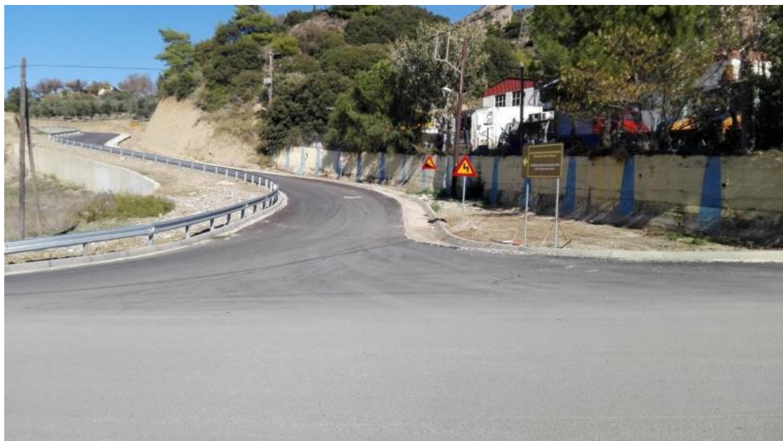
Εικόνα 6.47: Τοποθέτηση πινακίδων σήμανσης
