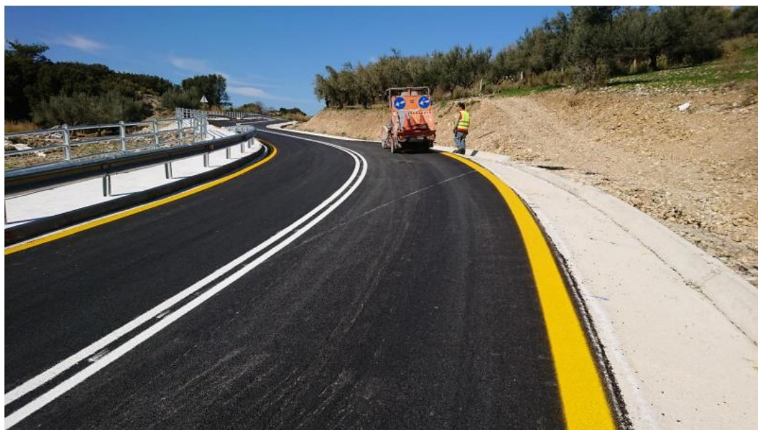
Εικόνα 6.49: Εργασίες διαγράμμισης – Τοποθέτηση στηθαίων ασφαλείας και κιγκλιδωμάτων
