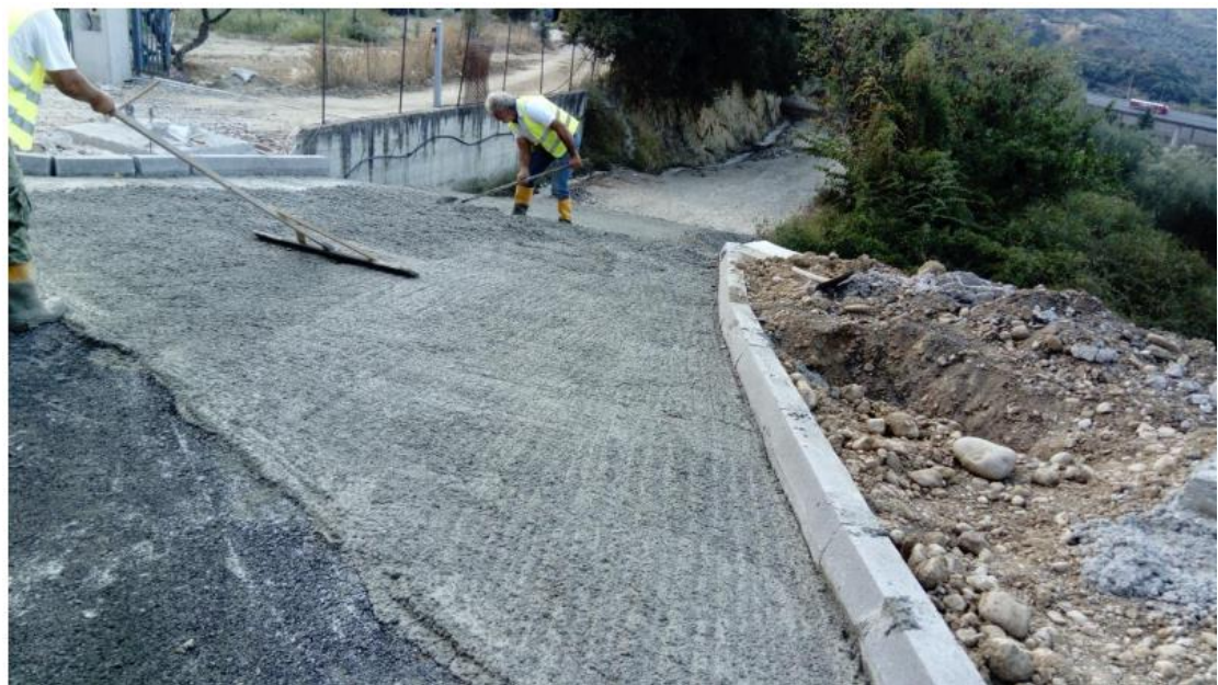
Εικόνα 6.35: Κατασκευή τσιμεντόδρομου
