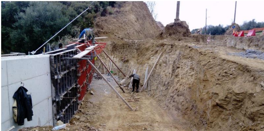
Εικόνα 6.26: Καλούπωμα για ολοκλήρωση κατασκευής τοιχείου
