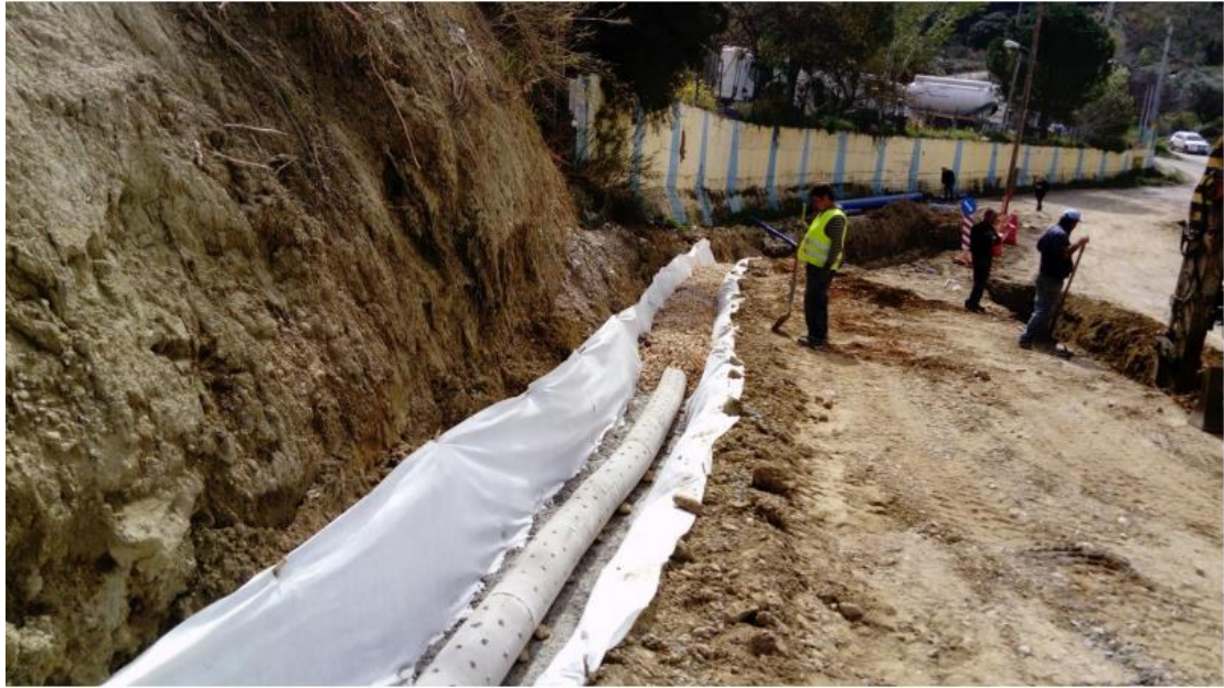
Εικόνα 6.30: Κατασκευή στραγγιστηρίου
