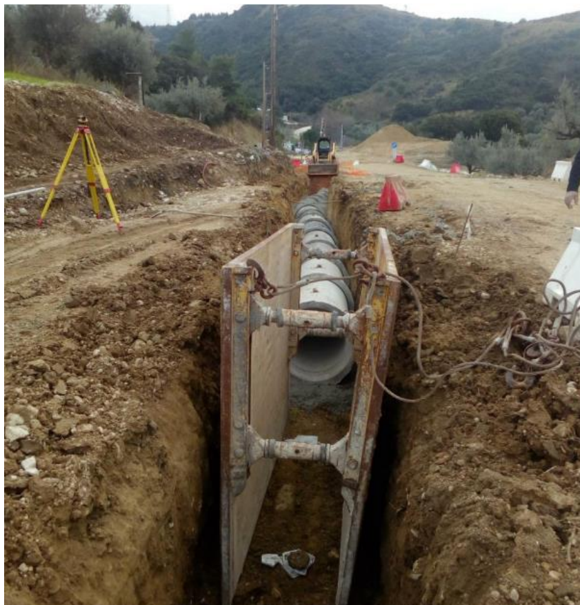
Εικόνα 6.27: Κατασκευή αγωγού ομβρίων D800
