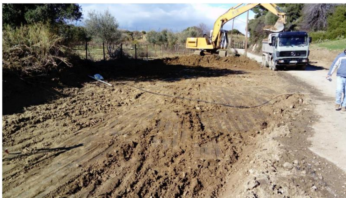
Εικόνα 6.23: Γενικές εκσκαφές σε όλο το πλάτος της απαλοτρίωση
