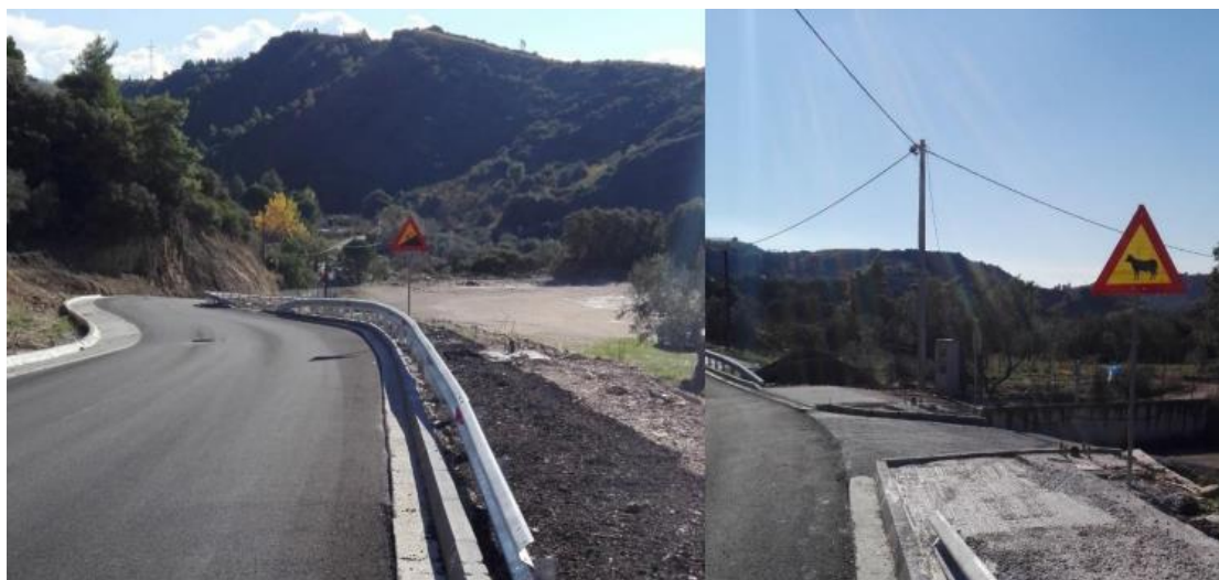
Εικόνα 6.48: Τοποθέτηση πινακίδων σήμανσης
