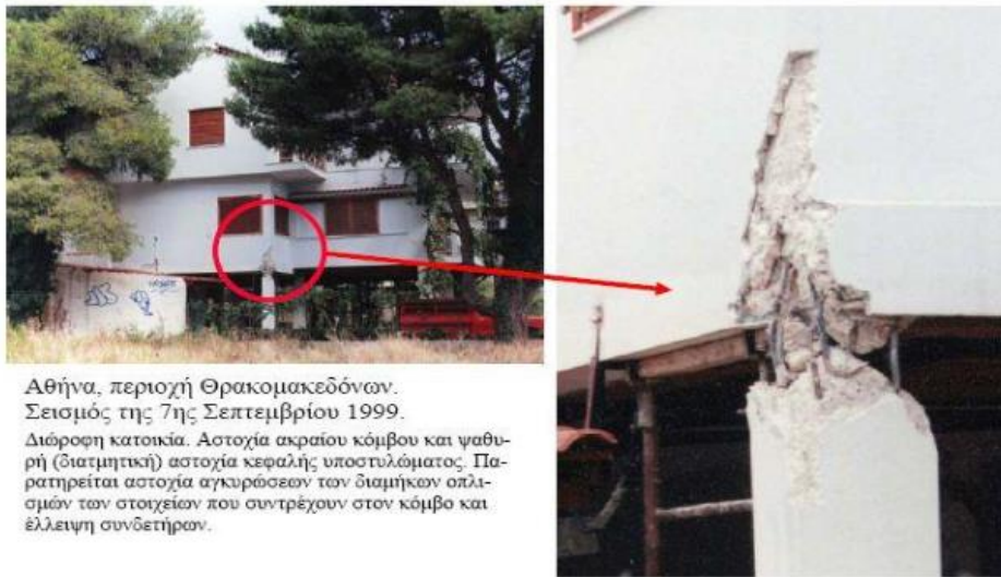
Εικόνα 4.20: Αστοχία (διαμητική) ακραίου κόμβου στο σεισμό της Αθήνας, 1999.
