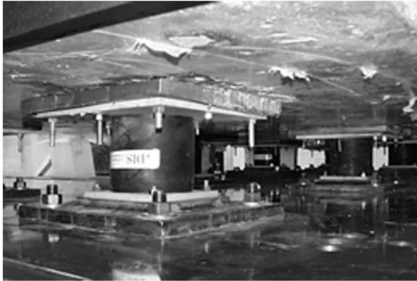
Εικόνα 4.31: Ελαστομερές εφέδρανο χαμηλής απόσβεσης και εφαρμογή του (22).
