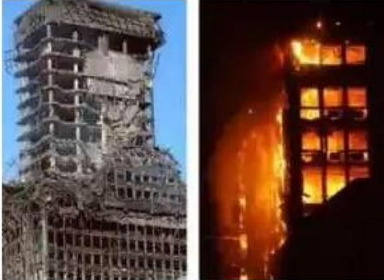
Εικόνα 1.4: Κτίριο από οπλισμένο σκυρόδεμα ύστερα από πυρκαγιά. (1)
