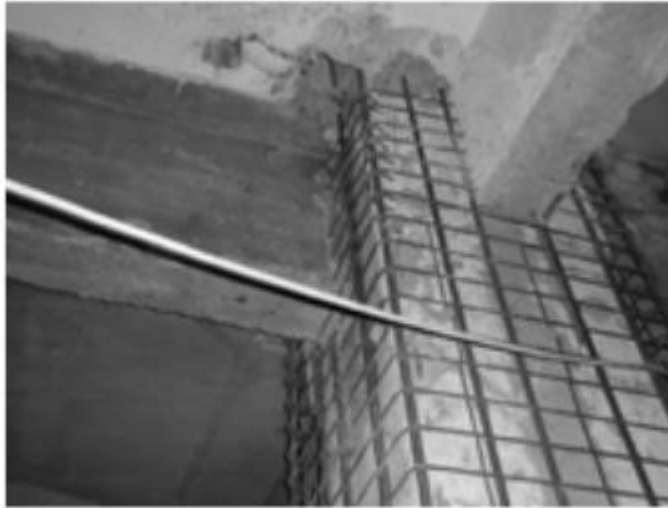
Εικόνα 4.22: Ενίσχυση υποστυλώματος με μανδύα οπλισμένου σκυροδέματος (22).
