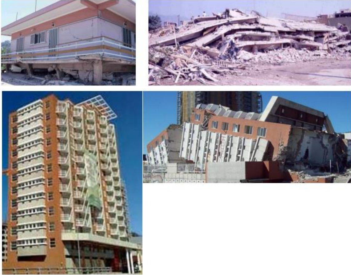
Εικόνα 1.5: Κτίρια τα οποία έχουν αστοχήσει από σεισμό. (5)
