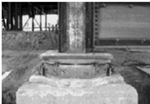
Εικόνα 4.32: Εφέδρανο ολίσθησης (Αριστερά) και εφέδρανο με επάλληλες διεπιφάνειες ολίσθησης (22).
