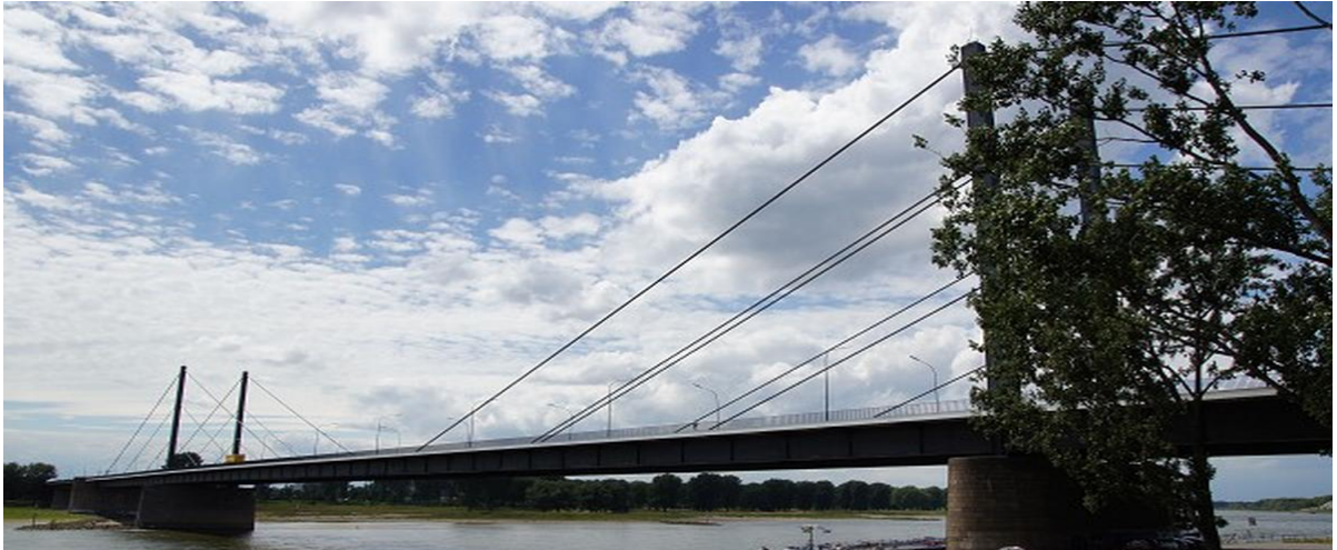
Εικόνα 2.1.3 Η γέφυρα Theodor Heuss, Από Theodor Heuss Bridge , του Nicolas Janberg, 11 Ιουλίου 2011, Structurae. Ανακτήθηκε 24 Αυγούστου 2024 από https://structurae.net/en/media/184715-theodor-heuss-bridge Copyright 2011 του Nicolas Janberg
