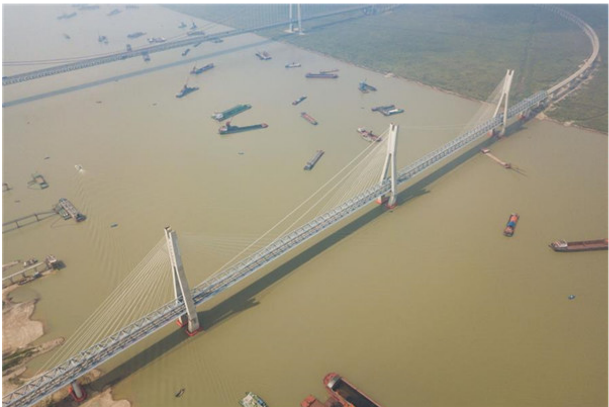
Εικόνα 6.1.2 Η καλωδιωτή γέφυρα της λίμνης Dongting στην Κίνα, Από New bridge over Dongting Lake on Haoji Railway line in C China's Hunan , του Xinhua, 19 Σεπτεμβρίου 2019, english.www.gov.cn . Ανακτήθηκε 20 Ιουλίου 2024 http://english.www.gov.cn/news/photos/201909/20/content_WS5d8493ebc6d0bcf8c4c13c16.html Copyright 2019 του Xinhua
