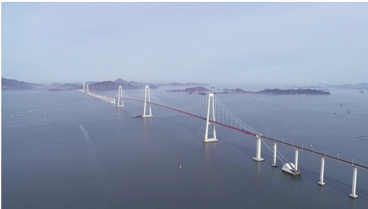
Εικόνα 5.1.4 Η κρεμαστή γέφυρα Cheon-Sa με 3 πυλώνες, Από Cheonsa Bridge, the Only Marine Complex Bridge in Korea, Opened , του DLENC, 11 Απριλίου 2019, DLENC. Ανακτήθηκε 30 Ιουλίου 2024 από https://www.dlenc.co.kr/eng/daelim/pr/NewsView.do?keyword=&searchword=&currentPage=1&cd_mnu=&idx=19989 Copyright 2019 του DLENC
