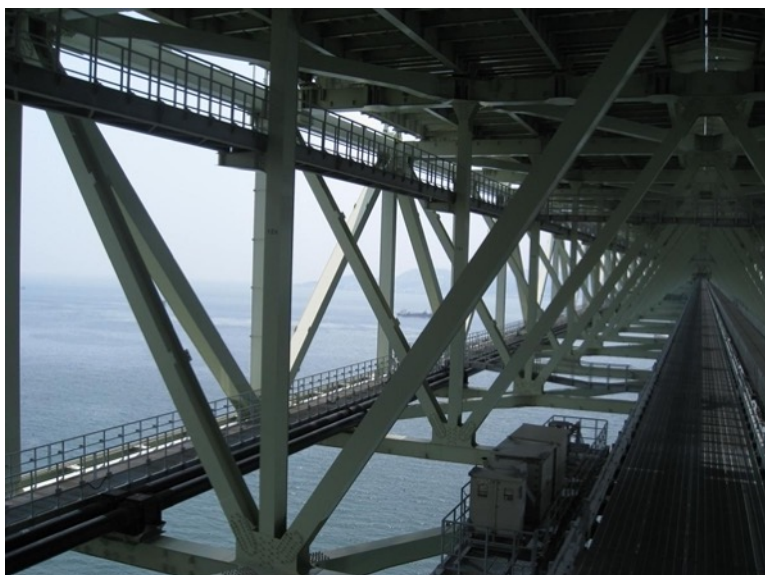
Εικόνα 5.2.4 Εσωτερικό καταστρώματος γέφυρας Akashi-Kaikyō, Από Akashi-Kaikyo , της Sonja Zlatovic, 30 Ιουλίου 2008, Structurae. Ανακτήθηκε 30 Ιουλίου 2024 από https://structurae.net/en/media/180436-akashi-kaikyo-bridge Copyright 2008 της Sonja Zlatovic
