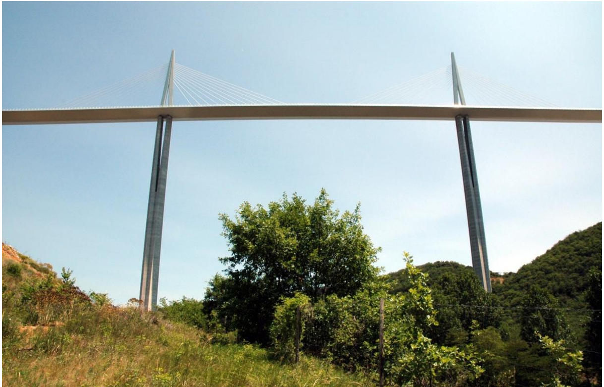
Εικόνα 5.1.7 Οι πυλώνες της γέφυρας Millau, Από Millau Viaduct , του Adrien Mortini, 10 Μαΐου 2005, Structurae. Ανακτήθηκε 30 Ιουλίου 2024 από https://structurae.net/en/media/57759-millau-viaduct Copyright 2005 των CEVM Eiffage/Foster & Partners
