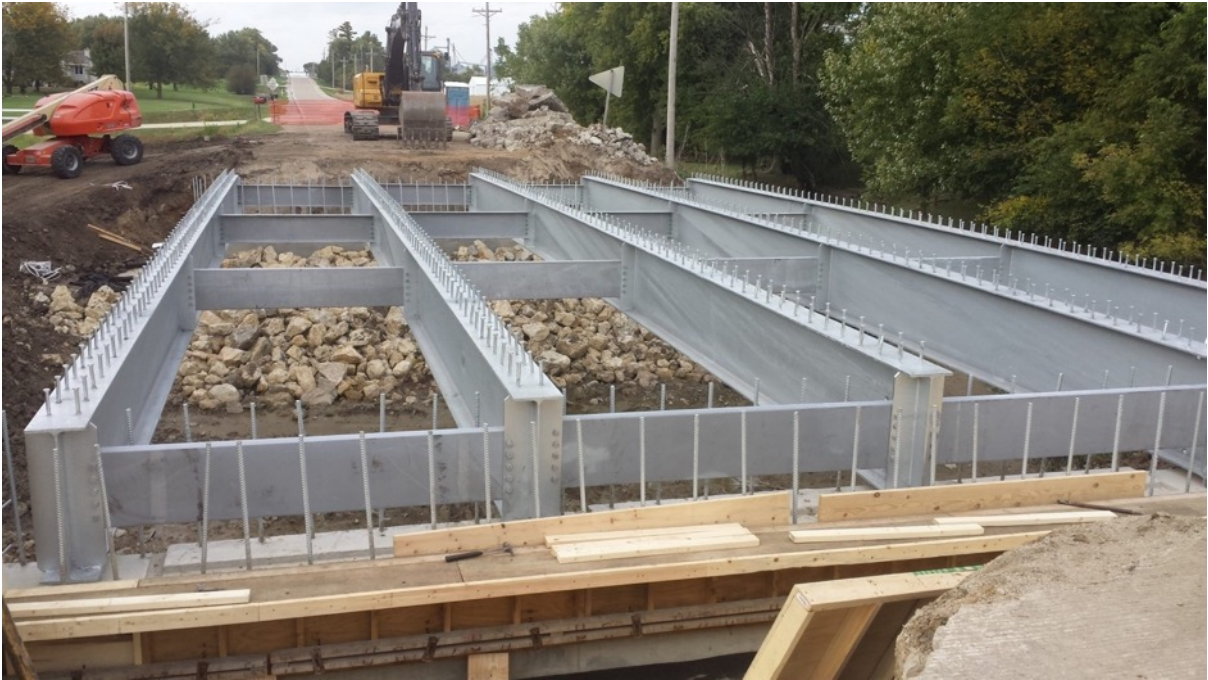
Εικόνα 4.1.1 Κατασκευή γέφυρας με δοκούς στο Jesup, Νότια Αϊόβα, Από Plate Girder and Rolled Beams are Common Superstructures for Short Span Bridges , της Short Span Steel Bridge Alliance, 10 Μαρτίου 2013, Shortspansteelbridges. Ανακτήθηκε 20 Ιουλίου 2024 από https://www.shortspansteelbridges.org/products/rolled-beam-plate-girder/ Copyright 2020 της Short Span Steel Bridge Alliance
