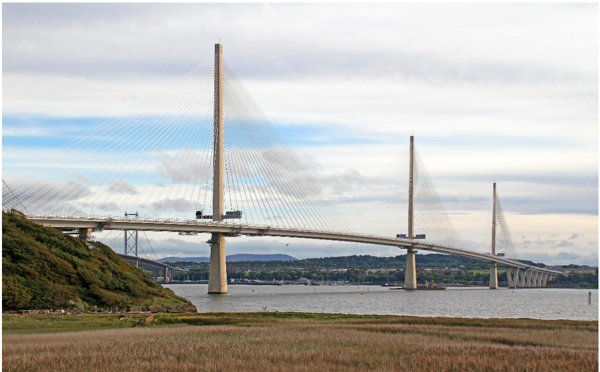
Εικόνα 3.3.4 Η καλωδιωτή γέφυρα Queensferry, Από Queensferry Bridge , του Tony Hisgett, 16 Νοεμβρίου 2021, Structurae. Ανακτήθηκε 24 Αυγούστου 2024 από https://structurae.net/en/media/365422-queensferry-bridge Copyright 2021 του Tony Hisgett
