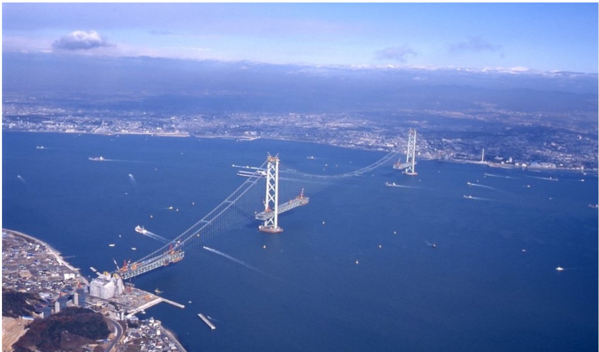
Εικόνα 5.2.1 Η κατασκευή της γέφυρας Akashi-Kaikyō, Από Akashi-Kaikyo , του 神戸市, 8 Δεκεμβρίου 1995, Structurae. Ανακτήθηκε 30 Ιουλίου 2024 από https://structurae.net/en/media/353211-akashi-kaikyo-bridge Copyright 1995 του 神戸市
