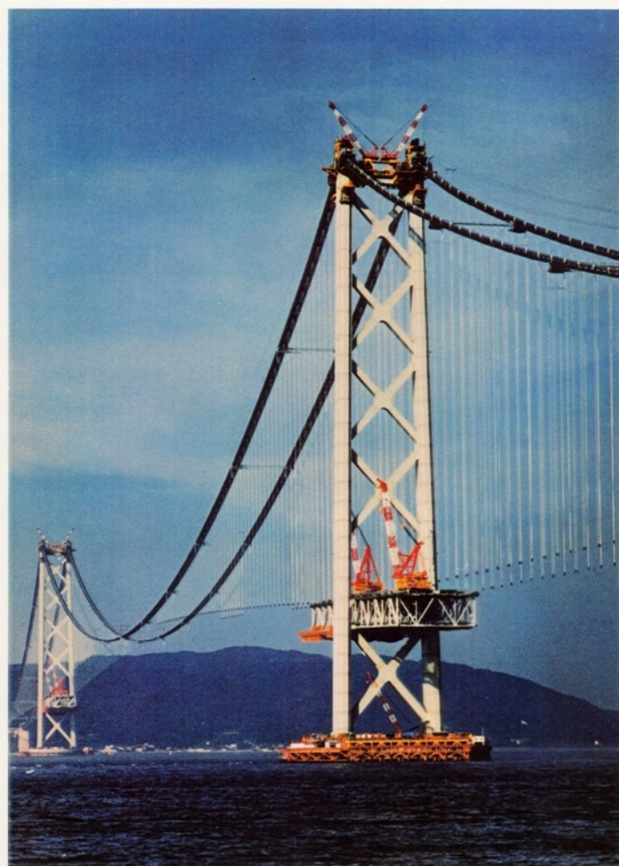
Εικόνα 5.2.3 Διαδικασία ανέγερσης της γέφυρας - κατασκευή καταστρώματος, Από Steel Bridges in Japan , του Nobutaka Yurioka, 1995, phase-trans.msm.cam.ac. Ανακτήθηκε 30 Ιουλίου 2024 από http://www.phase-trans.msm.cam.ac.uk/2004/Bridges/Bridges.html Copyright 1995 του Nobutaka Yurioka
