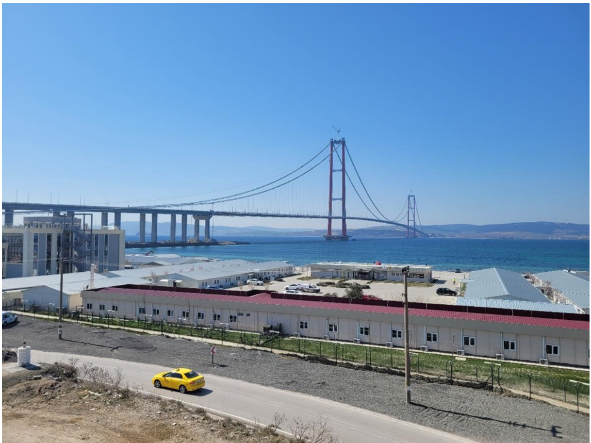
Εικόνα 3.3.6 Η κρεμαστή γέφυρα 1915 Çanakkale Bridge, Από 1915 Çanakkale Bridge, του Zafer, 27 Μαρτίου 2022, Structurae. Ανακτήθηκε 24 Αυγούστου 2024 από https://structurae.net/en/media/378411-1915-canakkale-bridge Copyright 2022 του Zafer
