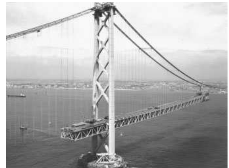
Εικόνα 5.2.10 Κατασκευή καταστρώματος και σύνδεση καλωδίων, Από «Technology of the Akashi-Kaikyō bridge», του Kitagawa M., 2004, Στο Structural control and health monitoring , τ.11, σελ.89., Copyright 2004 του M. Kitagawa
