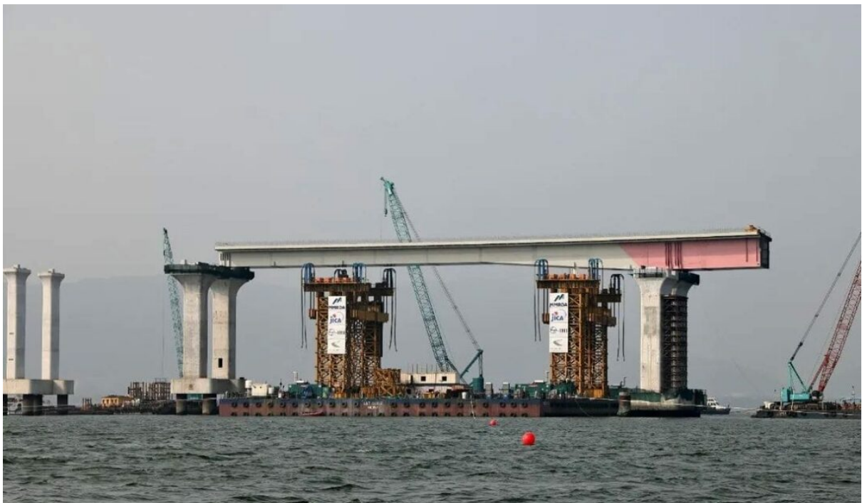
Εικόνα 4.2.1 Ανέγερση γέφυρας με μεταλλικό κατάστρωμα στη Βομβάη, Ινδία, Από What are Orthotropic steel bridge decks? , της Constro facilitator, Μάιος 2023, Constrofacilitator. Ανακτήθηκε 20 Ιουλίου 2024 από https://constrofacilitator.com/what-are-orthotropic-steel-bridge-decks/ Copyright 2023 της Constro facilitator
