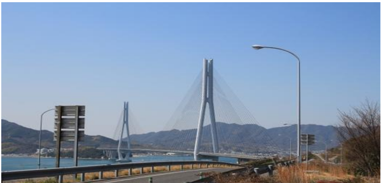
Εικόνα 4.1.9 Καλωδιωτή γέφυρα Tatara με ημιακτινωτό τύπο διάταξης καλωδίων, Ιαπωνία, Από Tatara Bridge, της Inge Kanakaris-Wirtl, Μάρτιος 2015, Structurae. Ανακτήθηκε 20 Ιουλίου 2024 από https://structurae.net/en/media/234644-tatara-bridge Copyright 2015 της Inge Kanakaris-Wirtl
