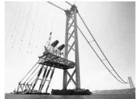
Εικόνα 5.2.12 Κατασκευή καταστρώματος, Από «Technology of the Akashi-Kaikyō bridge», του Kitagawa M., 2004, Στο Structural control and health monitoring , τ.11, σελ.89., Copyright 2004 του M. Kitagawa
