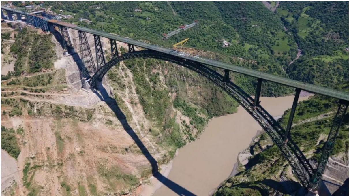
Εικόνα 4.1.6 Γέφυρα σιδηροδρόμου με τοξωτό κατάστρωμα στο Chenab, Ινδία, Από Chenab Railway Bridge , της Sakowski, 30 Σεπτεμβρίου 2023, Highestbridges. Ανακτήθηκε 20 Ιουλίου 2024 από https://www.highestbridges.com/wiki/index.php?title=Chenab_River_Railway_Bridge Copyright 2023 της Sakowski
