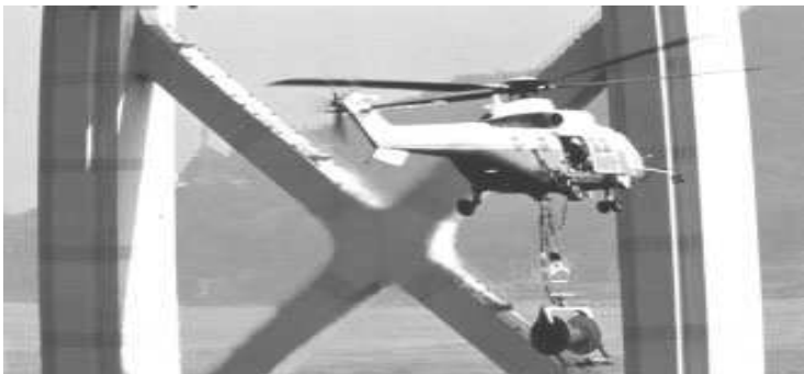
Εικόνα 5.2.11 Εγκατάσταση του βοηθητικού καλωδίου για την ανάρτηση των κύριων καλωδίων της γέφυρας από ελικόπτερο, Από «Technology of the Akashi-Kaikyō bridge», του Kitagawa M., 2004, Στο Structural control and health monitoring , τ.11, σελ.85., Copyright 2004 του M. Kitagawa
