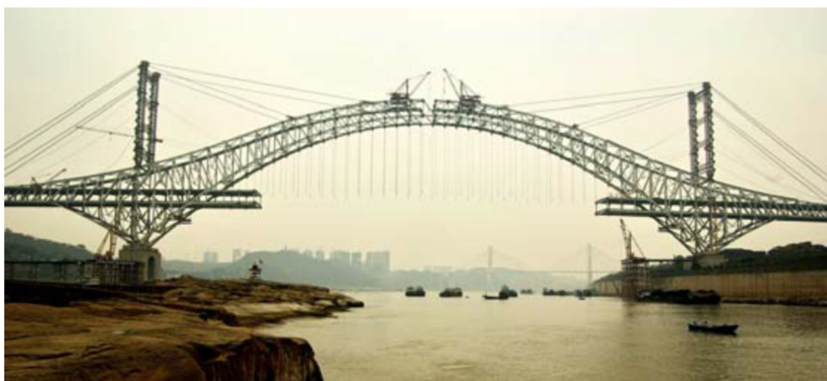
Εικόνα 5.2.32 Λίγο πριν το τέλος της κατασκευής του τόξου της γέφυρας Chaotianmen, Από «Design & technology characteristics of main bridge of Chaotianmen Yangtze River Bridge», των Duan et al., 2010, ARCH'10 – 6th International Conference on Arch Bridges , 11-13 Οκτωβρίου 2010, σελ 111. Ανακτήθηκε 13 Ιουλίου, 2024, από https://archbridges.fzu.edu.cn/_local/0/4A/45/62424EB4CDB7AC5A58B071C5FA7_4DAC1E42_73E56.pdf?e=.pdf Copyright 2010 των Duan et al.
