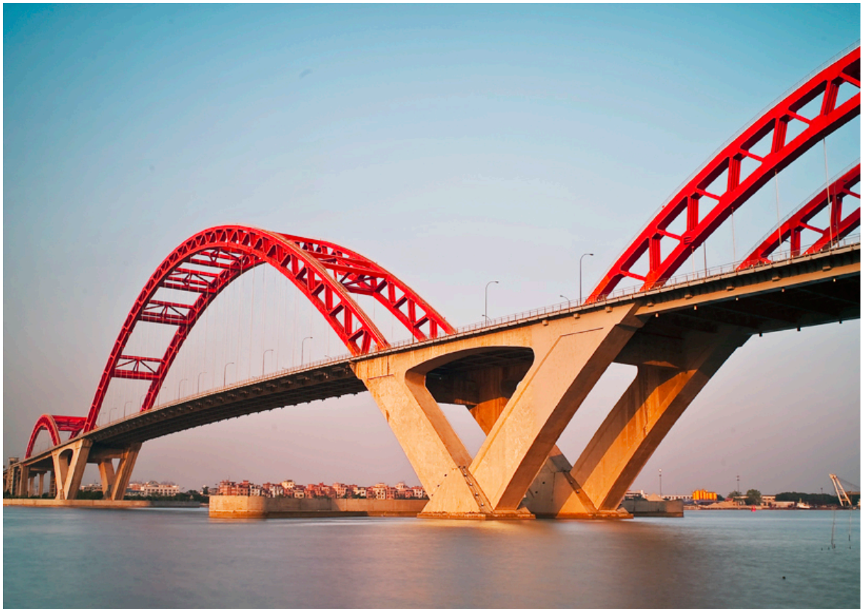
Εικόνα 3.3.3 Η γέφυρα Xinguang, Από Xinguang Bridge , του Wallace Lan, 25 Νοεμβρίου 2010, Structurae. Ανακτήθηκε 24 Αυγούστου 2024 από https://structurae.net/en/media/212837-xinguang-bridge Copyright 2010 του Wallace Lan
