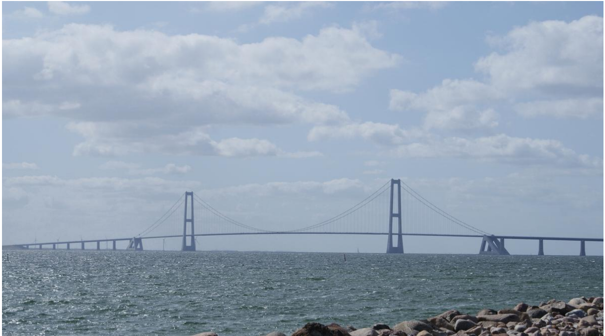
Εικόνα 3.3.7 Η κρεμαστή γέφυρα Great Belt East, Από Great Belt East Bridge , της Svenja Kramarczik, 29 Ιουνίου 2013, Structurae. Ανακτήθηκε 24 Αυγούστου 2024 από https://structurae.net/en/media/221264-great-belt-east-bridge Copyright 2013 της Svenja Kramarczik
