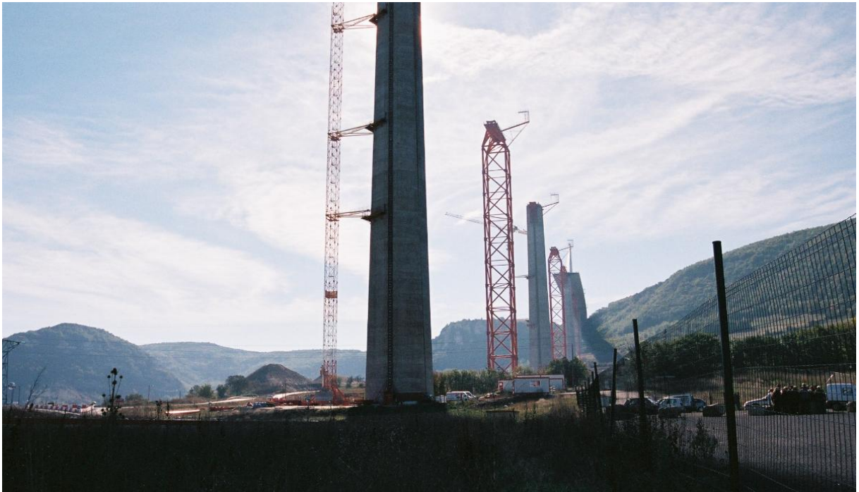
Εικόνα 5.2.25 Κατασκευή γέφυρας Millau με προσωρινούς πυλώνες, Από Millau Viaduct , του Nicolas Janberg, 25 Οκτωβρίου 2003, Structurae. Ανακτήθηκε 30 Ιουλίου 2024 από https://structurae.net/en/media/14443-millau-viaduct Copyright 2003 των CEVM Eiffage / Foster and Partners
