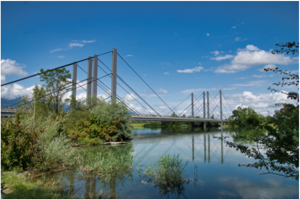
Εικόνα 4.1.8 Καλωδιωτή γέφυρα στον ποταμό Aare με παράλληλα καλώδια, Ελβετία, Από Aarebrücke Grenchen-Arch , του Nicolas Janberg, 25 Ιουλίου 2021, Structurae. Ανακτήθηκε 20 Ιουλίου 2024 από https://structurae.net/en/structures/aarebrucke-grenchen-arch Copyright 2021 του Nicolas Janberg
