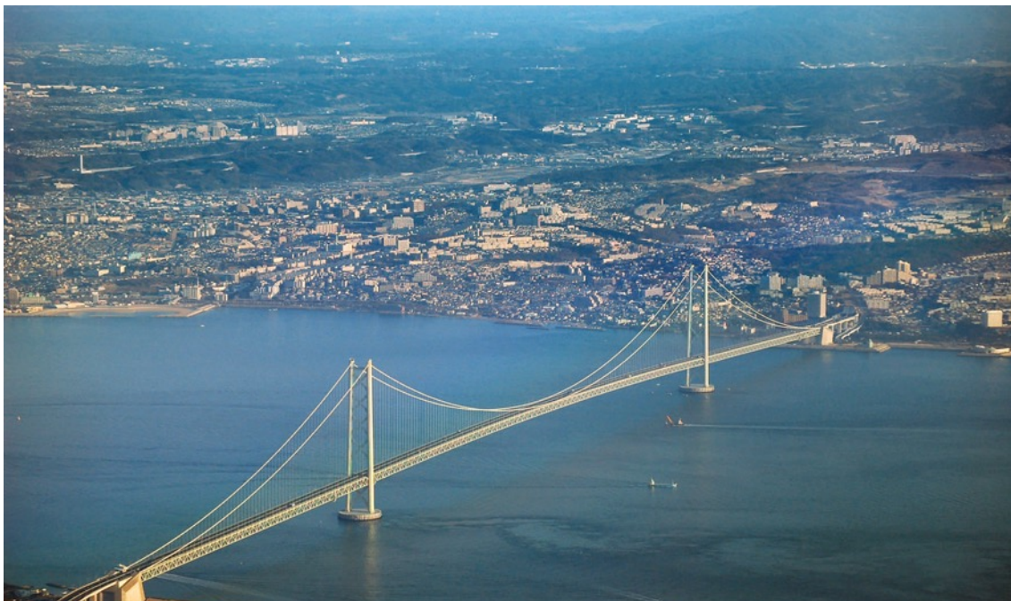
Εικόνα 5.1.1 Η γέφυρα Akashi-Kaikyō στην Ιαπωνία, Από Akashi Kaikyo Bridge , του 振, Δεκέμβριος 2005, Structurae. Ανακτήθηκε 30 Ιουλίου 2024 από https://structurae.net/en/media/222424-akashi-kaikyo-bridge Copyright 2005 του 振
