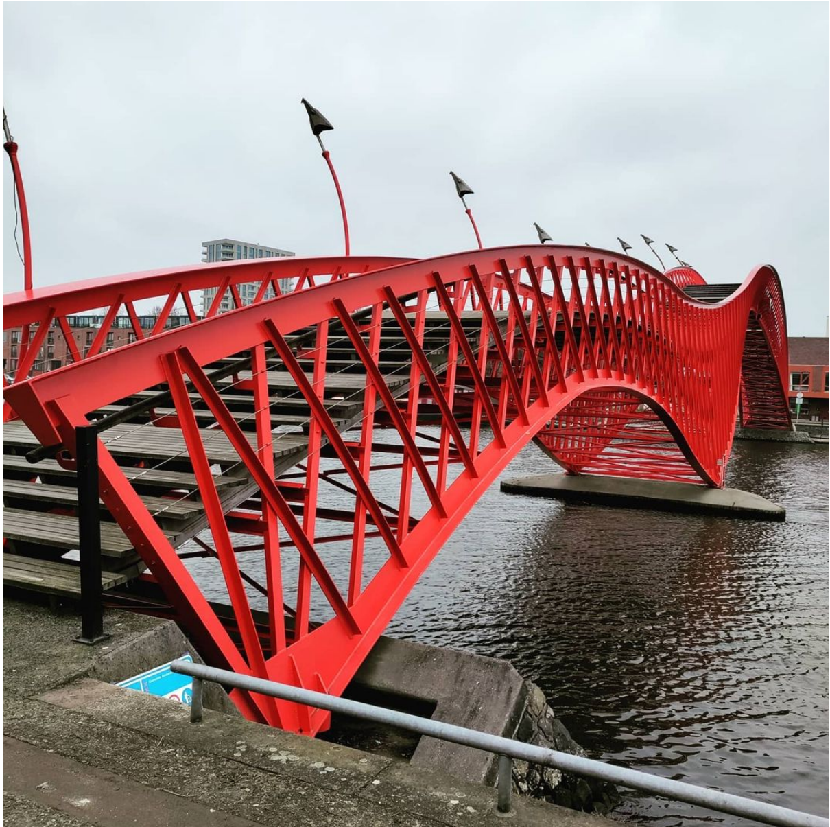
Εικόνα 4.1.5 Πεζογέφυρα με ζευκτά στο Άμστερνταμ, Ολλανδία, Από The Python Bridge | Amsterdam , της Bridges of Amsterdam, Αύγουστος 2022, Bridges.Cramberts. Ανακτήθηκε 20 Ιουλίου 2024 από https://bridges.cramberts.com/home/the-python-bridge-amsterdam/ Copyright 2022 της Bridges of Amsterdam
