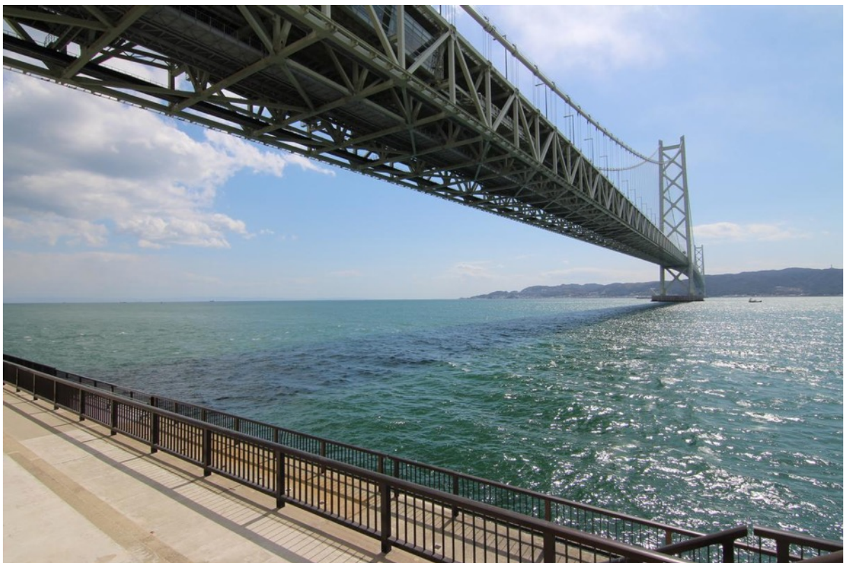
Εικόνα 5.1.2 Το κατάστρωμα της γέφυρας Akashi-Kaikyō, Από Akashi Kaikyo Bridge , της Inge Kanakaris-Wirtl, Απρίλιος 2015, Structurae. Ανακτήθηκε 30 Ιουλίου 2024 από https://structurae.net/en/media/234275-akashi-kaikyo-bridge Copyright 2015 της Inge Kanakaris-Wirtl
