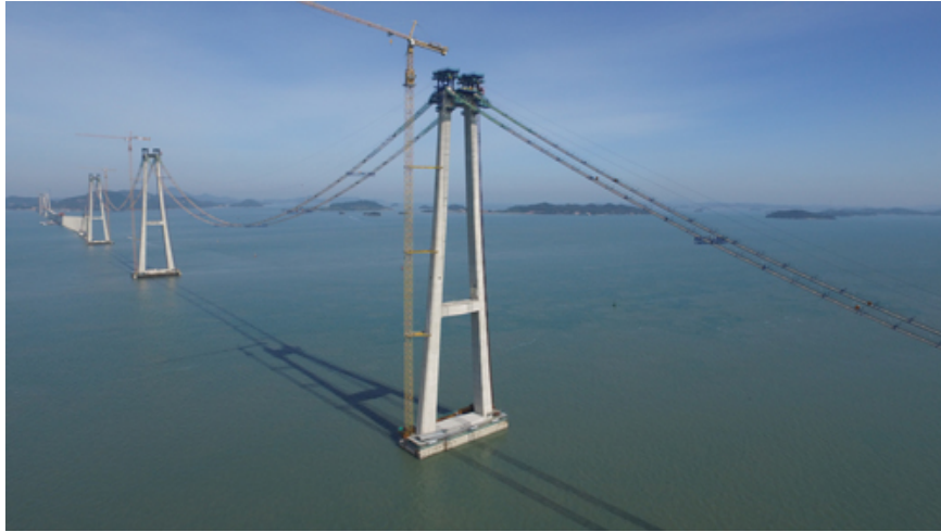
Εικόνα 5.2.16 Διαδικασία κατασκευής της γέφυρας Cheon-Sa, Από Island Hopping , του Jung-in Kim, 2018, Bridgeweb. Ανακτήθηκε 30 Ιουλίου 2024 από https://www.bridgeweb.com/Island-hopping/4682 Copyright 2018 του Jung-in Kim
