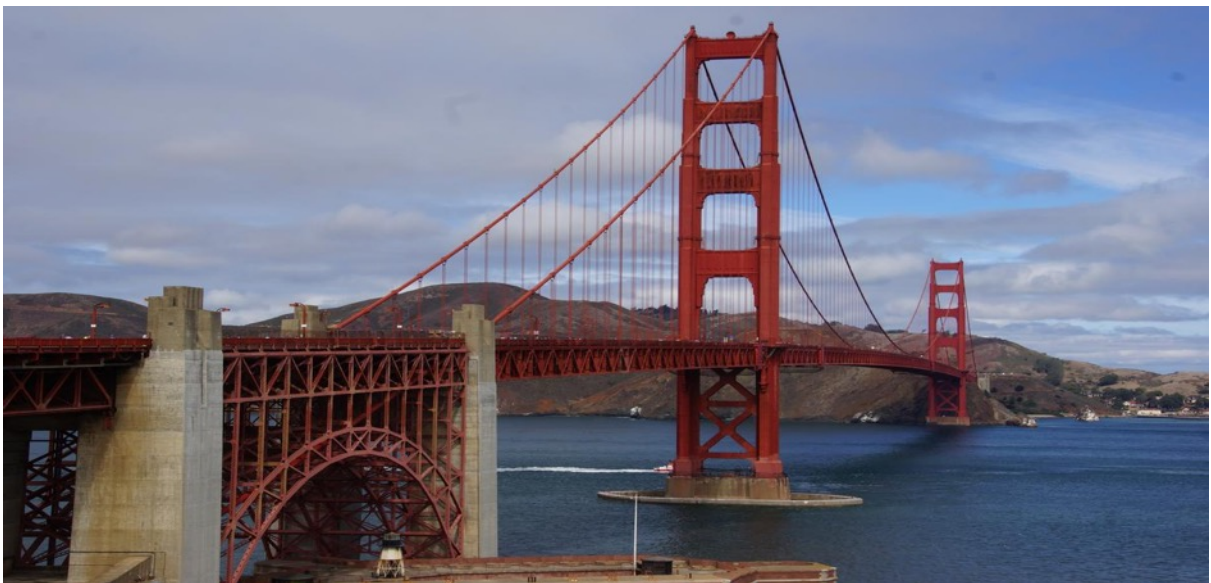
Εικόνα 1.2.1 Η γέφυρα Golden Gate, Από Golden Gate Bridge , του Nicolas Janberg, 24 Σεπτεμβρίου 2014, Structurae. Ανακτήθηκε 24 Αυγούστου 2024 από https://structurae.net/en/media/229930-golden-gate-bridge Copyright 2014 του Nicolas Janberg
