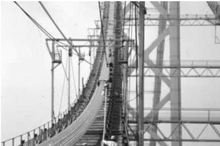
Εικόνα 5.2.9 Διαδικασία ανάρτησης καλωδίων της γέφυρας Akashi-Kaikyō, Από «Technology of the Akashi-Kaikyō bridge», του Kitagawa M., 2004, Στο Structural control and health monitoring , τ.11, σελ.85., Copyright 2004 του M. Kitagawa
