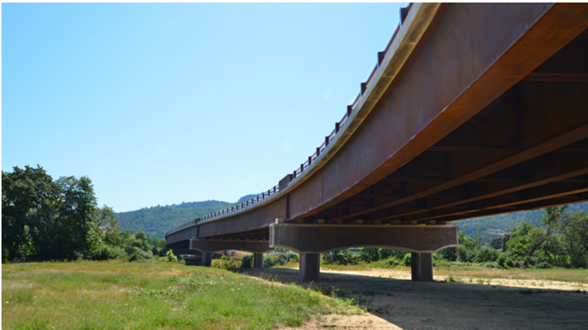
Εικόνα 4.2.2 Γέφυρα με χαλύβδινες πλατύπελμες δοκούς στις Η.Π.Α, Από I-Girder Bridge , της American Institute of Steel Construction, Σεπτέμβριος 2014, AISC. Ανακτήθηκε 20 Ιουλίου 2024 από https://www.aisc.org/modernsteel/news/2016/september/updated-i-girder-bridge-resource-available/ Copyright 2014 της American Institute of Steel Construction
