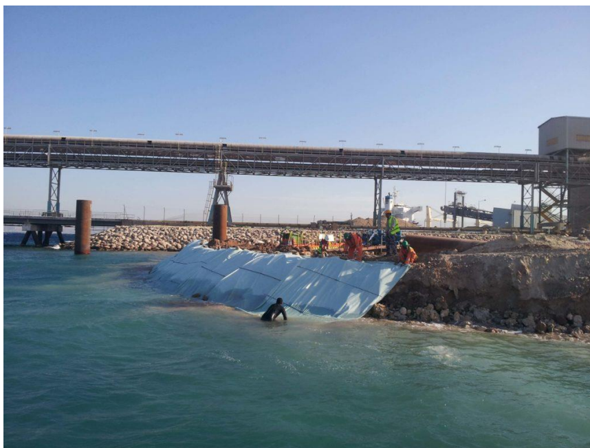
Σχήμα 1.31.: Τοποθέτηση γεωφάσματος (barracudaservice.com)
