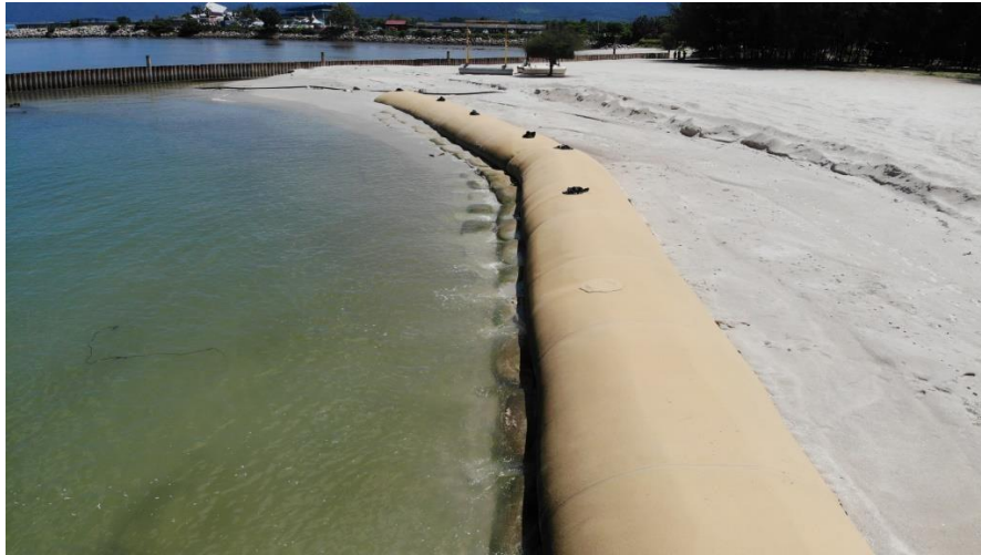
Σχήμα 1.15.: Κυματοθραύστης από γεωσωλήνες (gssb.com.my)
