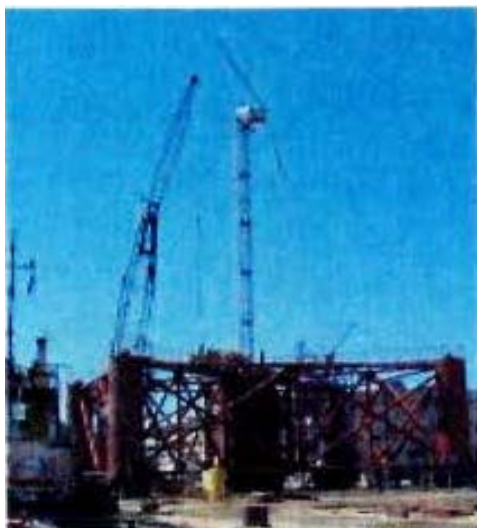
Εικόνα 19. Βοηθητικός γερανός Ανύψωση ατράκτου.
