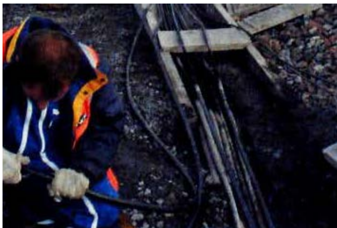
Εικόνα 14. Διάνοξη τάφρων διέλευσης καλωδίων.
