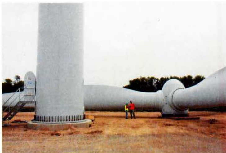
Εικόνα 15. Τοποθέτηση κεντρικής βάσης.
