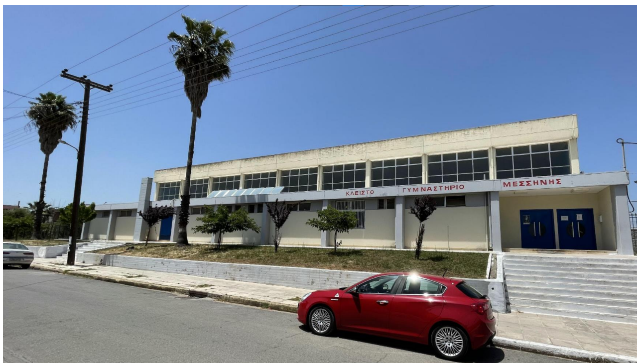
Εικόνα 5.1 : Πρόσοψη κτηρίου(Νότια Πλευρά).
