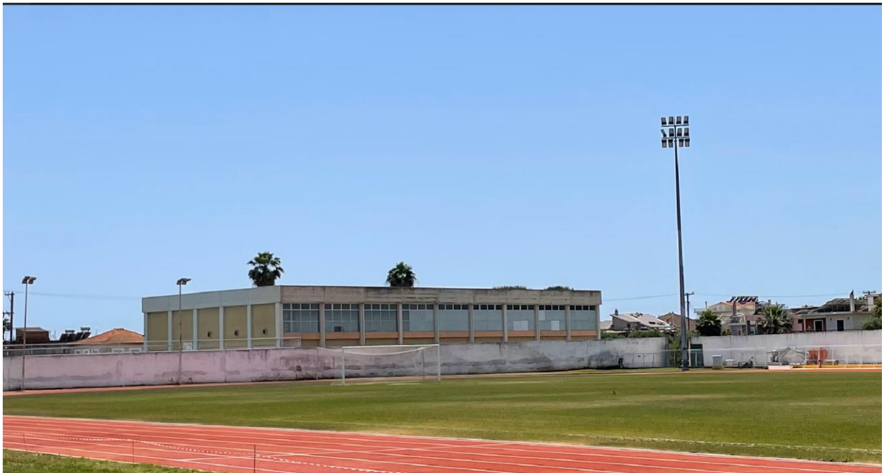
Εικόνα 5.2: Βόρεια (πίσω) όψη από την πλευρά του δημοτικού σταδίου.
