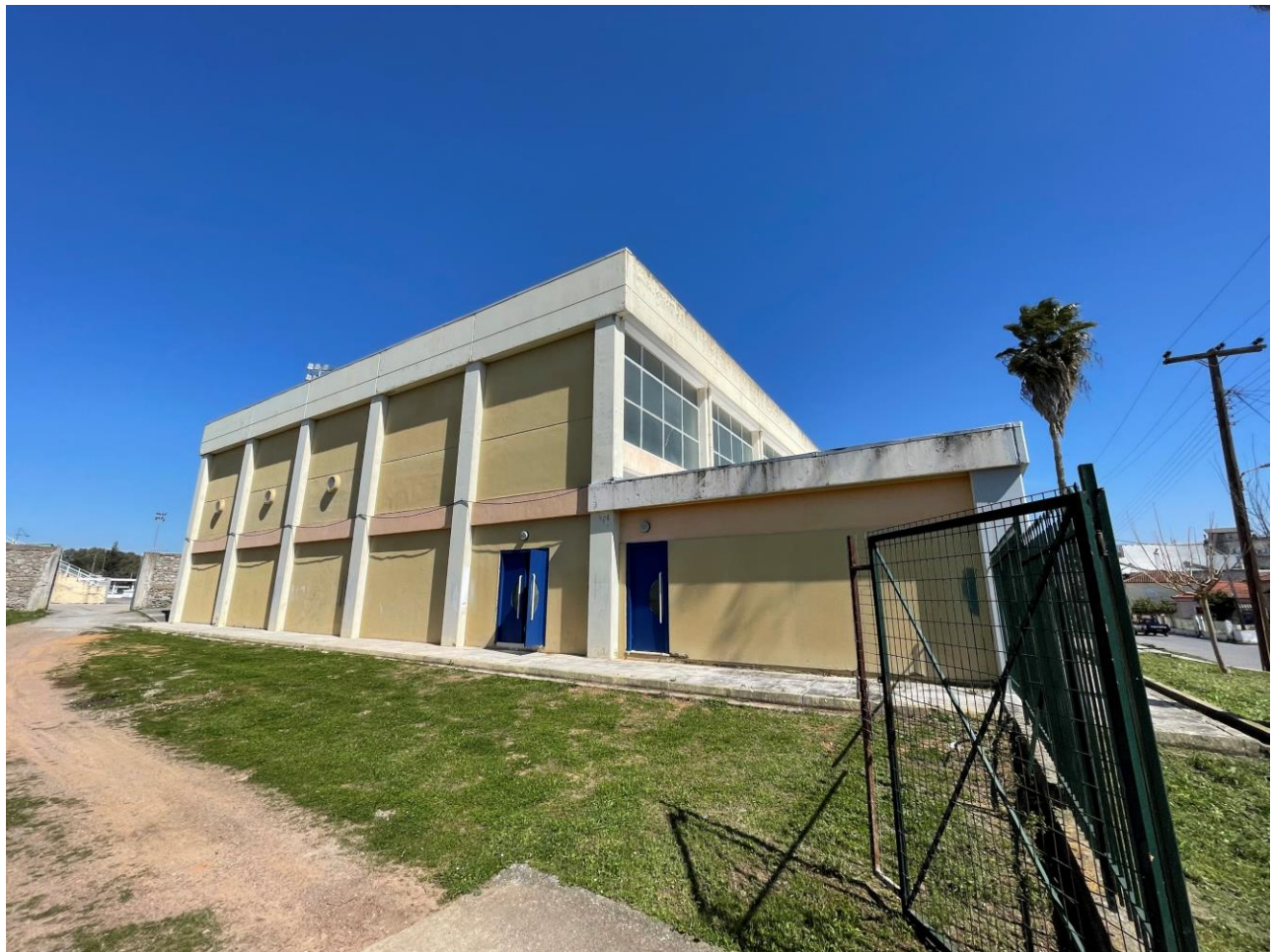
Εικόνα 5.3: Δυτική όψη του κτηρίου.
