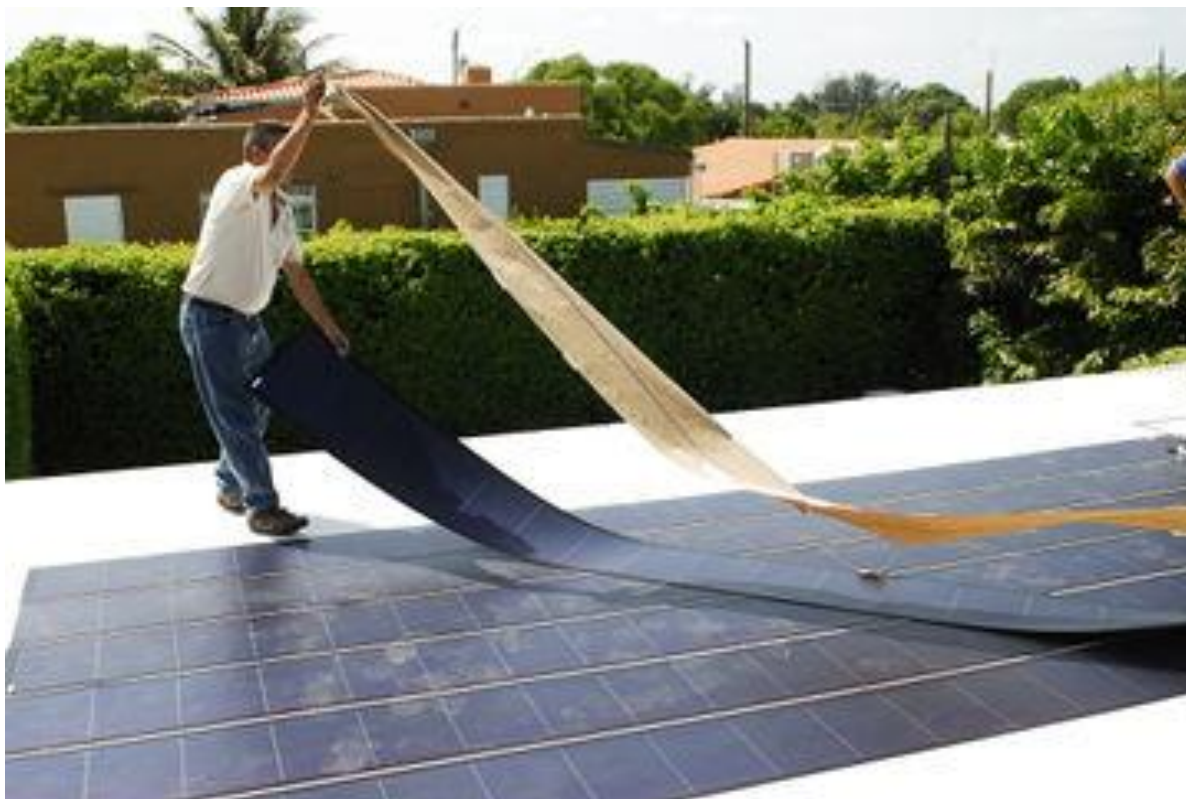
Εικόνα 33. Τοποθέτηση ΦΒ λεπτής μεμβράνης
