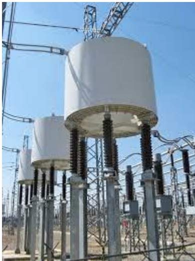
ΕΙΚΟΝΑ 47. ΠΗΝΙΟ ΕΞΟΜΑΛΥΝΣΗΣ (SMOOTHING REACTOR).
