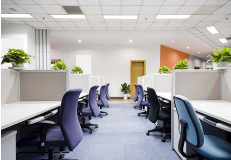
Εικόνα 3-1 Φωτιστικά οροφής πάνελ ( https://www.warehouse-lighting.com/blogs/lighting-application-suggestions/different-types-of-office-lighting )
