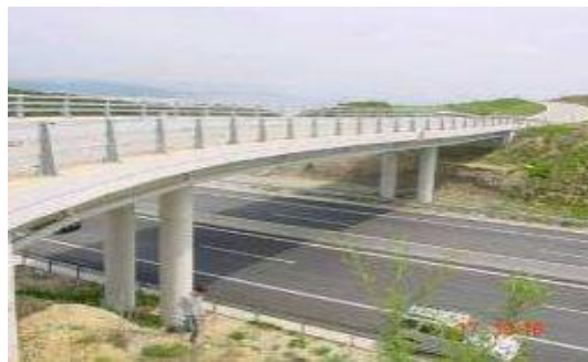
εικόνα 1.6.7: Πλαισιακός φορέας με κατακόρυφα μεσόβαθρα (φωτογραφία από το διαδίκτυο)
