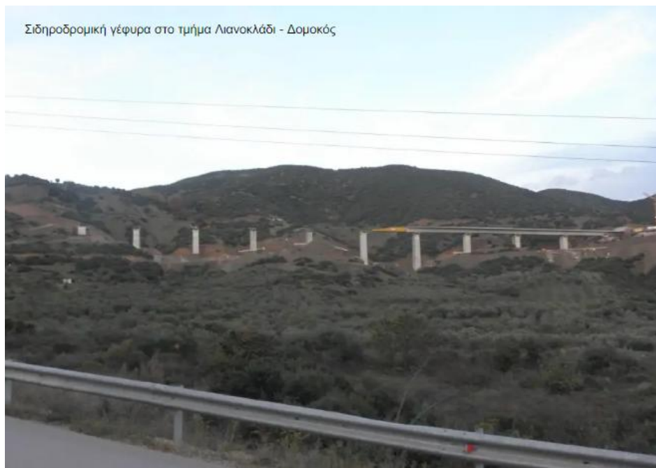
εικόνα 2.5.9.7: σιδηροδρομική γέφυρα στο τμήμα Λιανοκλάδι – Δομοκός (Σ.Σταθόπουλος)
