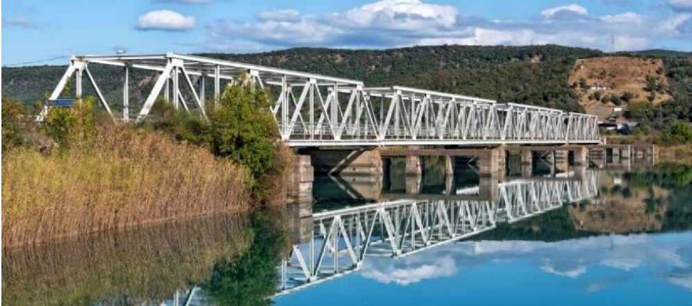
εικόνα 1.6.4: Μεταλλική Γέφυρα Μασσουκίου (Αχελώος) (Σ. Σταθόπουλος)
