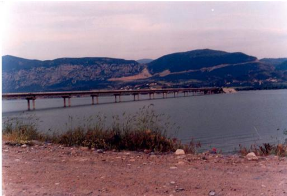
εικόνα 2.5.2: Γέφυρα Ρυμνίου (φωτογραφία από το διαδίκτυο)
