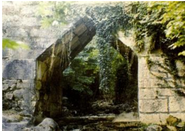
εικόνα 1.2.2: Γέφυρα στην Ελεύθερνα Κρήτης (4ος αιών π.Χ.) Μήκος 9.00m, , πλάτος 5.35m, άνοιγμα =3.83m, συνολικό ύψος=4.60m, ελεύθερο ύψος=1.85m (Σ. Σταθόπουλος)
