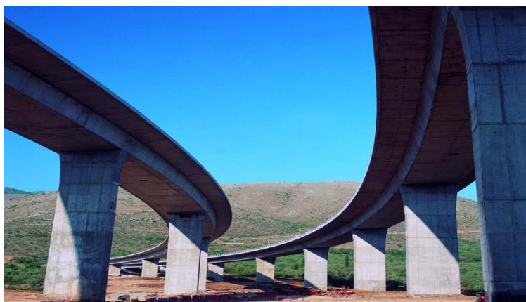
εικόνα: Η γέφυρα της Κρυσταλλοπηγής
