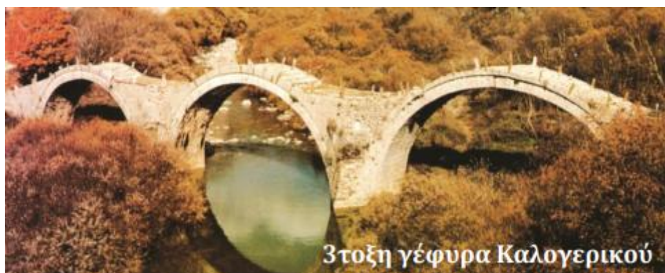
εικόνα 1.2.8: 3Τοξη Γέφυρα Καλογερίκου (Σ.Σταθόπουλος)
