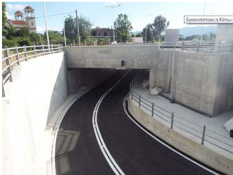
εικόνα 1.6.12: Κάτω διάβαση στη θέση Σαράγια, Δήμος Τρικκαίων (φωτογραφία από διαδίκτυο)
