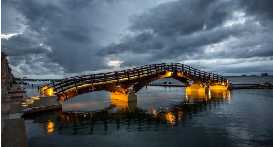
εικόνα 1.6.1: Ξύλινη Γέφυρα της Λευκάδας (φωτογραφία από το διαδίκτυο)
