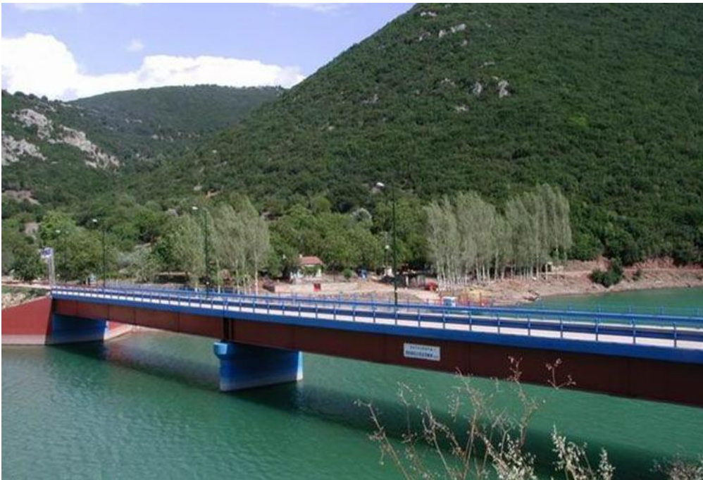
εικόνα 1.6.5: Σύμμικτη Γέφυρα (Ποταμός Λάδωνας) (Σ. Σταθόπουλος)
