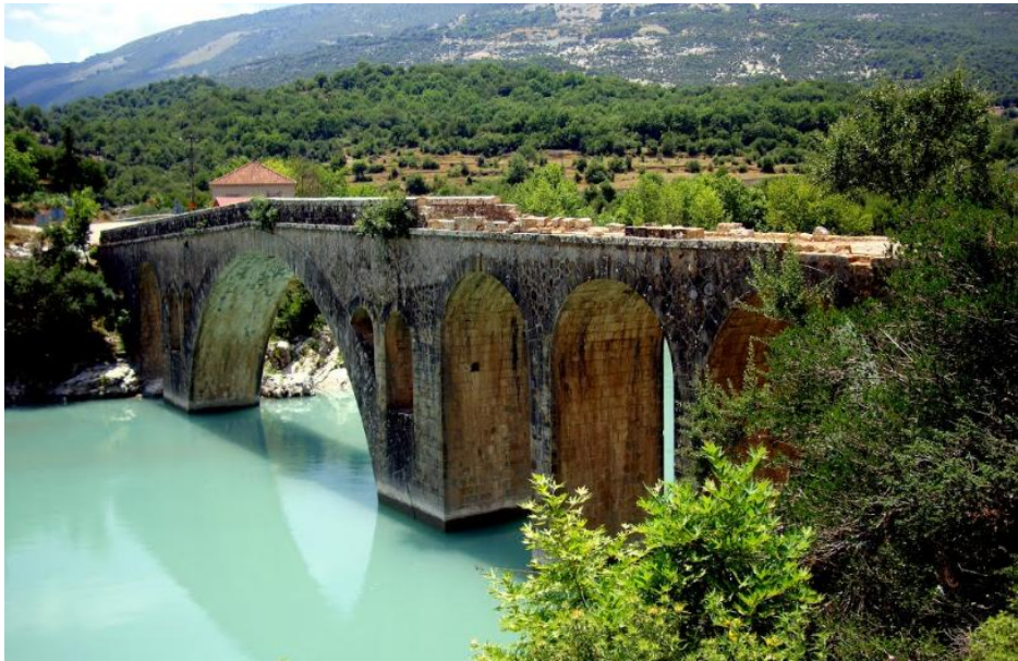
εικόνα 1.6.2: Λίθινη Γέφυρα Αυλακίου (Σ. Σταθόπουλος)
