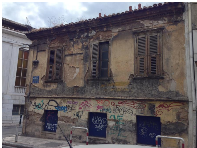
Εικόνα 12. Όψη κτιρίου επί της οδού Λυσικράτους 18.
