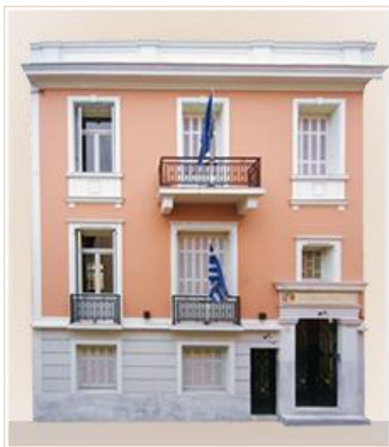
Εικόνα 9. Όψη κτιρίου επί της οδού Λυσικράτους 12.
