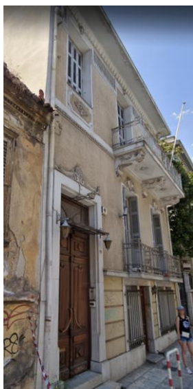
Εικόνα 11. Όψη κτιρίου επί της οδού Λυσικράτους 16.
