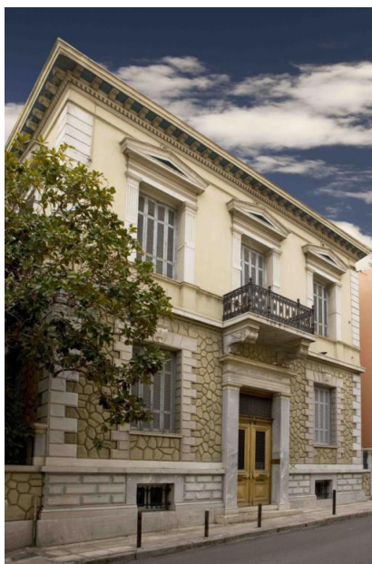
Εικόνα 10. Όψη κτιρίου επί της οδού Λυσικράτους 14.
