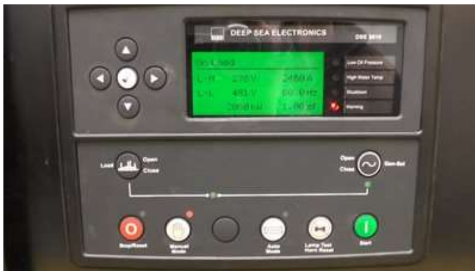
Εικόνα 5-5 Πίνακας ελέγχου H/Z [ https://www.generatorsource.com/How_Generators_Work.aspx ]
