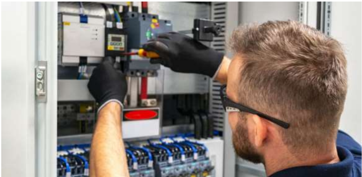
Εικόνα 1-2 Συναρμολόγηση ηλεκτρολογικού πίνακα σε μεγάλο κτήριο κοινής ωφέλειας [https://fusionelectrics.co.uk/commercial-electrical-wiring-and-how-it-compares-to-residential/]
