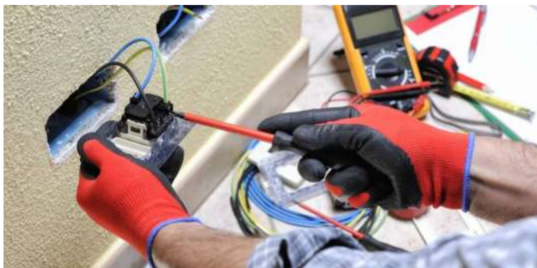
Εικόνα 1-1 Διαδικασία τοποθέτησης οικιακής ηλεκτρολογικής εγκατάστασης [ https://fusionelectrics.co.uk/commercial-electrical-wiring-and-how-it-compares-to-residential/ ]
