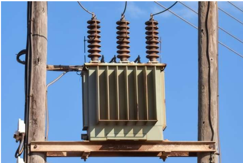
Εικόνα 3-9 Τριφασικός μετασχηματιστής [ https://studyelectrical.com/2019/11/three-phase-transformer.html ]
