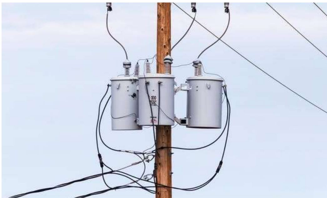
Εικόνα 3-8 Τριφασική Συστοιχία μονοφασικών Μετασχηματιστών [ https://studyelectrical.com/2019/11/three-phase-transformer.html ]
