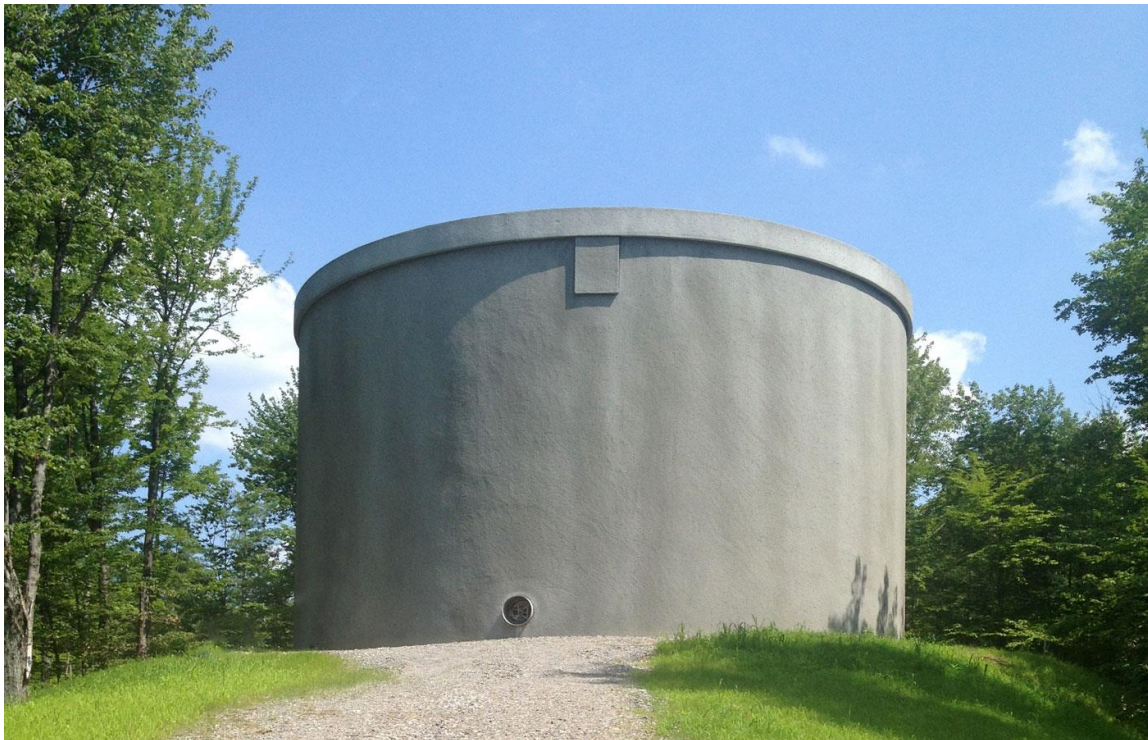
Εικόνα 25: Δεξαμενή σκυροδέματος αποθήκευσης νερού
