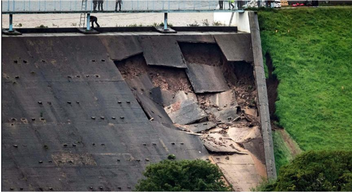
Σχήμα 3.8: Ζημιά λόγω τριβής και πίεσης
