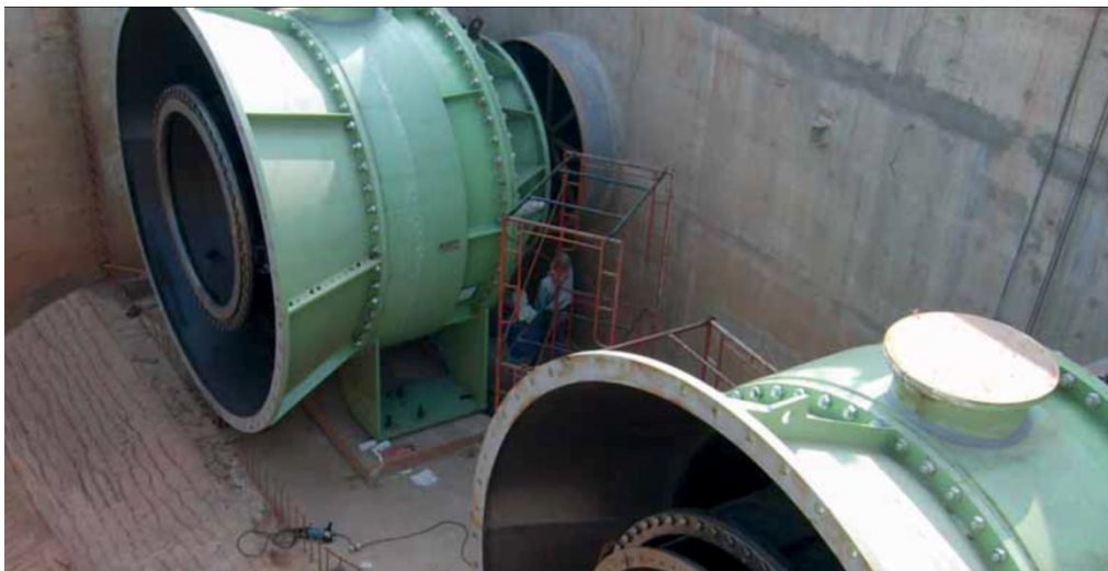
Σχήμα 4.5: Κωνικές βαλβίδες
