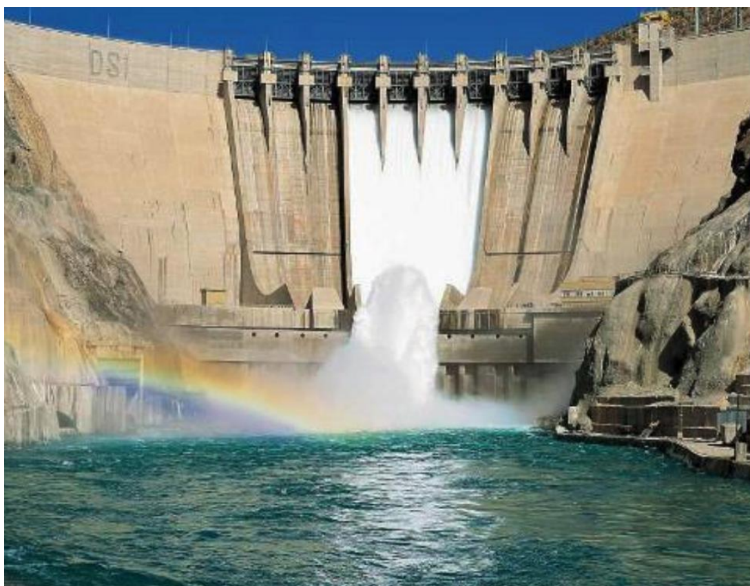
Σχήμα 3.7: Άλμα του σκι του φράγματος Karakaya στην Τουρκία [23]
