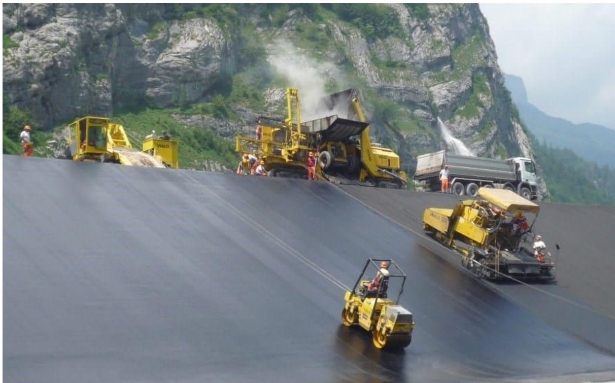
Σχήμα 3.3: Πρόσοψη από ασφαλτικό σκυρόδεμα (Ελβετία)
