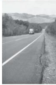
Edge crack
