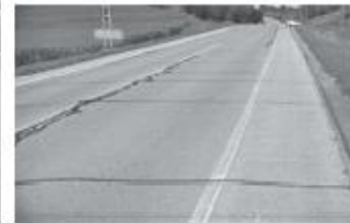
Thermal cracking
