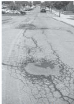
Fatigue crack
