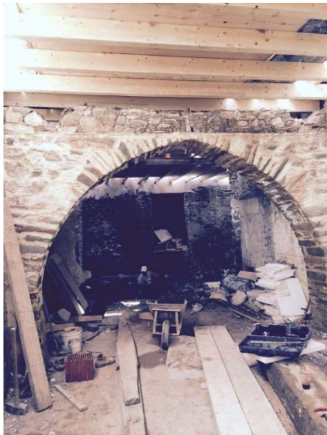
Εικόνα 1.3.4: Άποψη καμάρας στον χώρο ΙΙ (υφιστάμενη κατάσταση)
