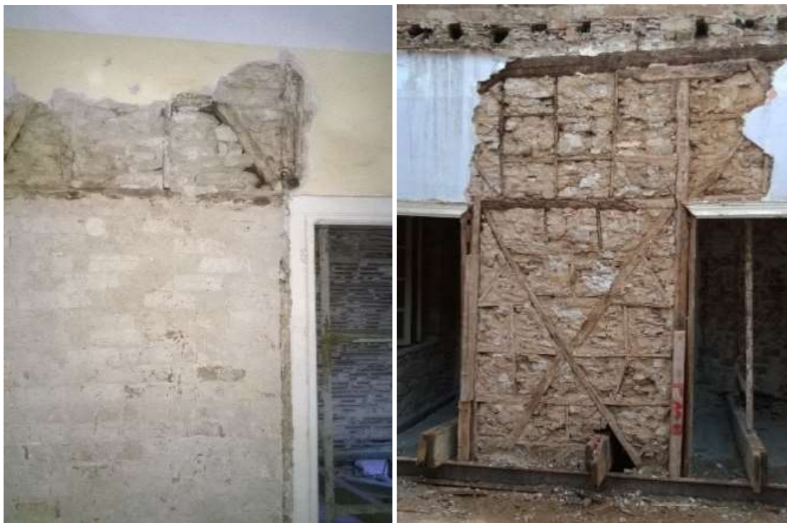
Εικόνα 2.1.2-1: Αποψη εσωτερικής τοιχοποιίας (Τσατμάδες). Σελ.23
