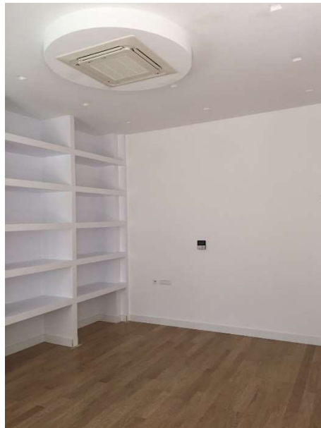
Εικόνα 4.6.3-2: Τελική επιφάνεια ψευδοροφών.
