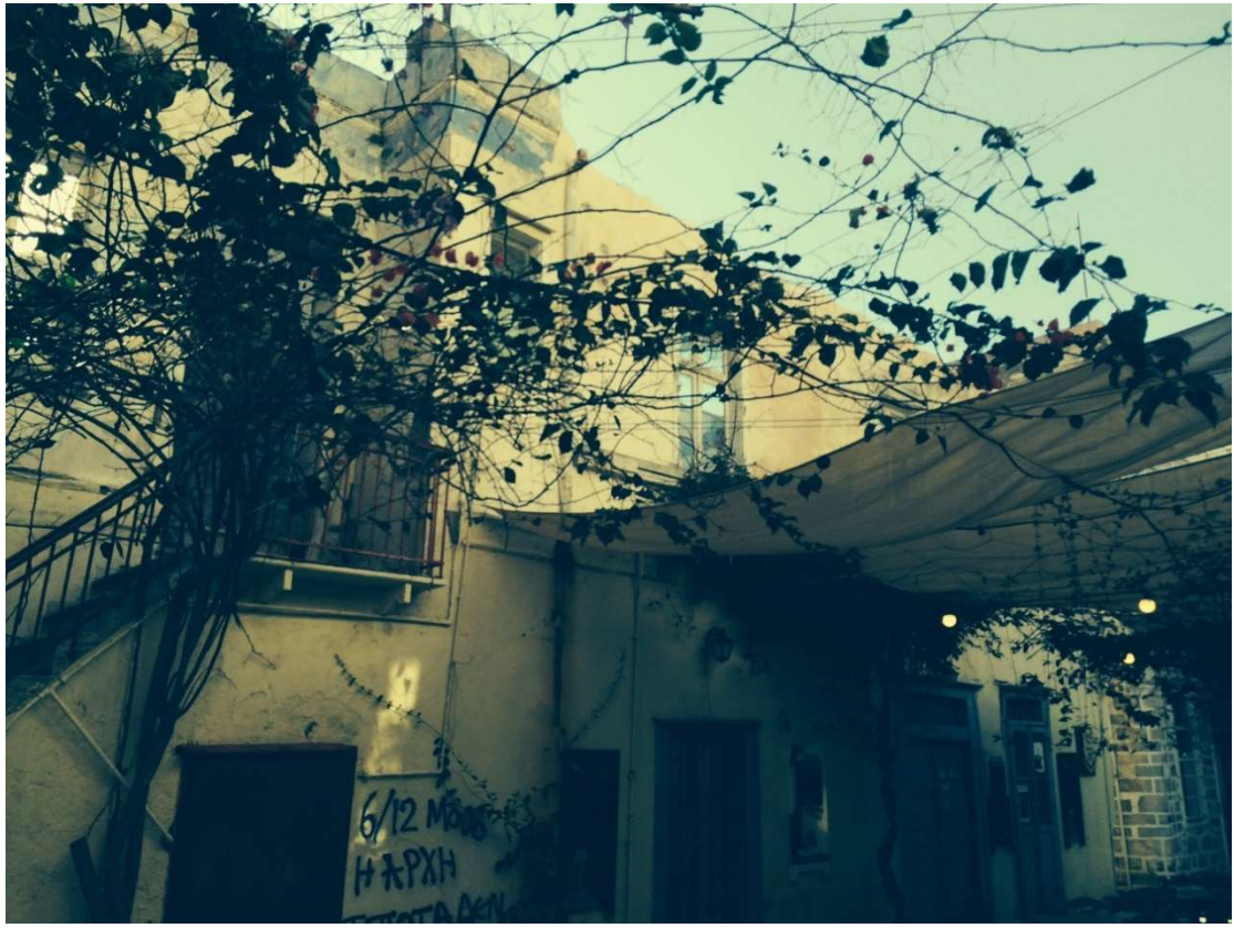
Εικόνα 3-3: Άποψη της πρόσοψης του κτιρίου. Είναι εμφανή η έλλειψη της στέγης (μέσω των παραθύρων).σελ.33
