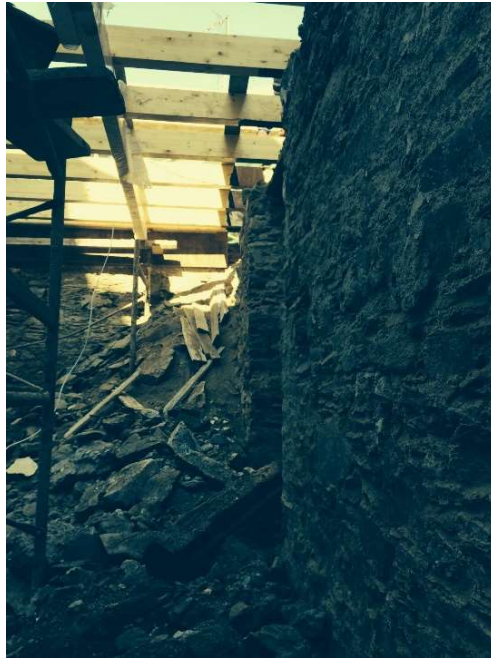
Εικόνα 2.2.2: Τμήμα δαπέδου βατού δώματος κατά την φάση αποκατάστασης του. Διακρίνονται τα προϊόντα κατάρρευσης,σελ.27
