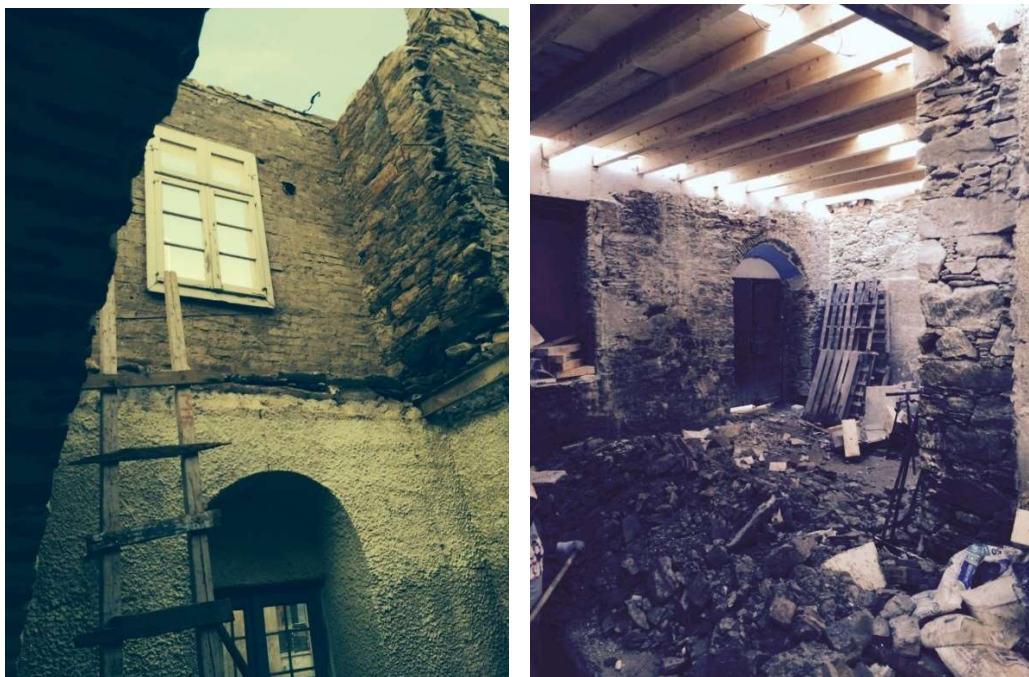
Εικόνα 2.3-2: Ανακουφιστικό τόξο στο ανώφλι των ανοιγμάτων του ισόγειου
