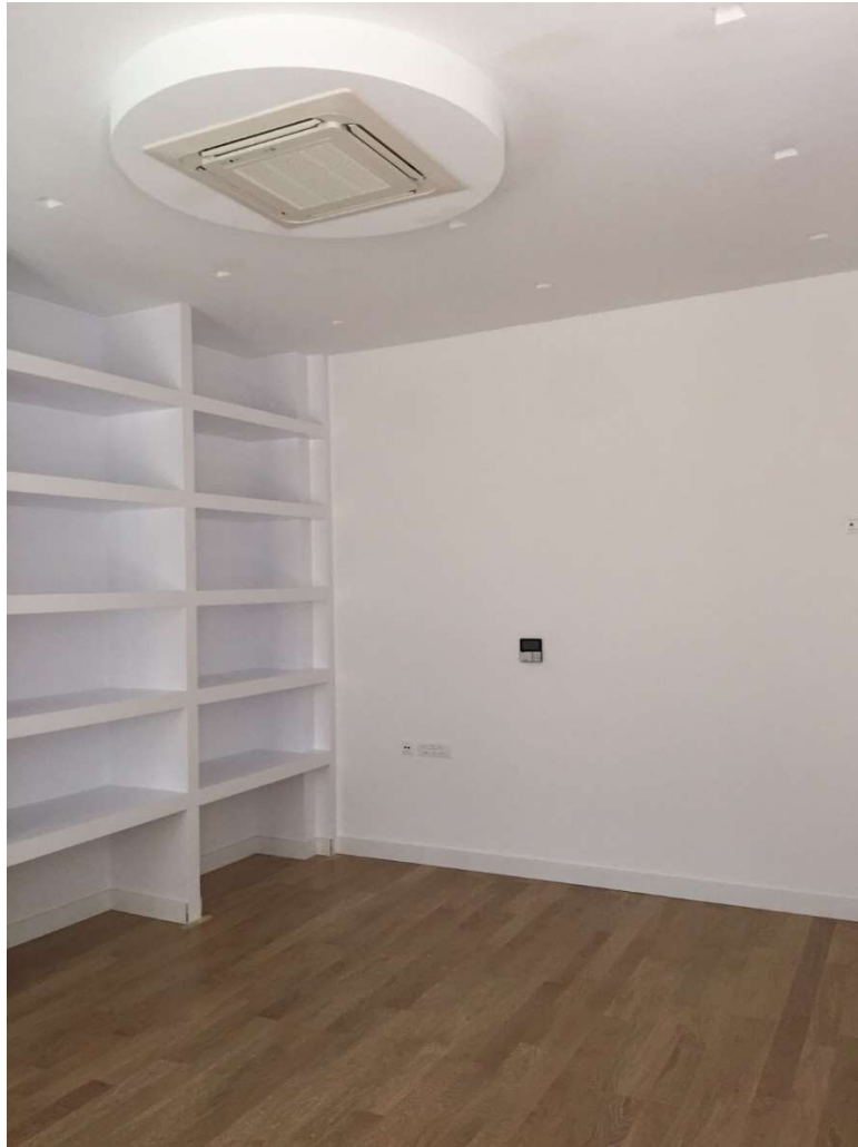
Εικόνα 4.6.2-2: Τελική επίστρωση δαπέδου Α ορόφου.
