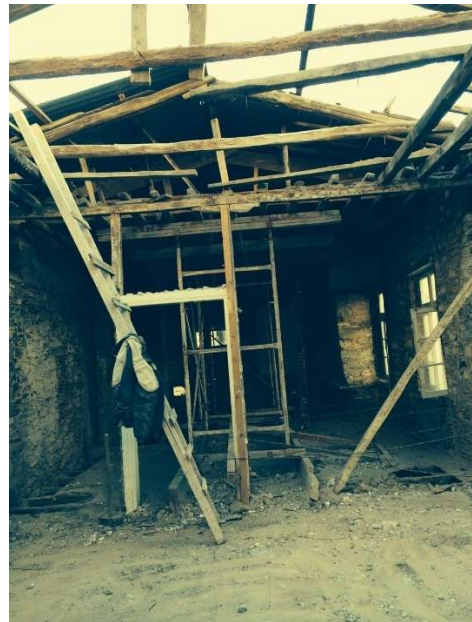
Εικόνα 1.3.5: Άποψη στέγης Α ορόφου (υφιστάμενη κατάσταση)
