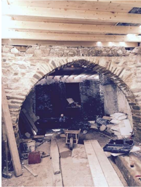
Εικόνα 1.3.4: Αποψη καμάρας στον χώρο Π (υφιστάμενη κατάσταση) .σελ15
