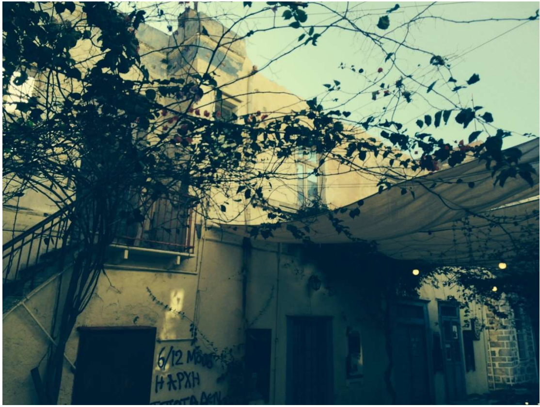
Εικόνα 3-3: Άποψη της πρόσοψης του κτιρίου. Είναι εμφανή η έλλειψη της στέγης (μέσω των παραθύρων).
