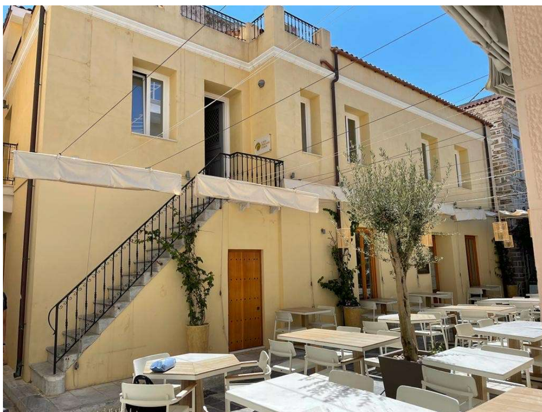
Εικόνα 4: Πρόσψη του κτιρίου επί της οδού Κλώνος & Κυπαρίσσου Στεφάνου μετά την αποκατάσταση
