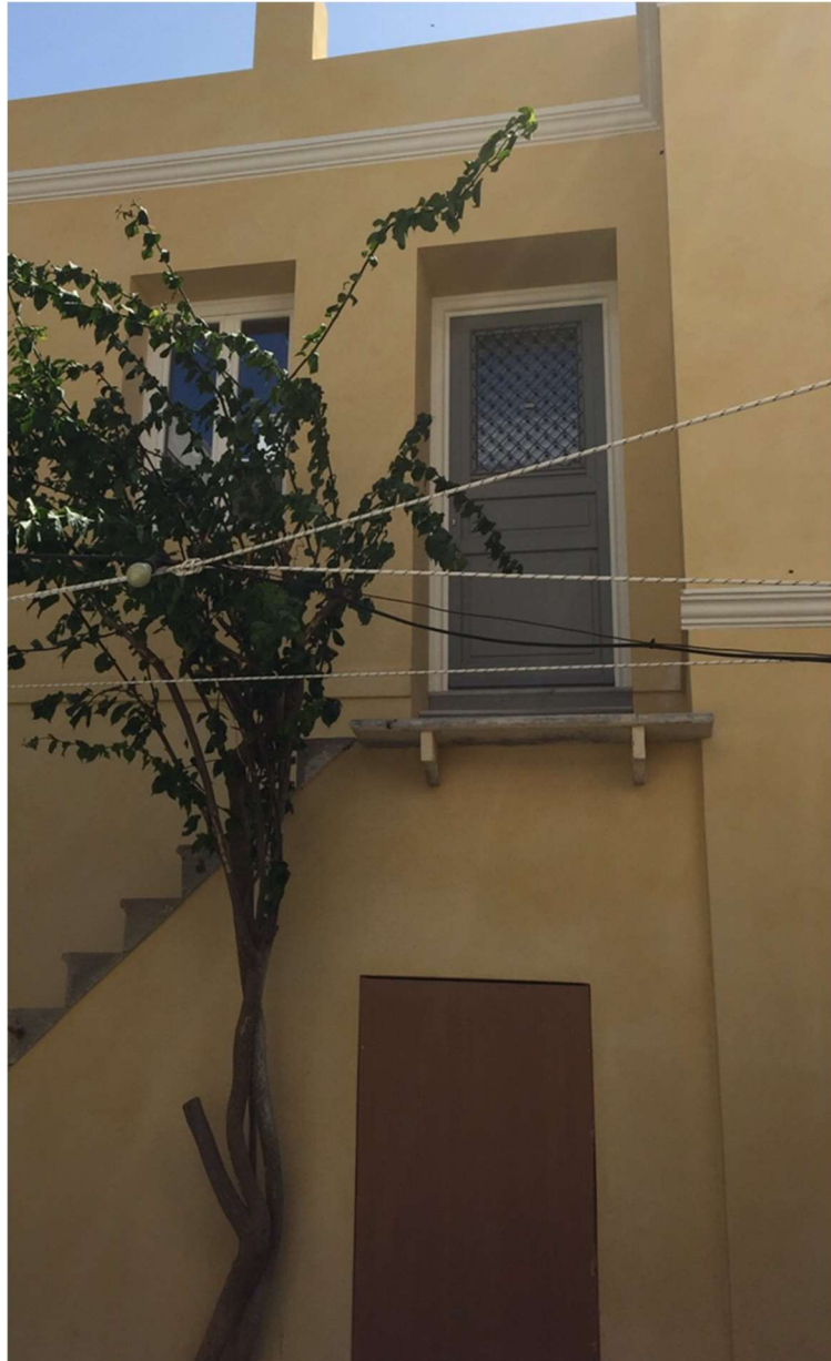
Εικόνα 4.5.8: άποψη μαρμάρινου εξώστη.
