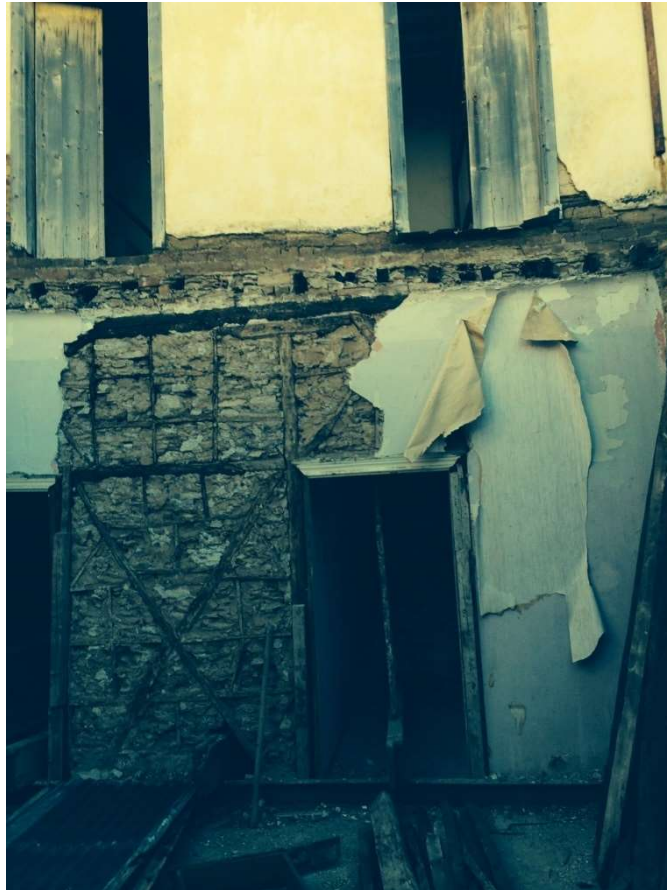
Εικόνα 3.1.3: Τμήμα μεσοπατώματος του Α ορόφου, στον χώρο Α4.
