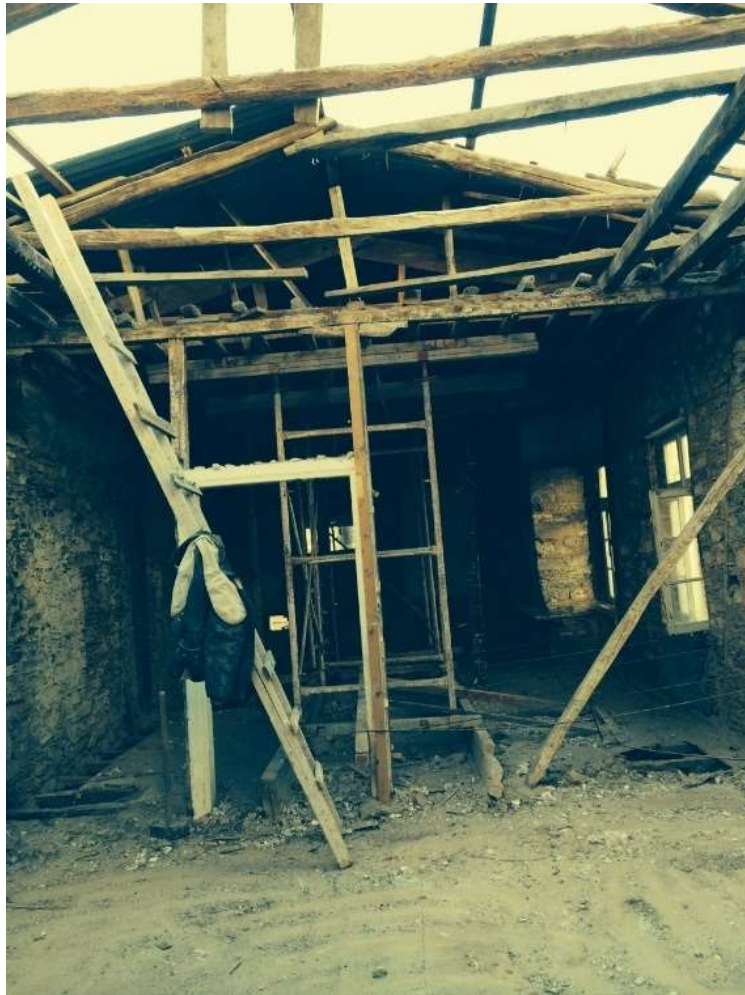
Εικόνα 2.1.3-2: Ξύλινα δοκάρια δαπέδου δώματος-επιστέγασης Α ορόφου. Σελ. 26
