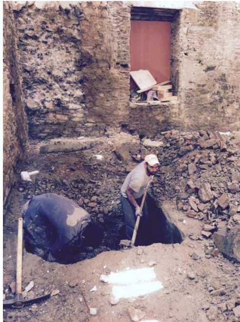
Εικόνα 2.1.1: Τομή του εδάφους στον χώρο του δωματίου 100 για την αξιολόγηση των θεμελίων.σελ.22
