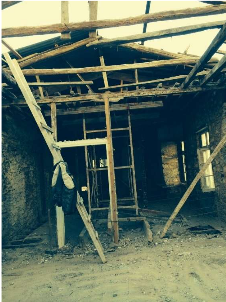
Εικόνα 2.1.3-2: Ξύλινα δοκάρια δαπέδου δόματος-επιστέγασης Α ορόφου
