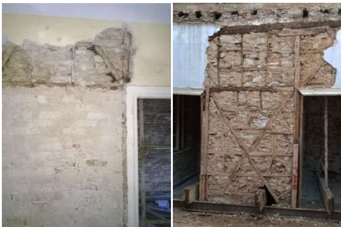
Εικόνα 2.1.2-1: Αποψη εσωτερικής τοιχοποιίας (Τσατμάδες).
