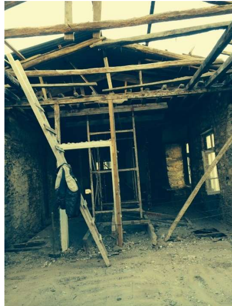
Εικόνα 1.3.5: Αποψη στέγης Α ορόφου (υφιστάμενη κατάσταση). Σελ.15
