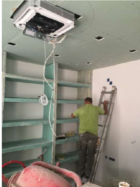
Εικόνα 4.6.3-1: Εγκατάσταση ψευδοροφών με τους απαραίτητους εξοπλισμούς κλιματισμού και φωτισμού.
