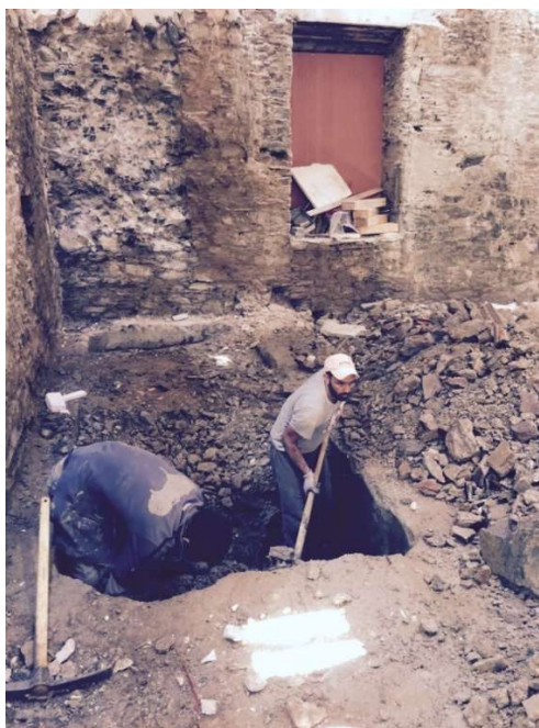
Εικόνα 2.1.1: Τομή του εδάφους στον χώρο του δωματίου 100 για την αξιολόγηση των θεμελίων
