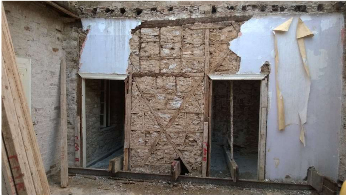
Εικόνα 2.1.3-1: Ξύλινα δοκάρια δαπέδου δώματος-επιστέγασης Α ορόφου
