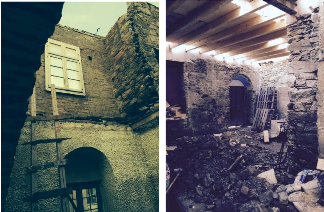
Εικόνα 2.3-2: Ανακουφιστικό τόξο στο ανώφλι των ανοιγμάτων του ισογείου. Σελ.30
