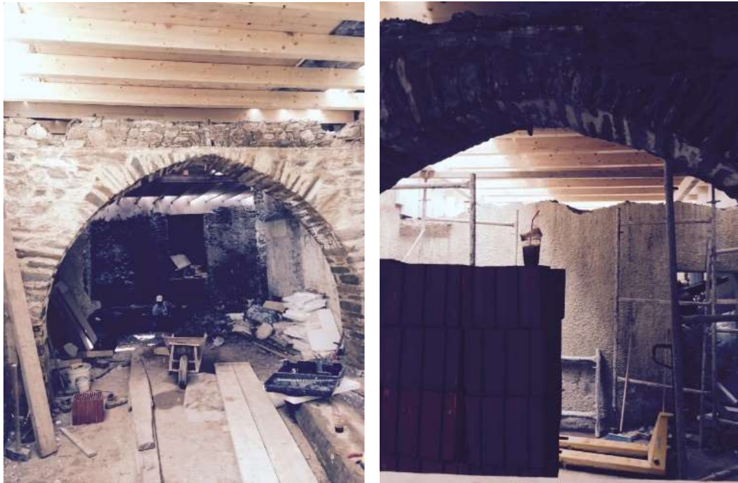
Εικόνα 2.1.2-2: Αποψη χώρου με καμάρα
