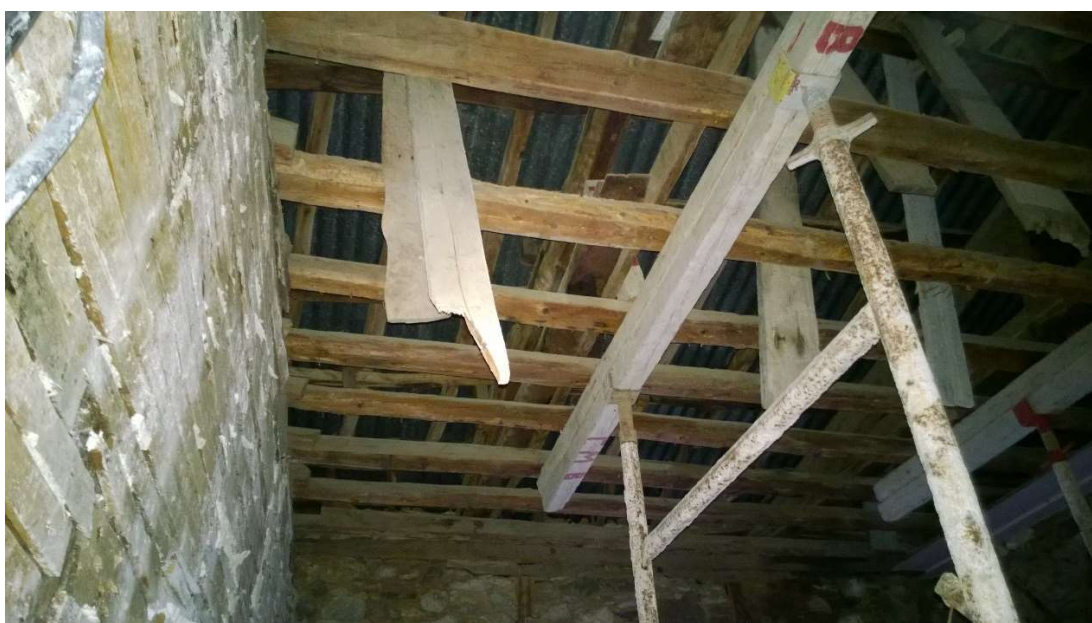
Εικόνα 2.2.3: οροφή στους χώρους A1, A2 με εμφανή τον σκελετό της στέγης
