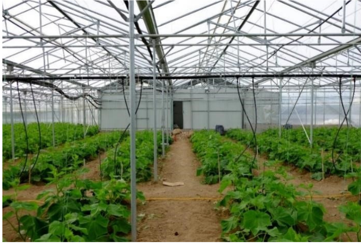
Εικόνα 8: Θερμοκήπιο με χαλύβδινα σκελετικά στοιχεία.
