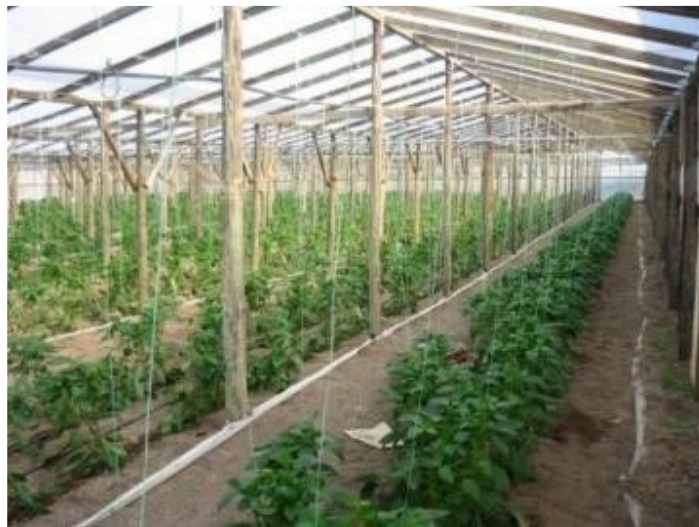
Εικόνα 7: Θερμοκήπιο με ξύλινο σκελετό.
