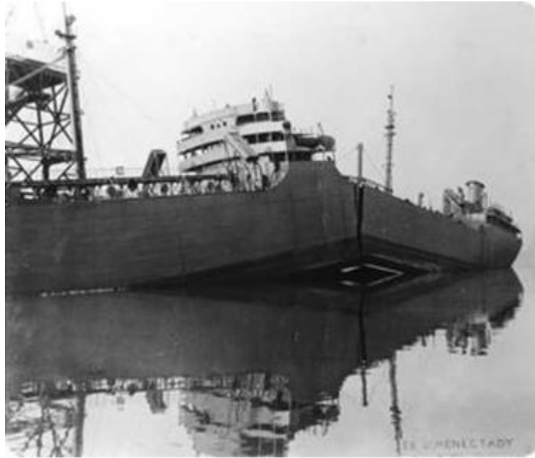
Εικόνα 5: Χαρακτηριστική φωτογραφία θραύσης πλοίου τύπου “Liberty Ships”
