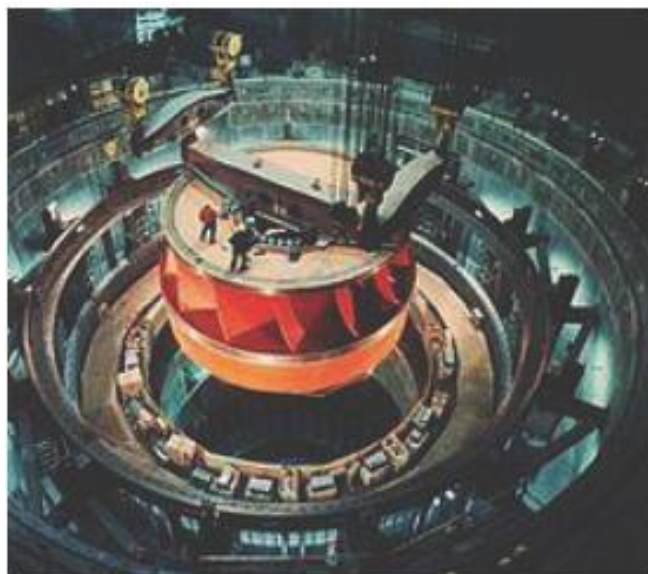
Εικόνα 4-4 Φράγμα Grand Coulee (ΗΠΑ), Υδροστρόβιλος Francis
