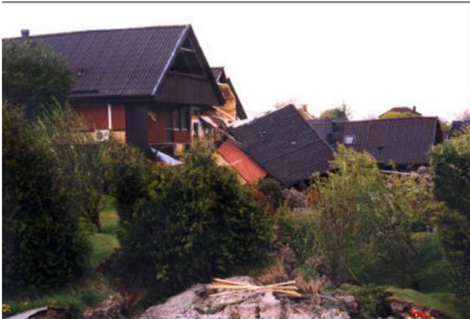
Εικόνα 8 Κατεστραμμένο οίκημα λόγω κατολίσθησης
