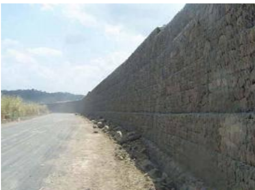
γ) τοιχώματα με συρματοκιβώτια δρόμων
