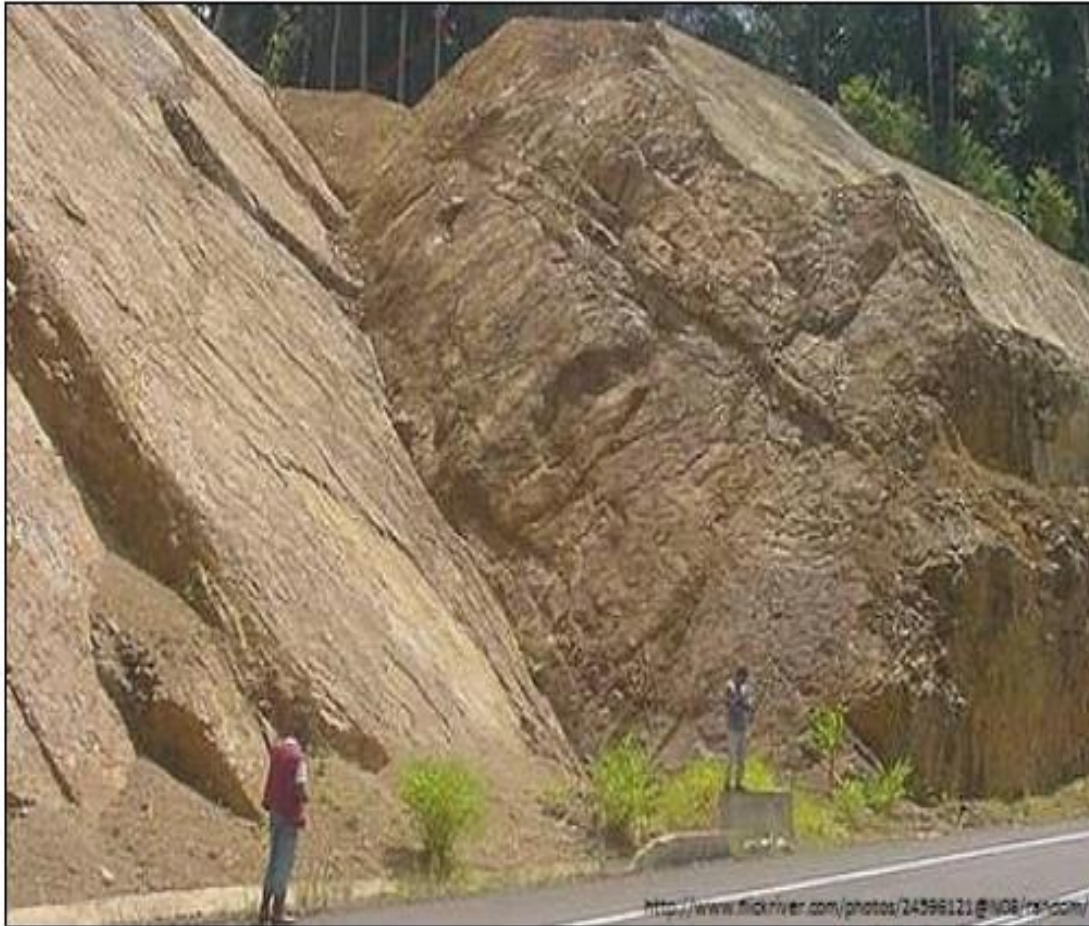
Εικόνα 4 Σφηνοειδής ολίσθηση, φωτογραφία του Omen Necrofis
