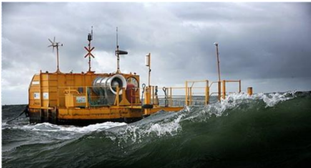
Εικόνα 4-22 Σημαντήρας Ocean Energy με στρόβιλο Wells. Αναπαράγεται με άδεια από την Ocean Energy
