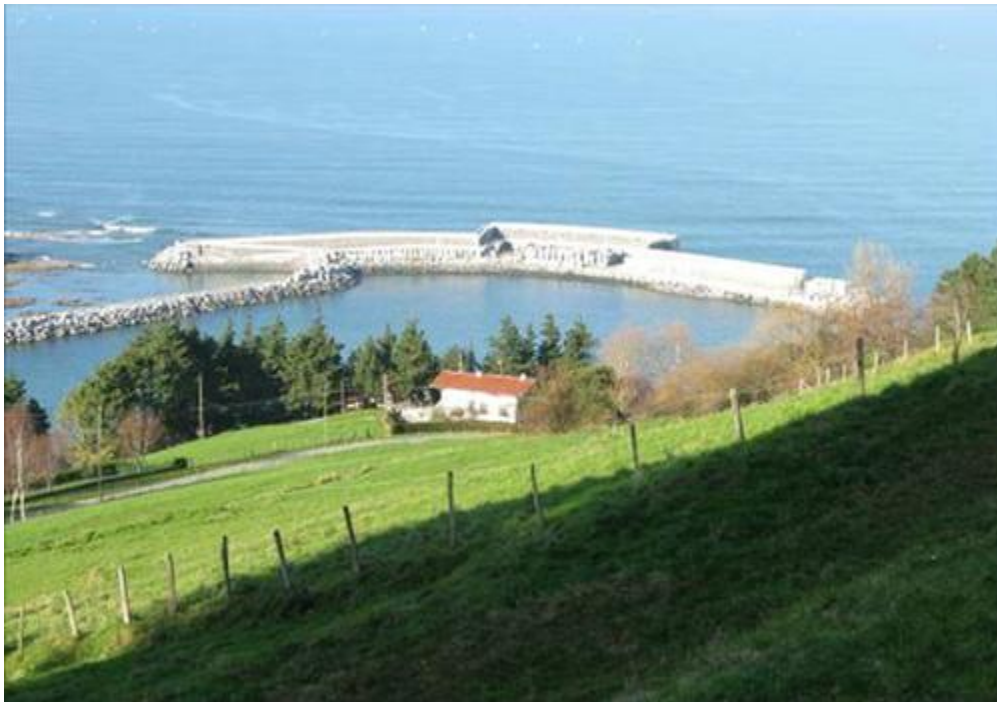
Εικόνα 4-25 Κυματοθραύση Mutriku που περιλαμβάνει 16 θαλάμους OWC.
