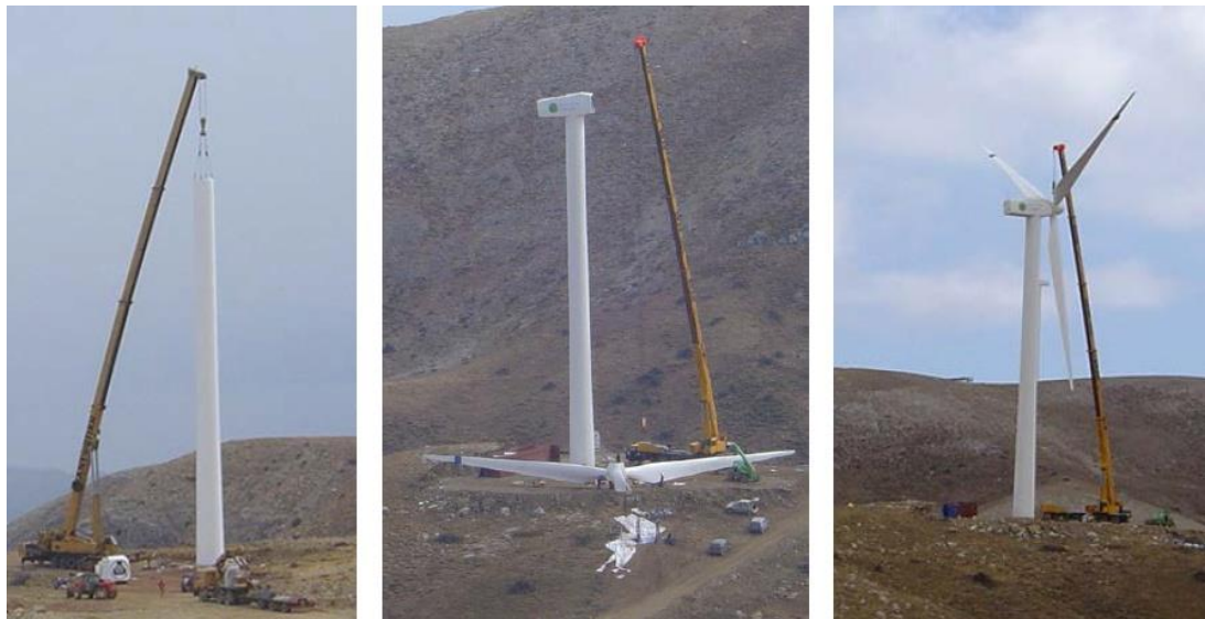
Εικόνα 5.5: Ανέγερση ανεμογεννητριών 850 kW.
