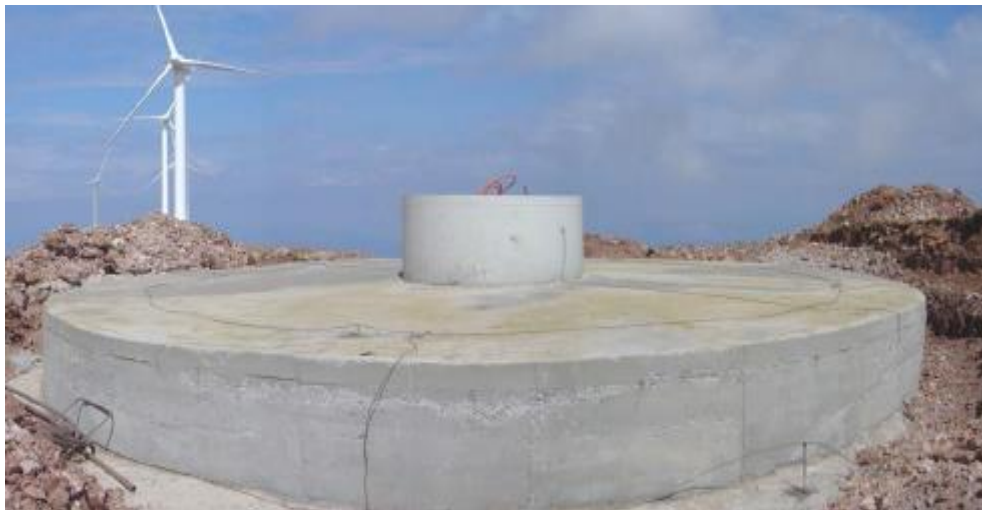
Εικόνα 5.3: Θεμελίωση ανεμογεννητριών.
