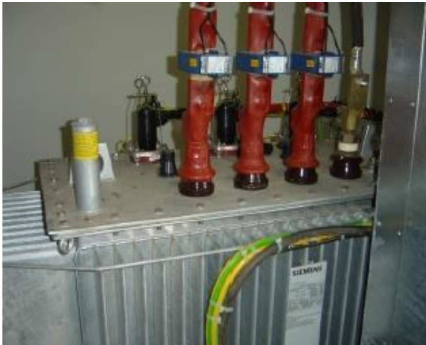
Εικόνα 5.7: Μετασχηματιστής.
