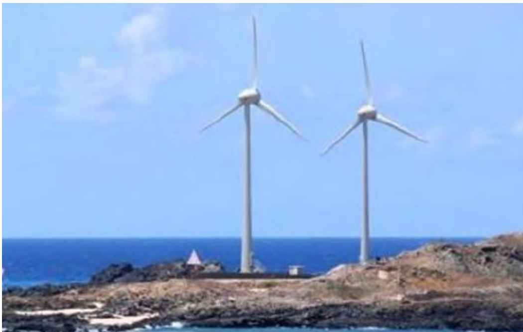
Εικόνα 4.2: Αιολικό πάρκο κοντά στην ακτή.
